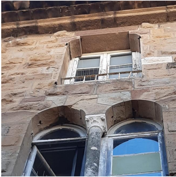
Gîtes utilisables au niveau des espacements des tuiles, pierres au niveau de la toiture et disjointements au niveau des fenêtres © G. Kapfer
