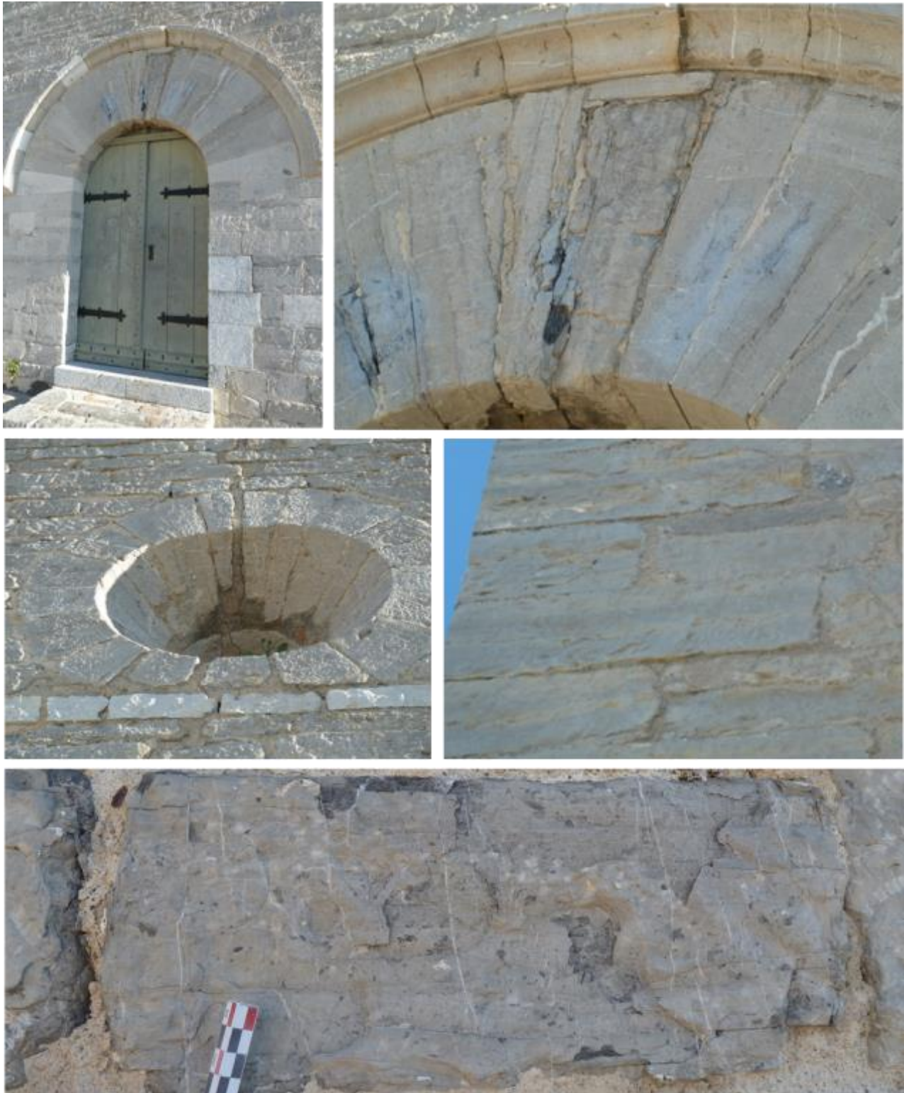
Vues de mise en œuvre extérieure des calcaires du Muschelkalk sur l'édifice :
