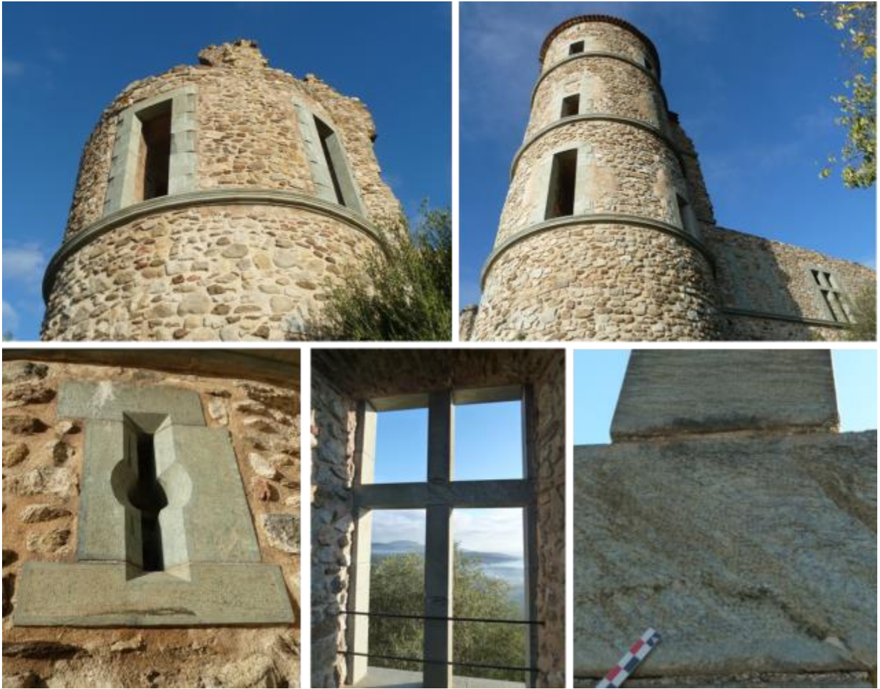
Vues de mise en œuvre (éléments restitués) de Serpentinite de Cavalaire (probable) sur l'édifice :
