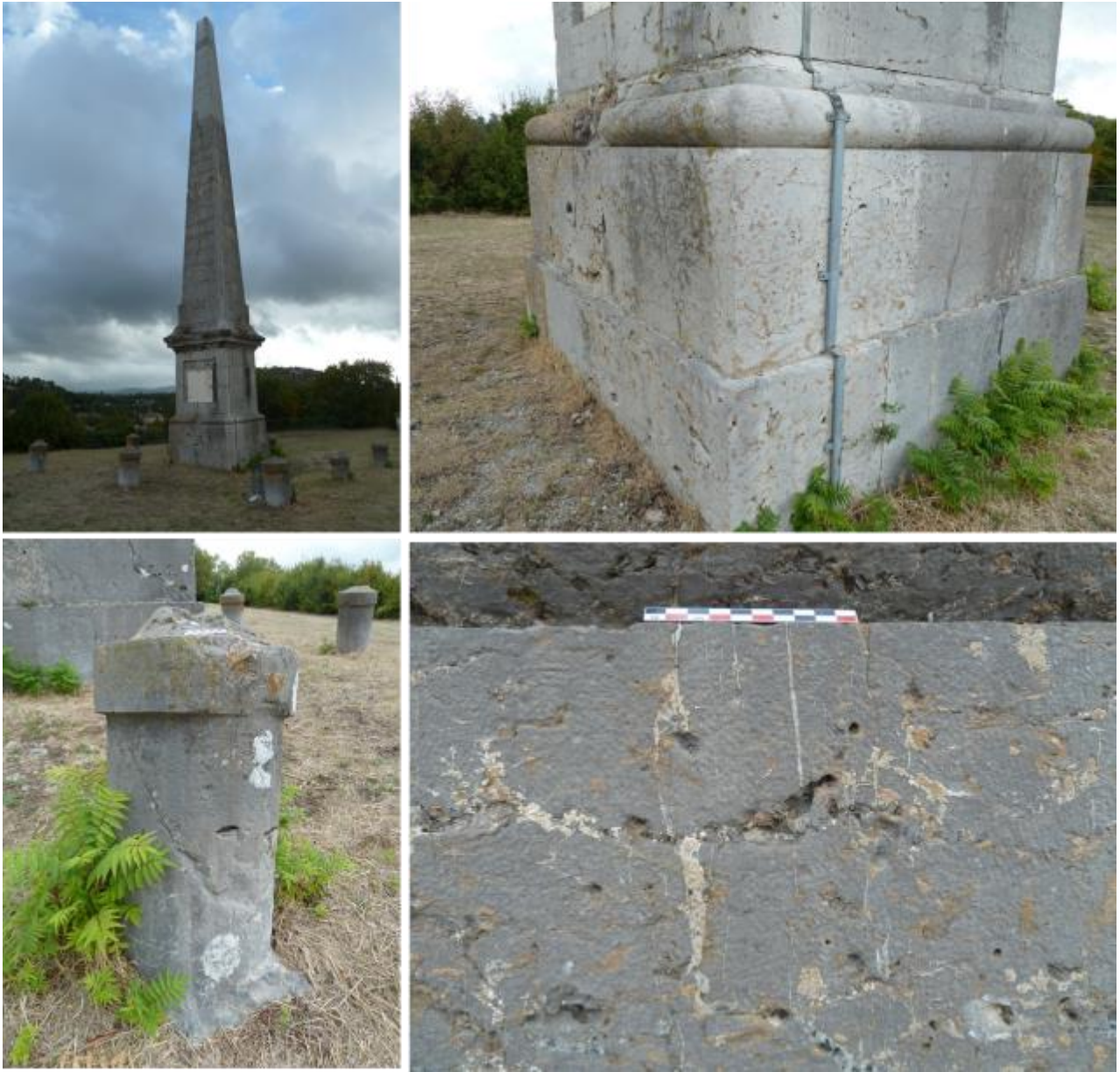
Vues de mise en œuvre des calcaires du Muschelkalk sur l'obélisque XVIII e siècle :
