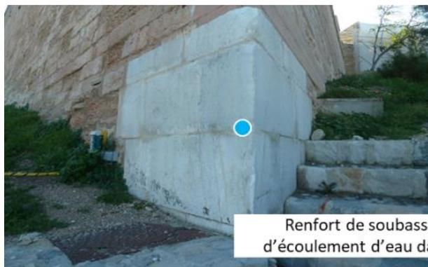
Renfort de soubassement et système d'écoulement d'eau dans le Bastion de l'Île
