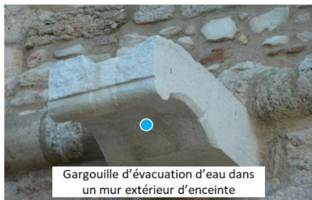
Gargouille d'évacuation d'eau dans un mur extérieur d'enceinte
