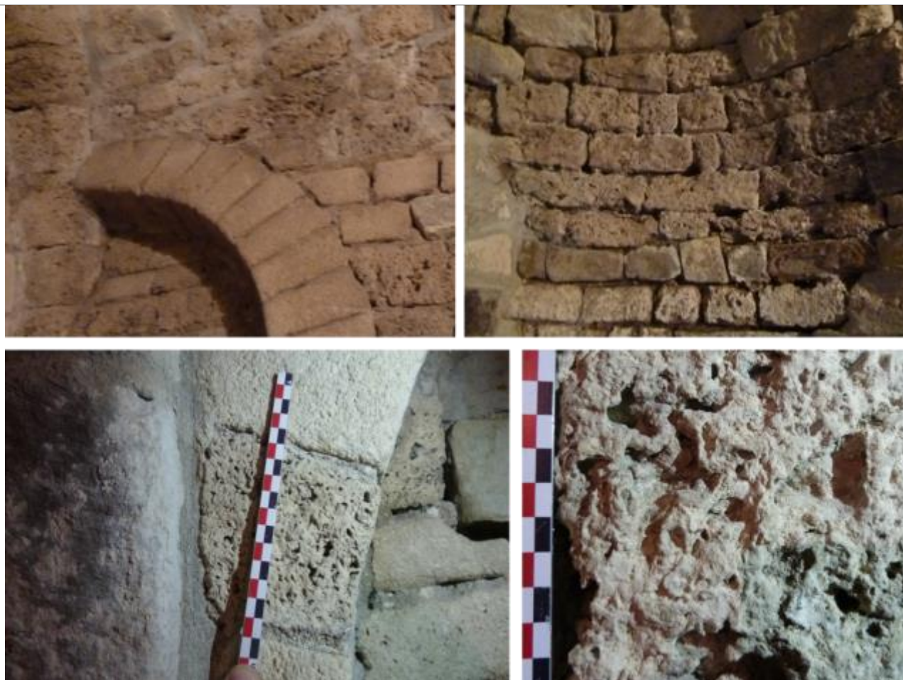
Vues du calcaire biodétritique dans son faciès très vacuolaire.
