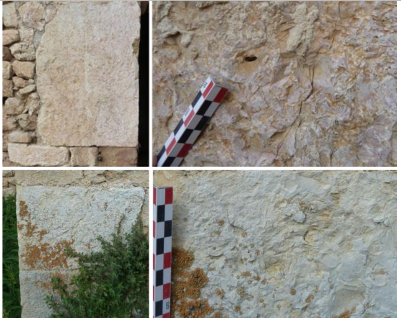
Vues de mise en œuvre du calcaire marmoréen dur et compact blanchâtre à beige-rosé à patine très claire.
