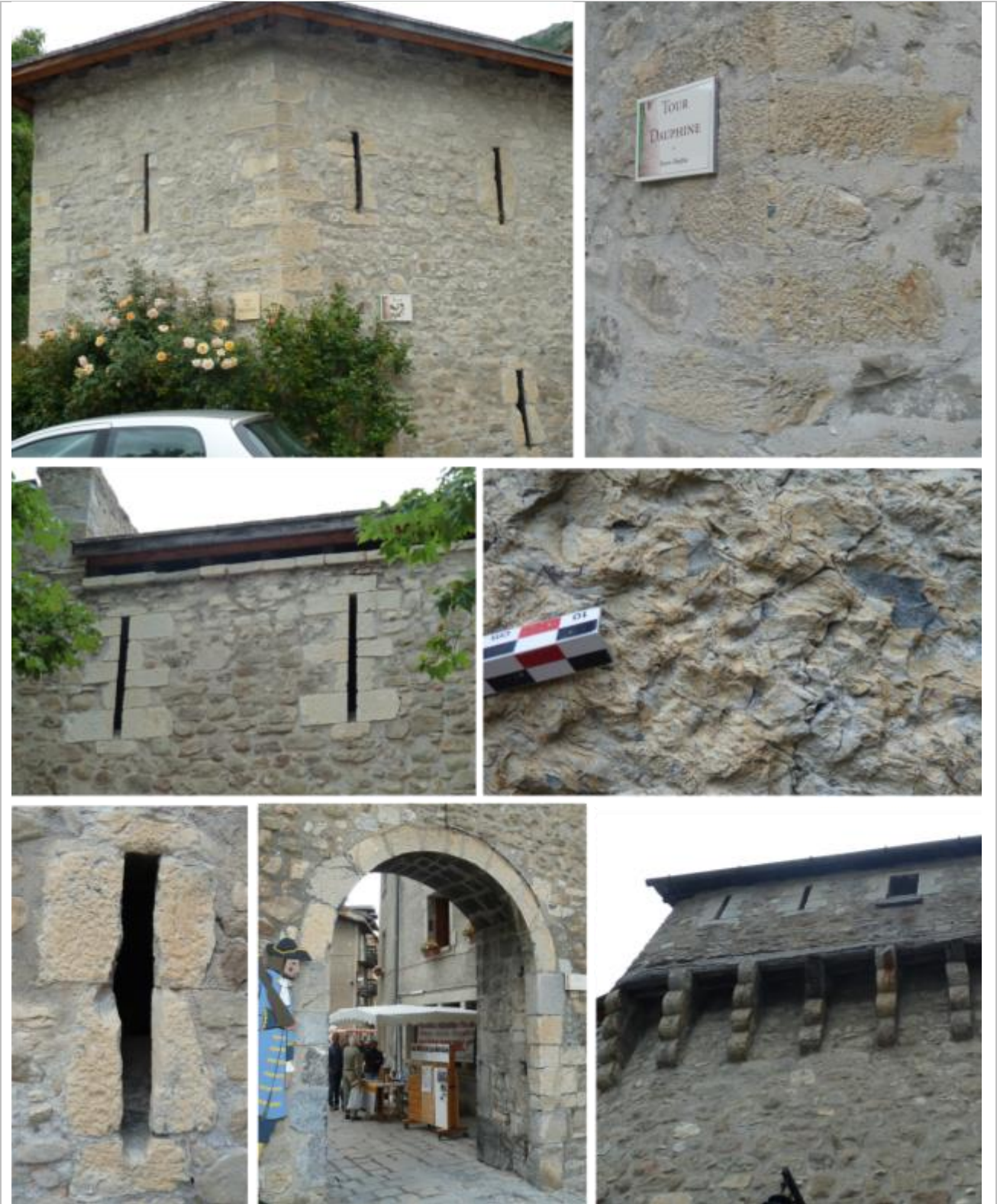
Vues de mise en œuvre du calcaire légèrement marneux gris-bleuté, à patine gris-clair ocreuse.
