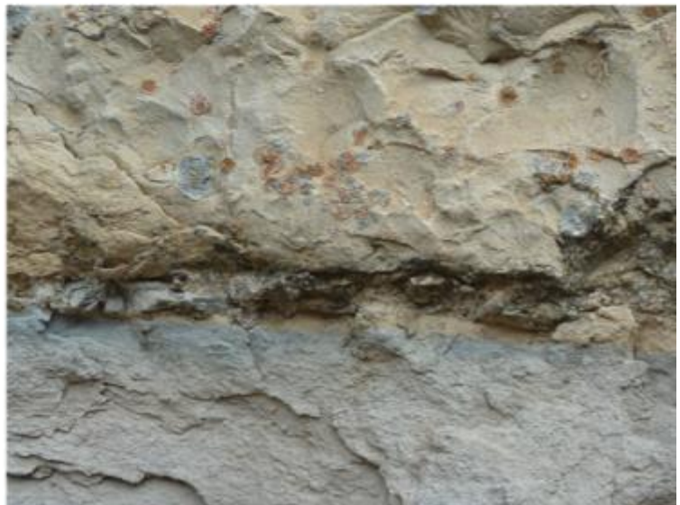
Vues du parement du donjon en calcaire plus ou moins marneux jaune ou gris (parfois bicolore) à grain très fin (Hauterivien).
