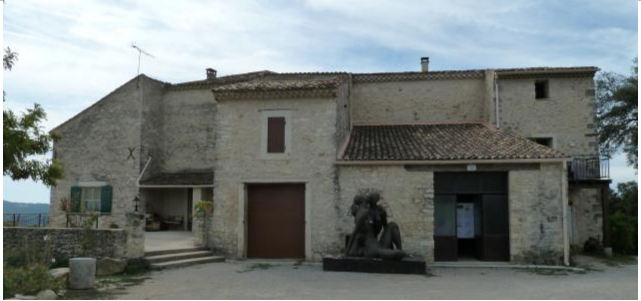
Vue d'ensemble de l'édifice.
