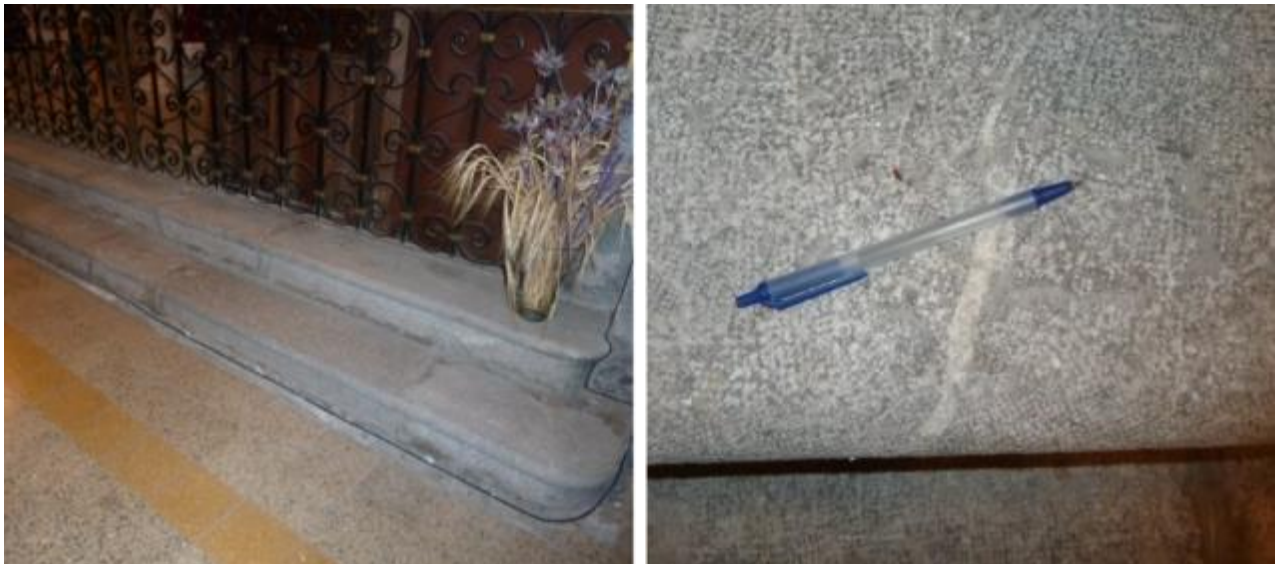
Vues des marches en calcaire marbrier gris à veines blanches de calcite.
