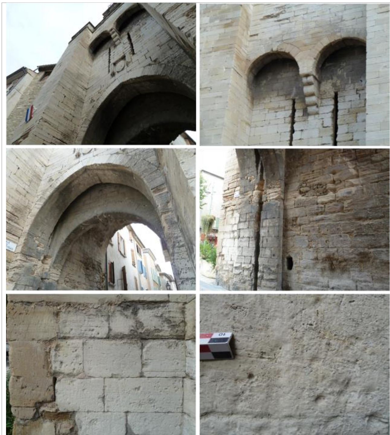
Vues de mise en œuvre du calcaire fin blanchâtre à beige-crème finement lité.
