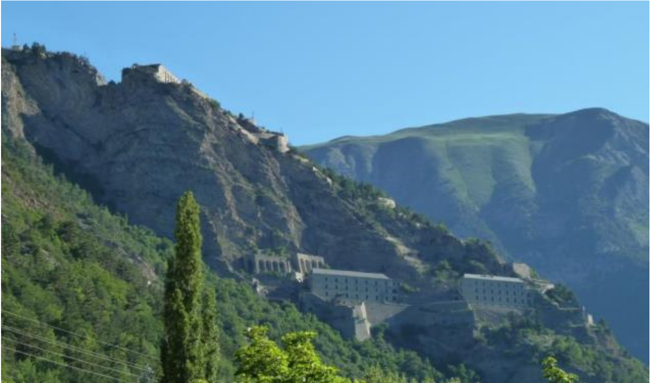
Vue d'ensemble de l'édifice.
