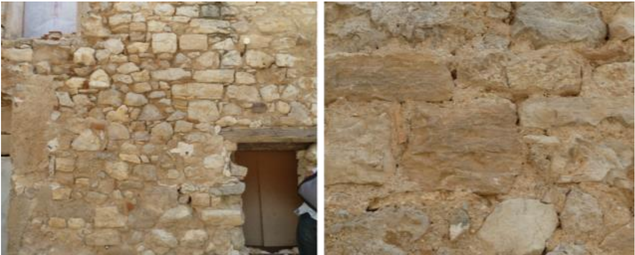
Vues des murs en moellons bruts essentiellement de calcaire fin blanchâtre à beige.
