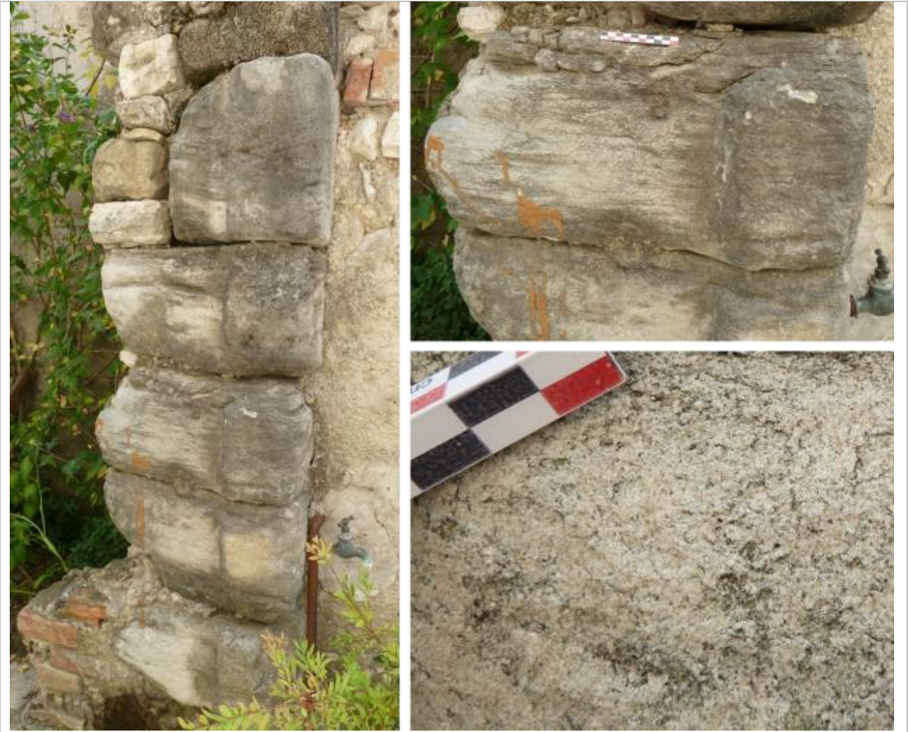
Vues de la mise en œuvre du grès beige-grisâtre à grain assez fin et litage apparent.
