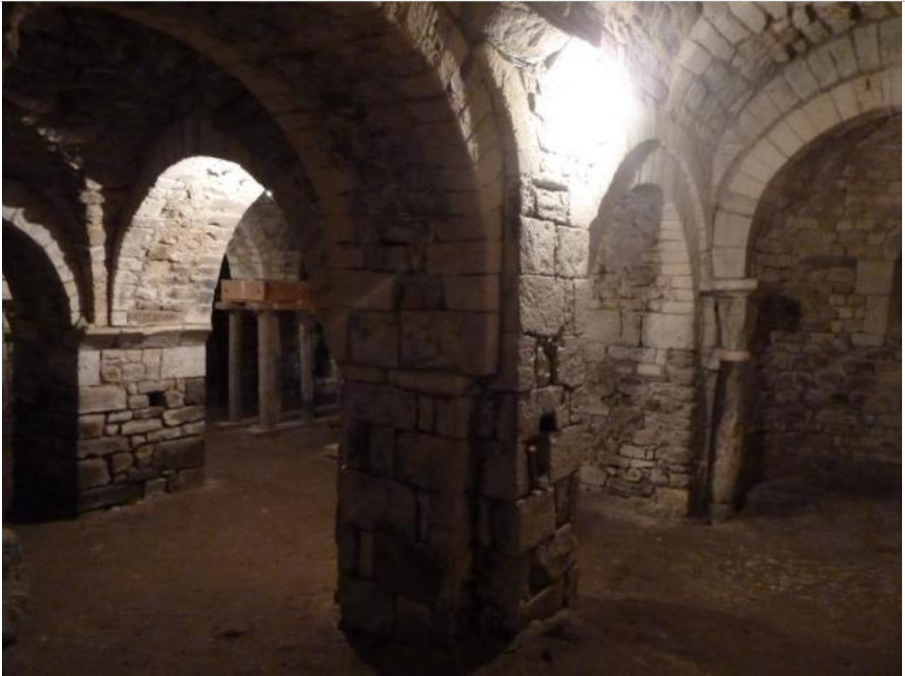
Vue partielle de l'édifice.
