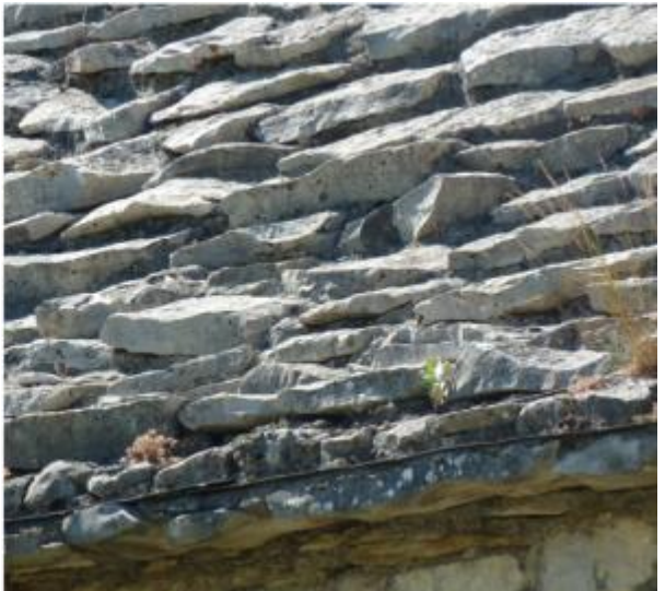
Vues de la couverture partiellement en lauze calcaire blanchâtre.
