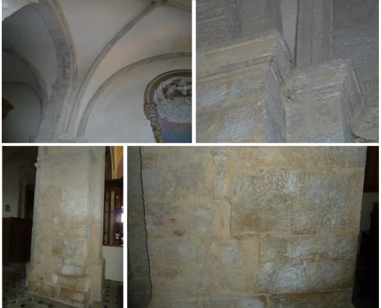
Vues intérieures de mise en œuvre du calcaire travertineux dur beige-ocre, perforé de cavités millimétriques à centimétriques.
