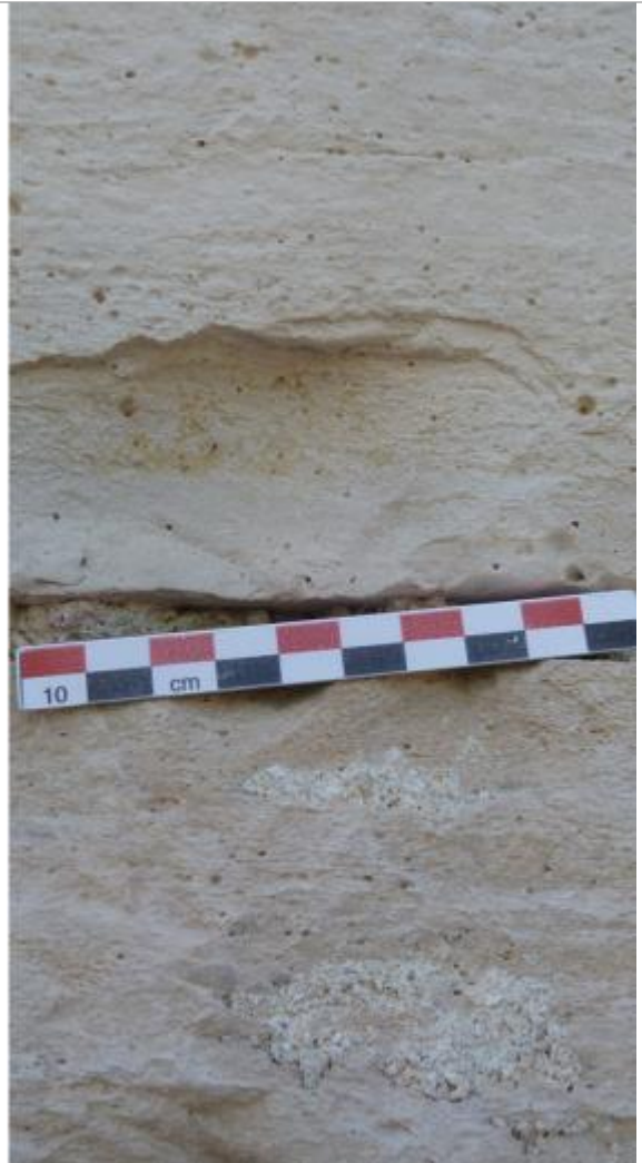
Vues de mise en œuvre des moellons allongés de calcaire beige légèrement marneux, à grain fin, finement lité (Pierre de Fontienne).
