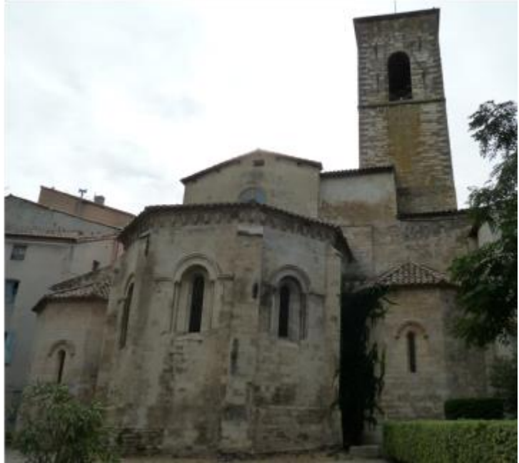
Vues d'ensemble de l'édifice.
