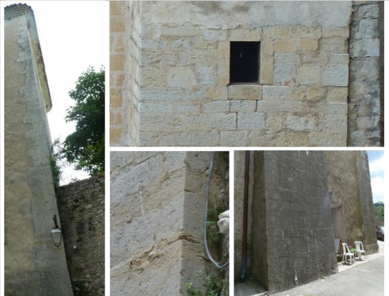
Vues de mise en œuvre au niveau du château du calcaire plus ou moins marneux jaune ou gris (parfois bicolore) à grain très fin (Hauterivien)
