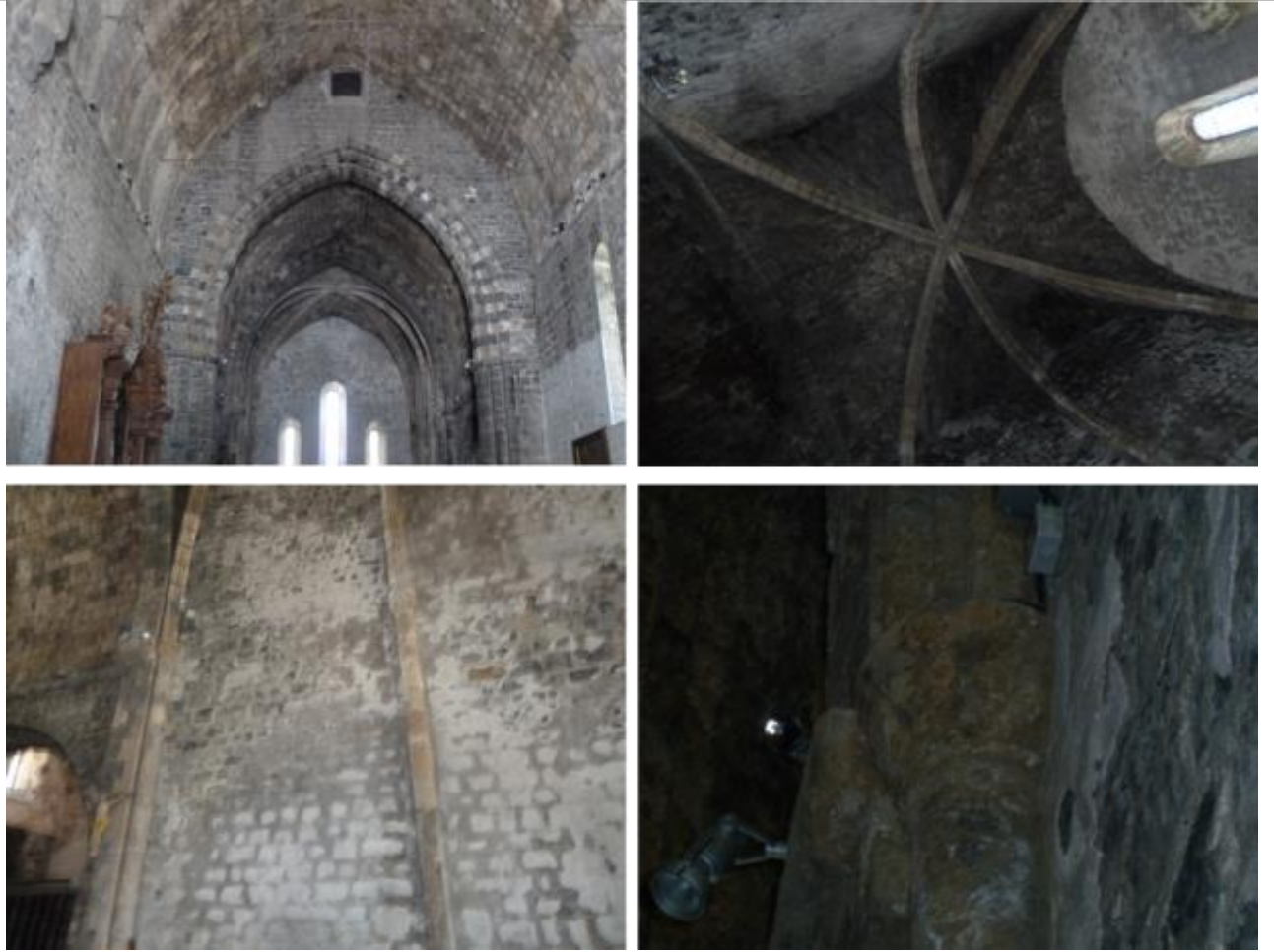
Vues des piliers latéraux et arcatures en calcaire dolomitisé beige-ocre fin et compact (parfois en alternance avec du calcaire noir - bichromie recherchée) et des voûtes en moellons plus vacuolaires et bréchiqe (cargneules).
