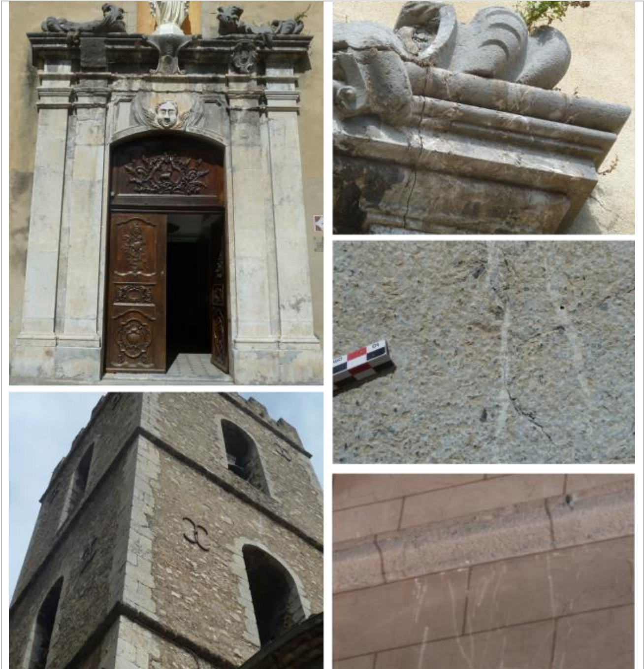
Vues de mise en œuvre du calcaire dur gris-brun à pâte fine (lithographique) à patine gris-clair (Tithonique).
