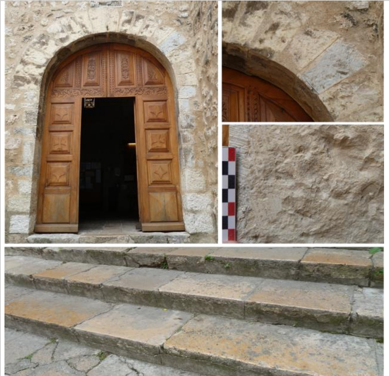
Vues de mise en œuvre du calcaire légèrement marneux jaune ou gris (parfois bicolore) à grain très fin et patine grisâtre (Hauterivien).
