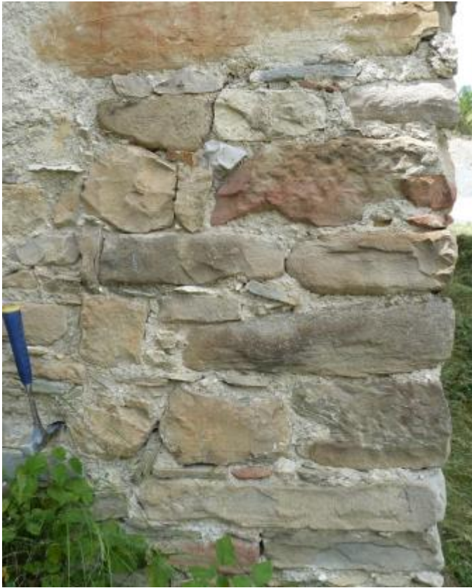
Vues des moellons en grès gris-brun-verdâtre à grain fin, à patine orangée à brune.
