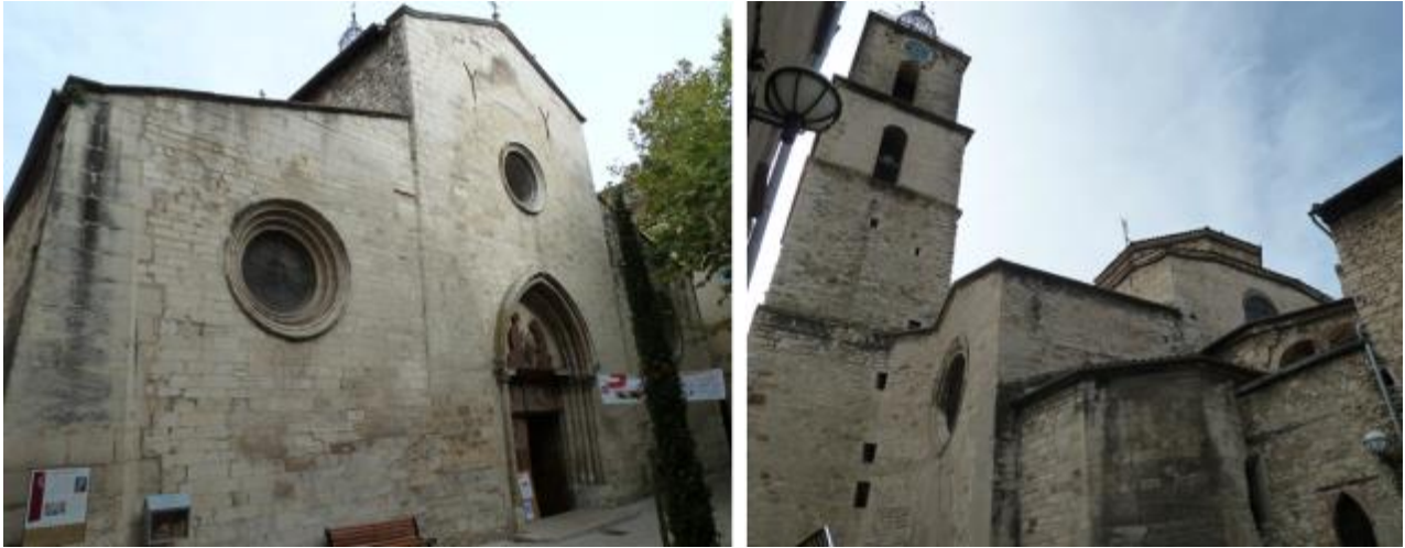
Vues d'ensemble de l'édifice.
