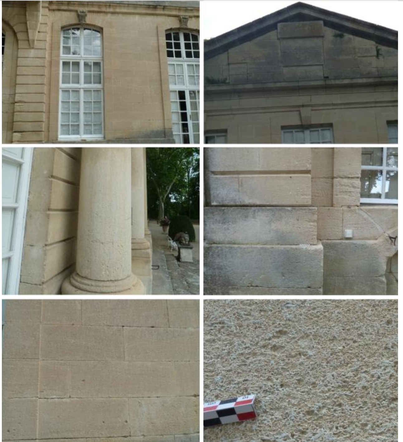
Vues de mise en œuvre du calcaire beige-clair biodétritique, à grain moyen à plus grossier assez homogène et léger litage (Pierre de Mane).
