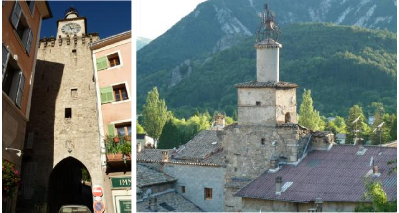
Vues d'ensemble de l'édifice.
