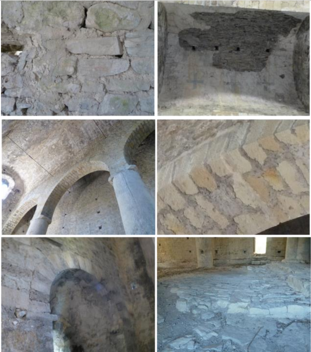
Vues intérieures de l'édifice avec mise en œuvre des grès verts, calcaire fin beige-verdâtre et tuf beige-crème.
