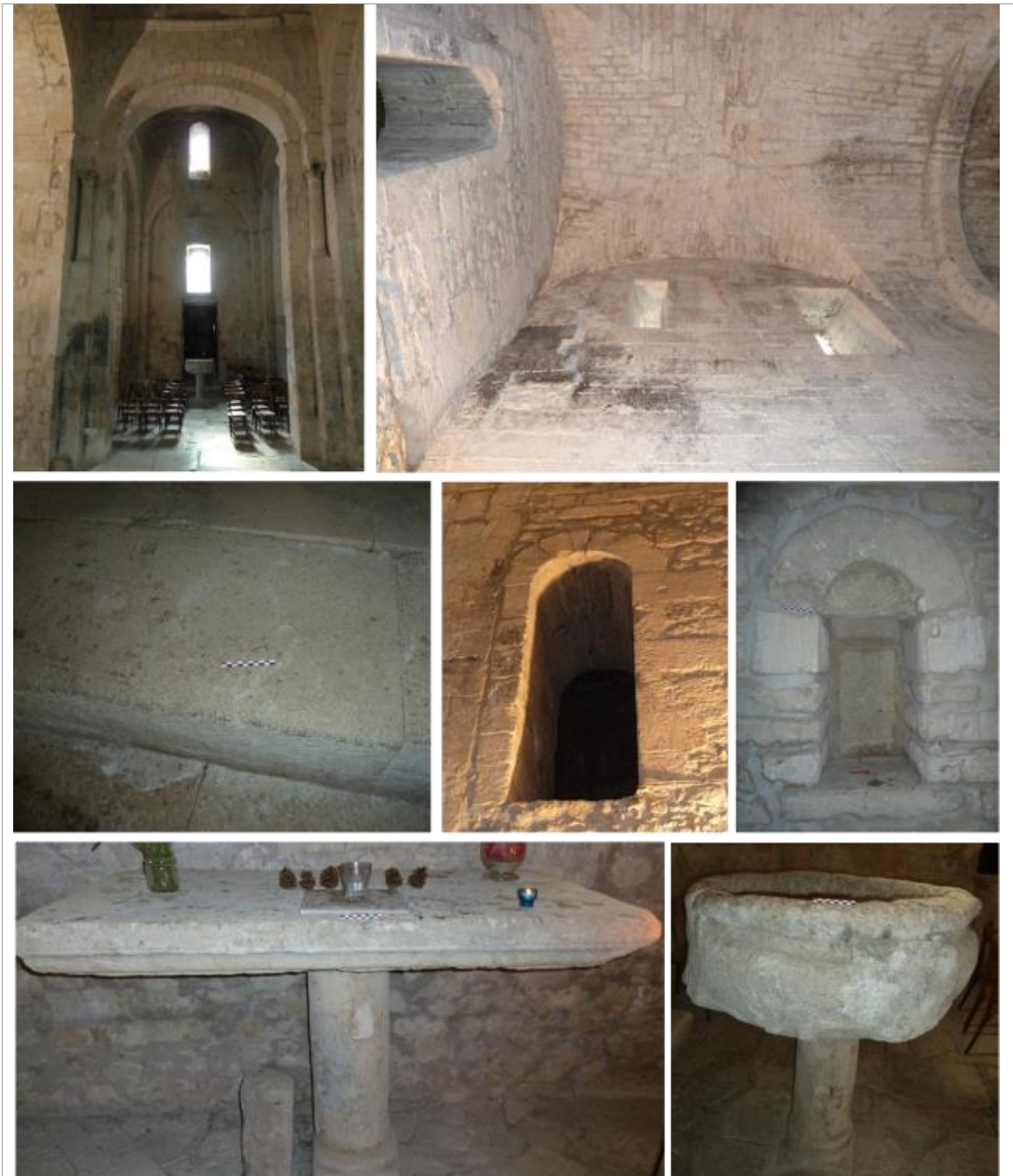
Vues intérieures de mise en œuvre extérieure du calcaire beige-clair biodétritique, à grain moyen à plus grossier assez homogène et léger litage (Pierre de Mane).
