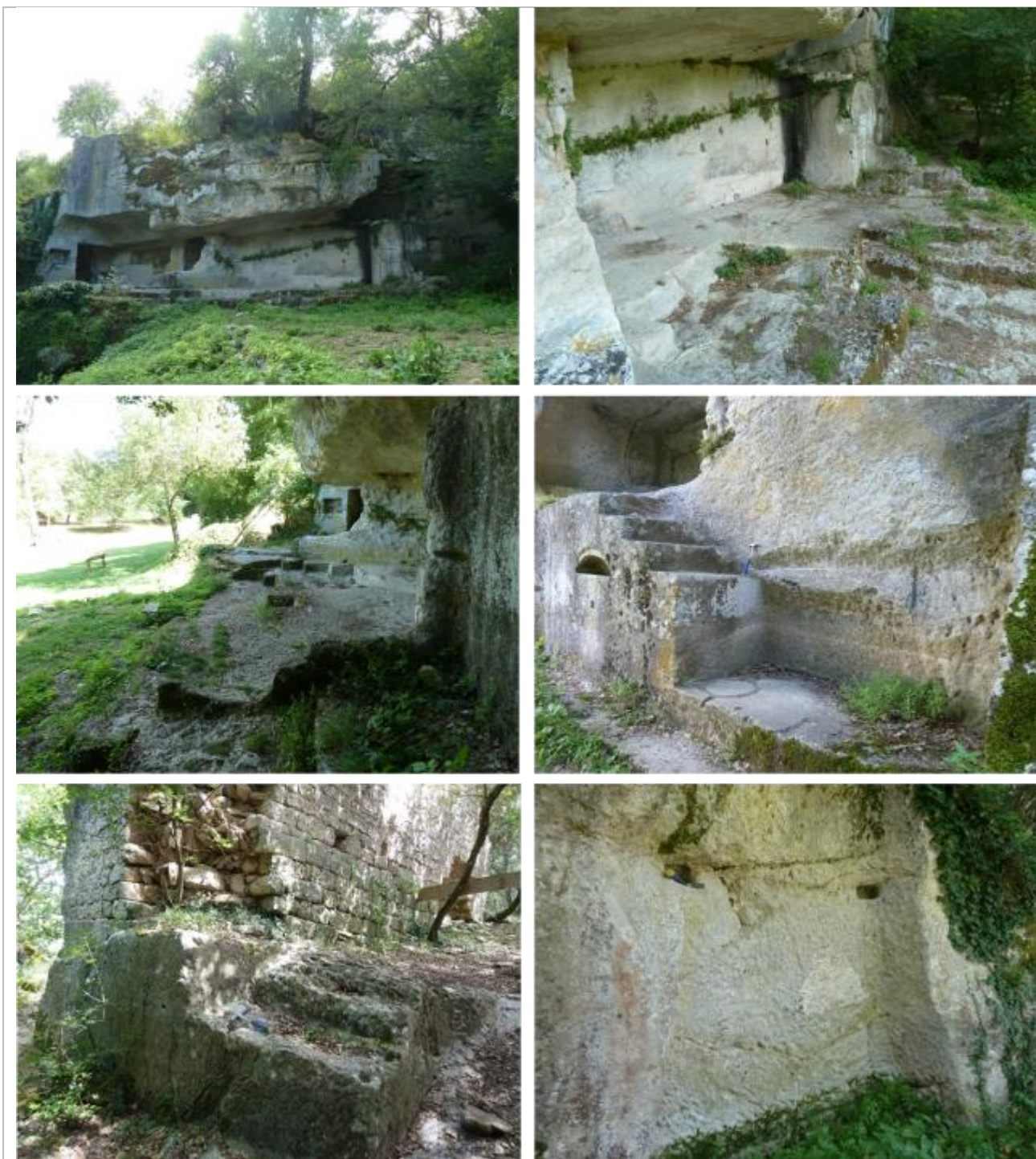
Vue de la carrière - aménagée et partie intégrante du prieuré - de calcaire biodétritique beige-blanchâtre (molasse) à grain moyen assez homogène.
