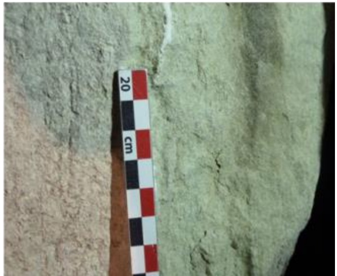
Vue des éléments taillés en calcaire gréseux glauconieux à grain fin, gris-beige-verdâtre, à patine grisâtre à brunâtre.
