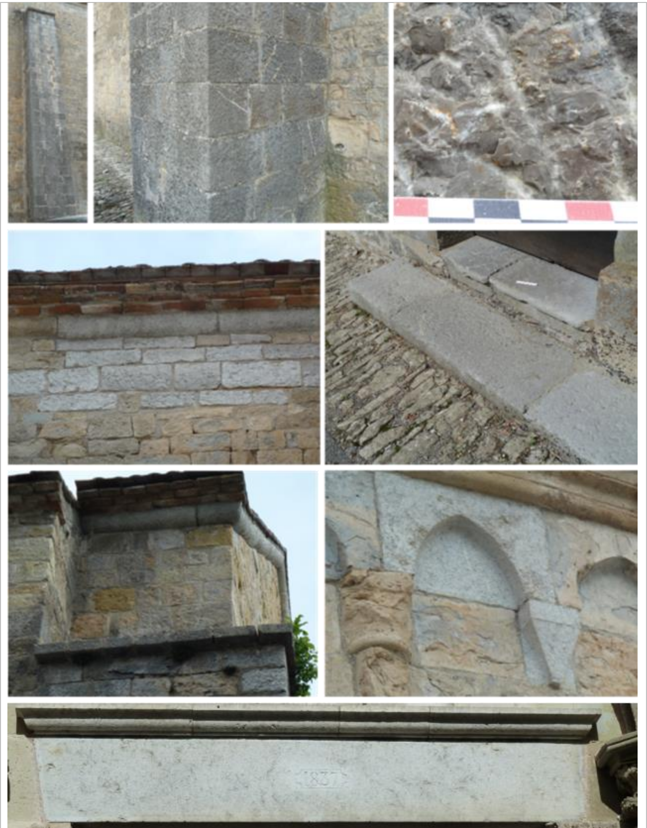
Vues de mise en œuvre extérieure du calcaire gris-brun à pâte fine, plus ou moins entrecoupés de veines blanches de calcite, à patine grise.
