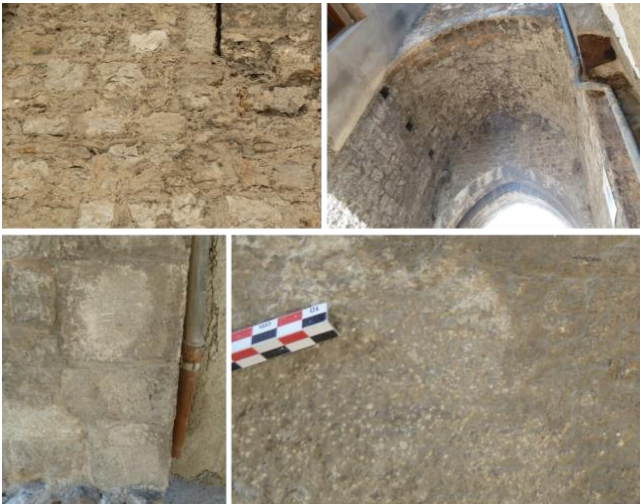
Vues de mise en œuvre du calcaire dur gris à brun, à pâte fine (sublithographique) à patine gris-clair.
