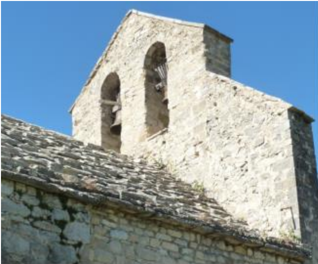
Vues de la couverture partiellement en lauze calcaire blanchâtre.
