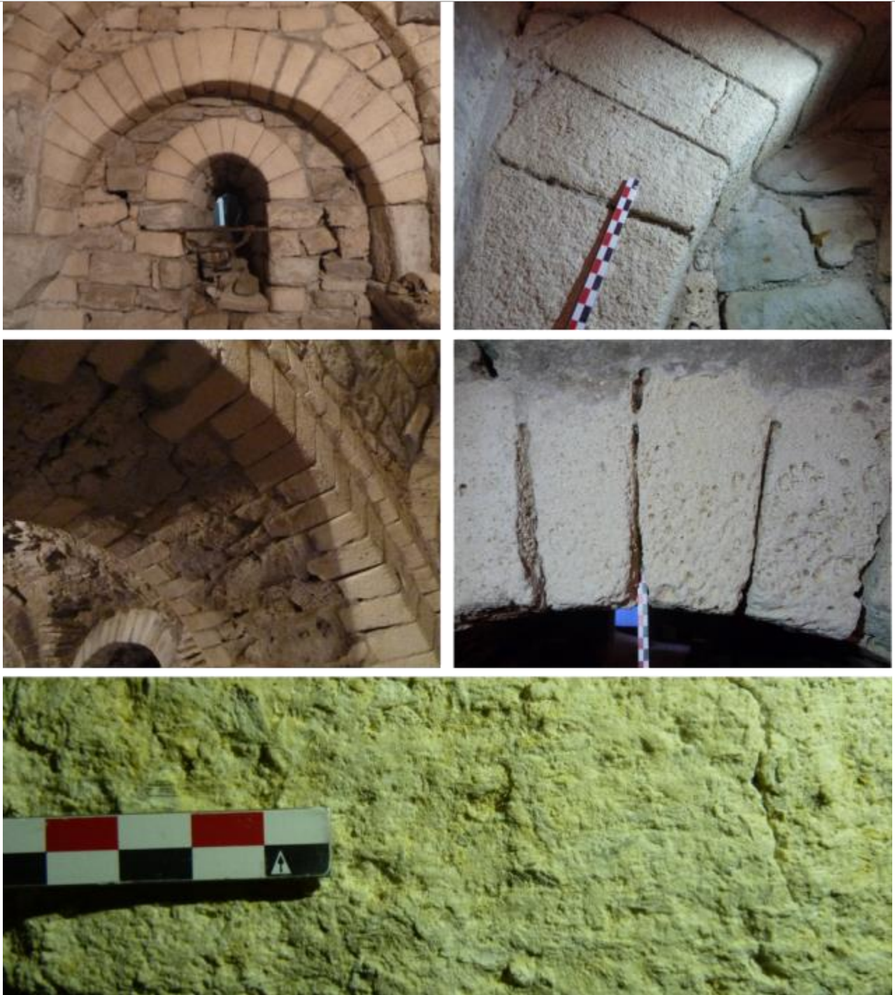
Vues du calcaire biodétritique beige-crème, parfois vacuolaire, assez tendre et poreux.
