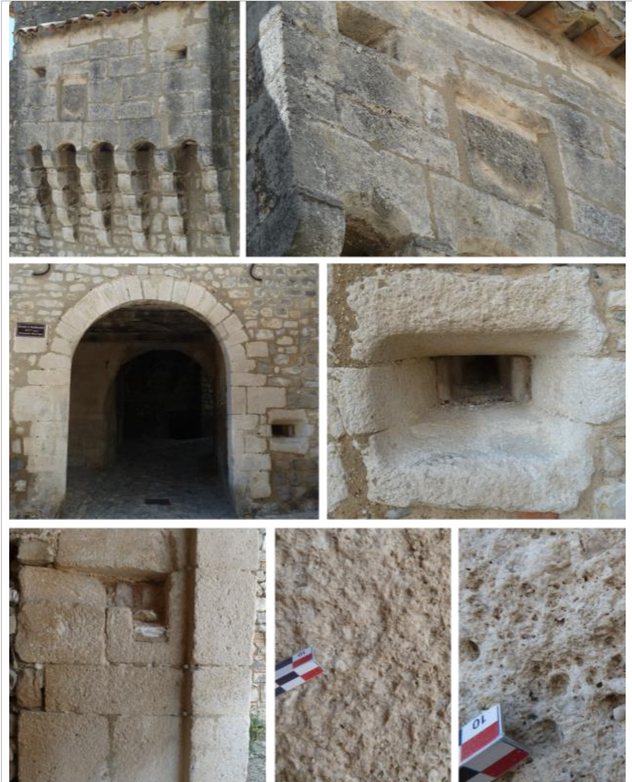
Vues de mise en œuvre des blocs taillés de calcaire dur blanchâtre, très bioclastique et finement vacuolaire, à grain assez grossier et à patine beige-crème.
