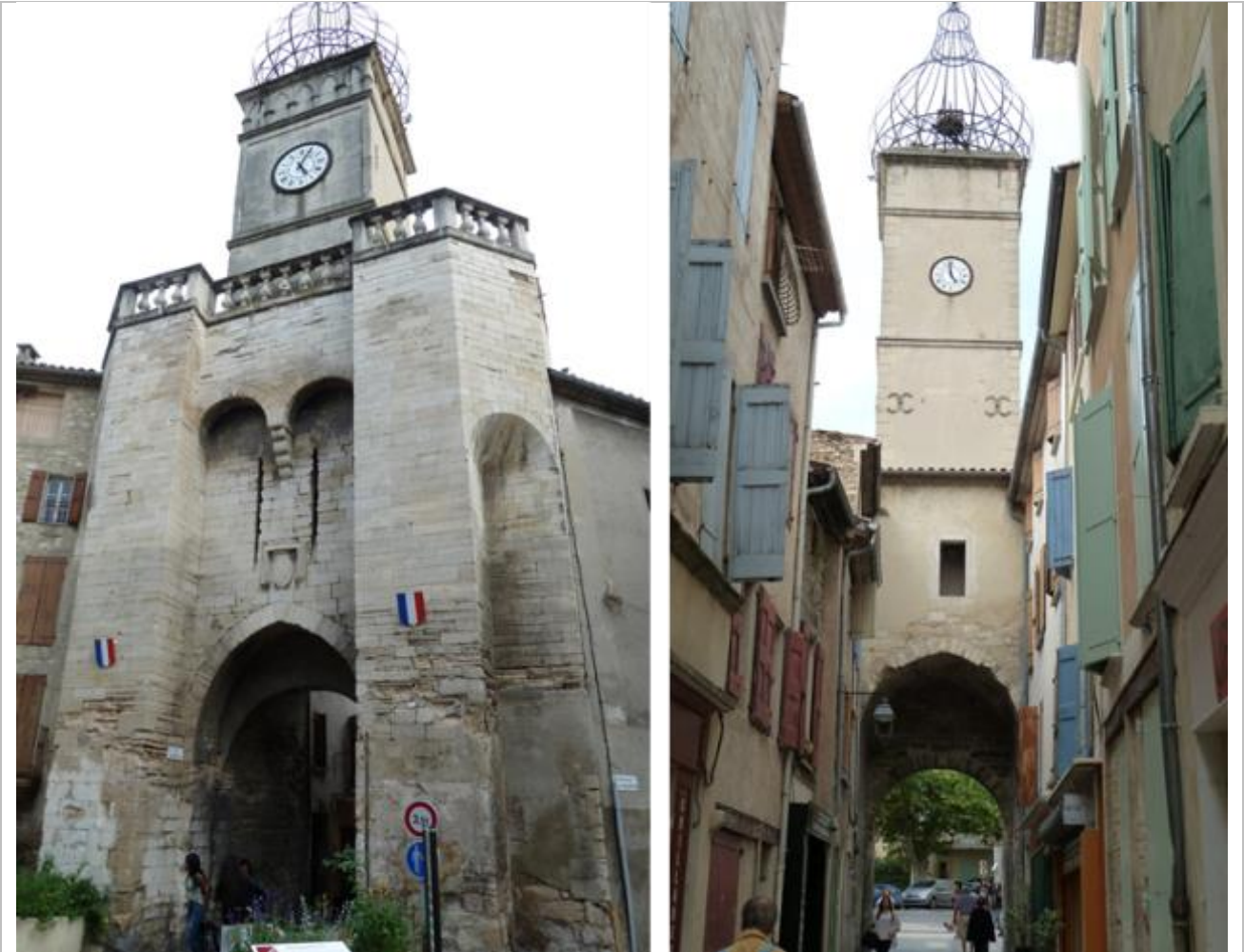
Vue d'ensemble de l'édifice.
