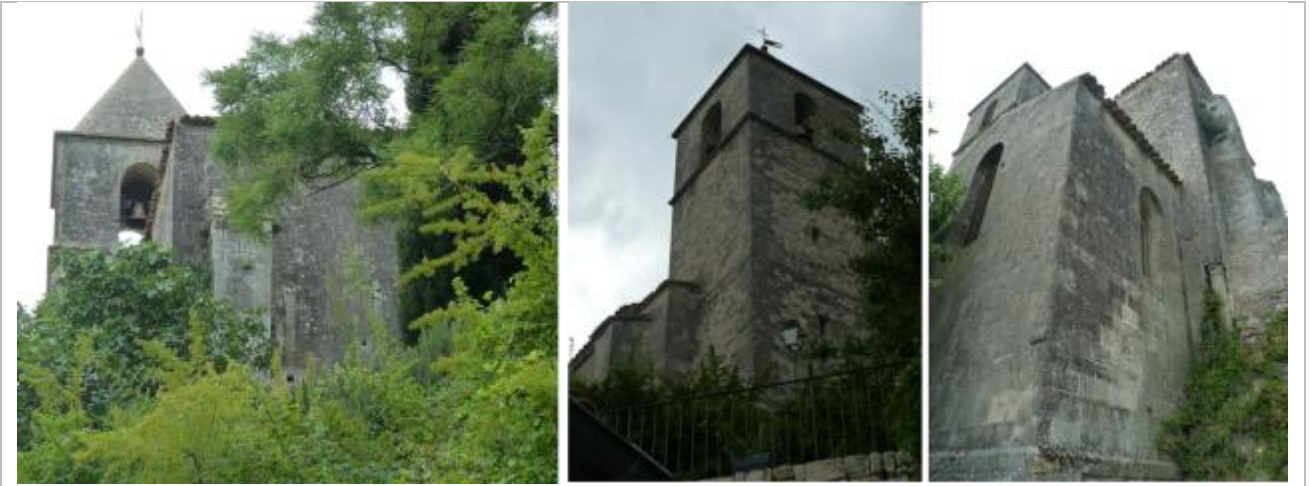
Vues d'ensemble de l'édifice.
