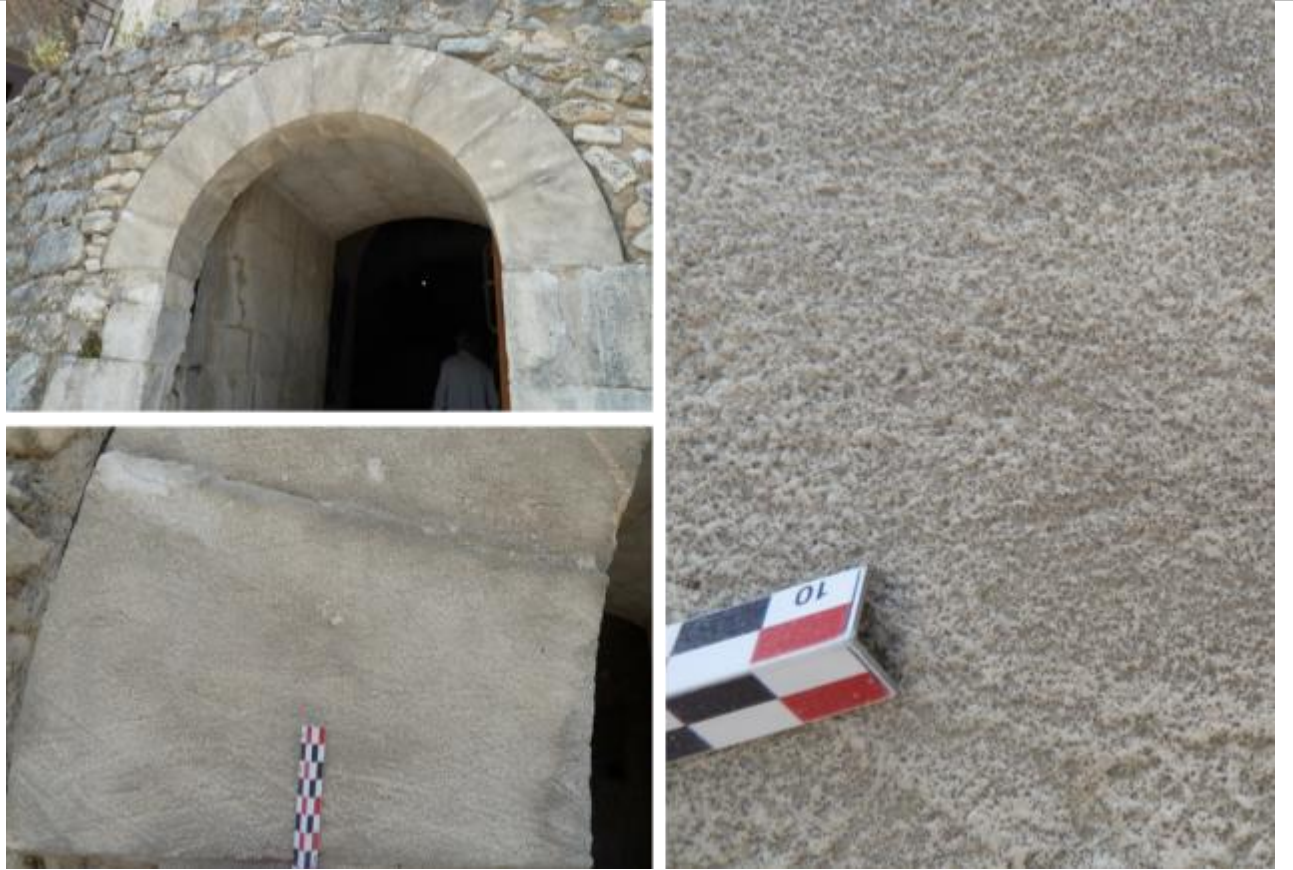
Vues de la restauration en Pierre de Lavoux au niveau de la porte du donjon.
