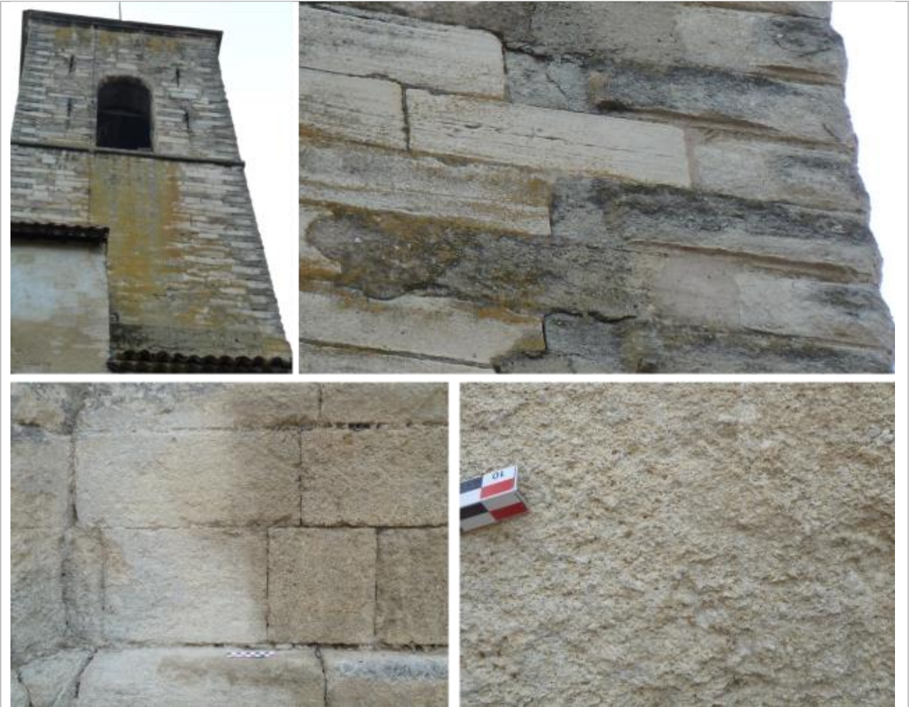
Vues extérieures de mise en œuvres du calcaire biodétritique assez tendre et poreux, de teinte beige à patine beige-grisâtre, à grain moyen à plus grossier et à aspect lité (Pierre de Mane).
