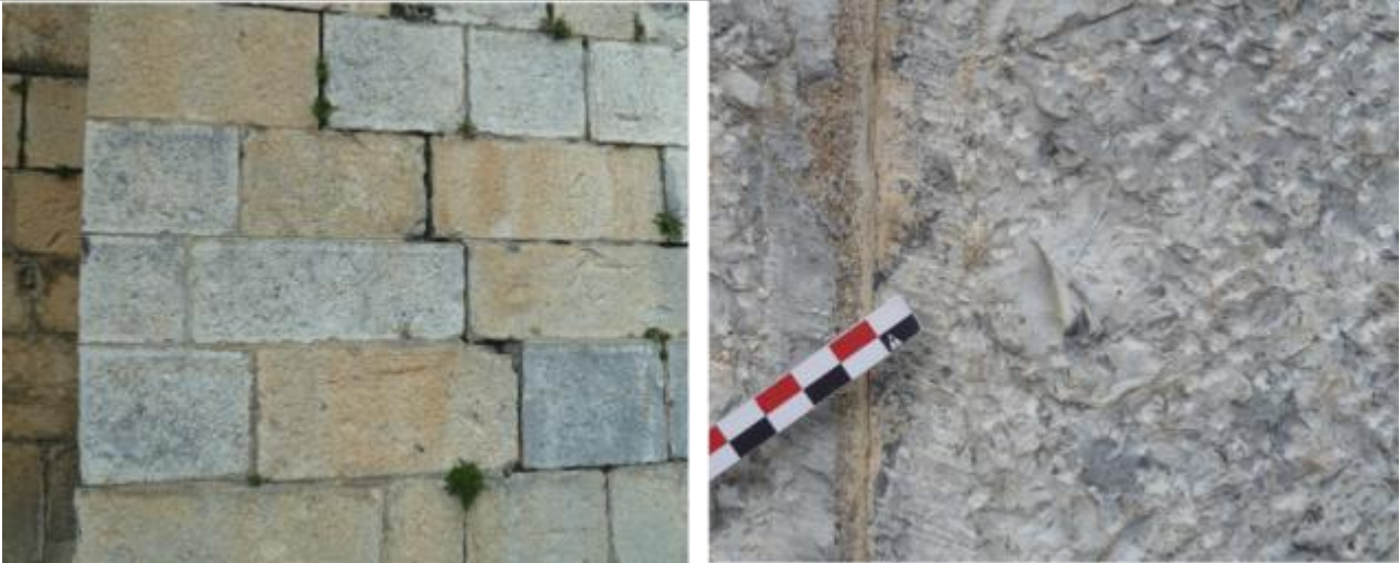
Vues du calcaire compact (marbrier) pseudo-bréchiq ue gris-brun, différenciable par une patine gris-bleu (restauration en Pierre de Ruoms ?).
