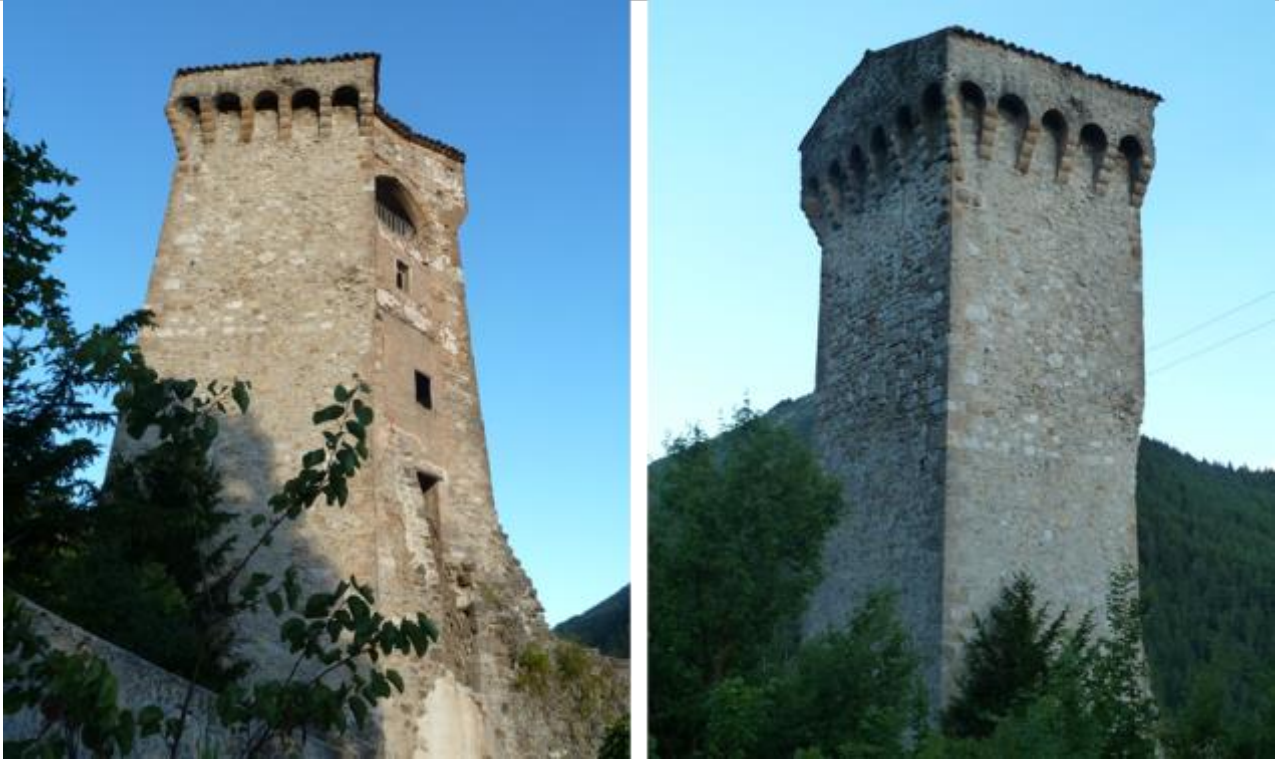
Vues d'ensemble de l'édifice.
