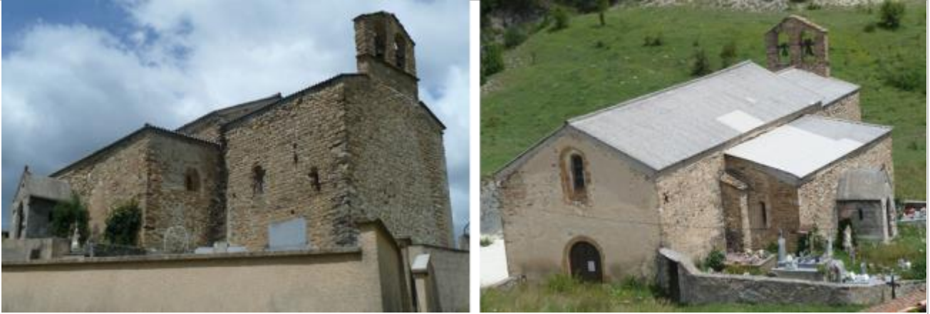
Vue d'ensemble de l'édifice.
