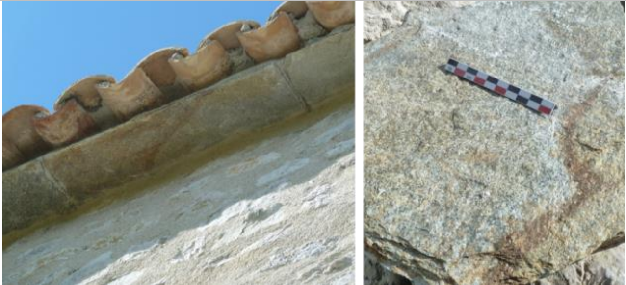
Vues de la mise en œuvre (restauration) de Gneiss gris-mordoré.
