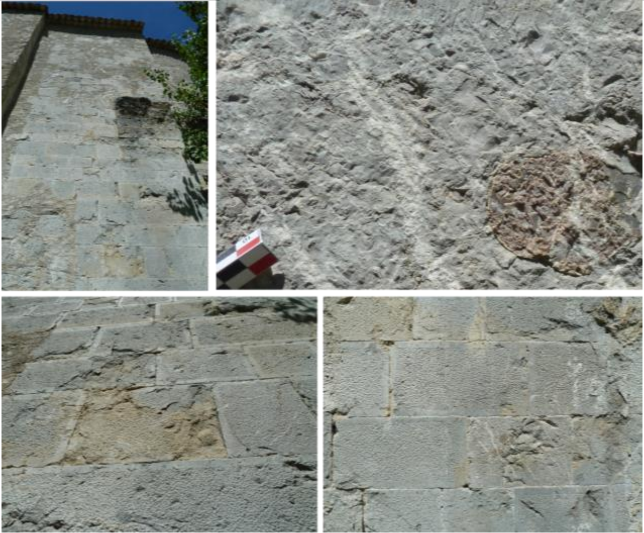
Vues de mise en œuvre du calcaire dur gris-brun à pâte fine (lithographique) à patine gris-clair (Tithonique).
