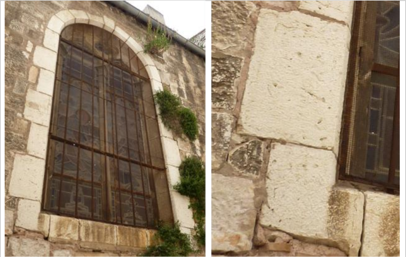
Vues de mise en œuvre du calcaire marmoréen blanchâtre à patine très claire (Portlandien-Berriasien).
