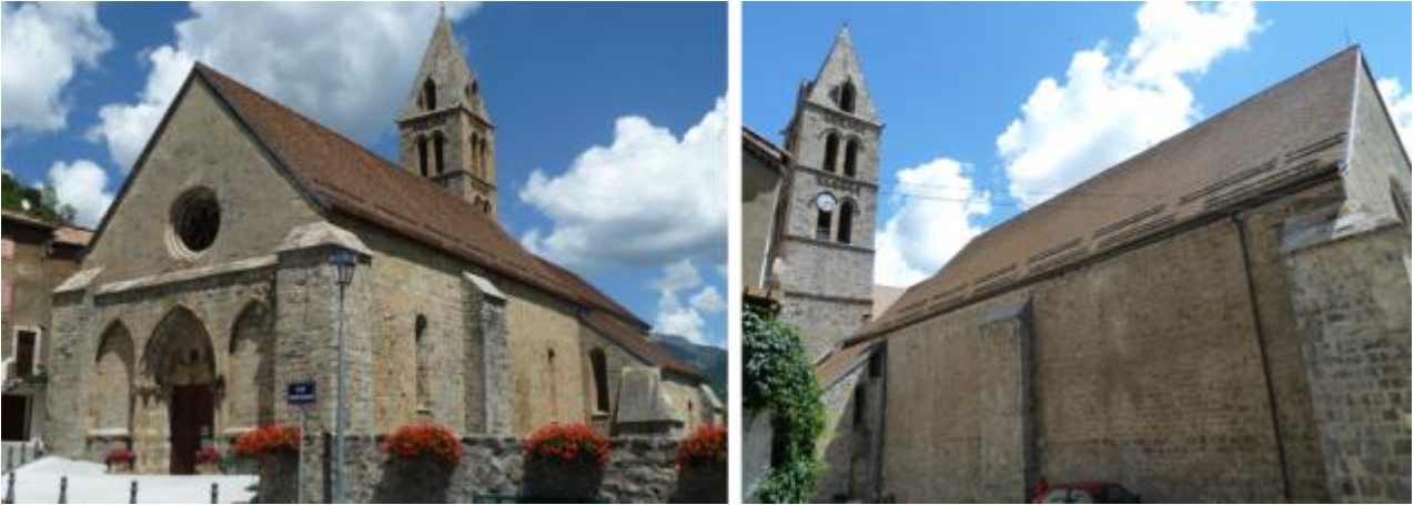
Vues d'ensemble de l'édifice.
