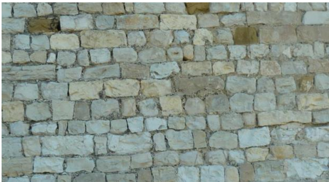
Vues des murs en moellons plus ou moins équarris, majoritairement en calcaire dur gris-clair à pâte fine, à patine blanchâtre et à débit prismatique.
