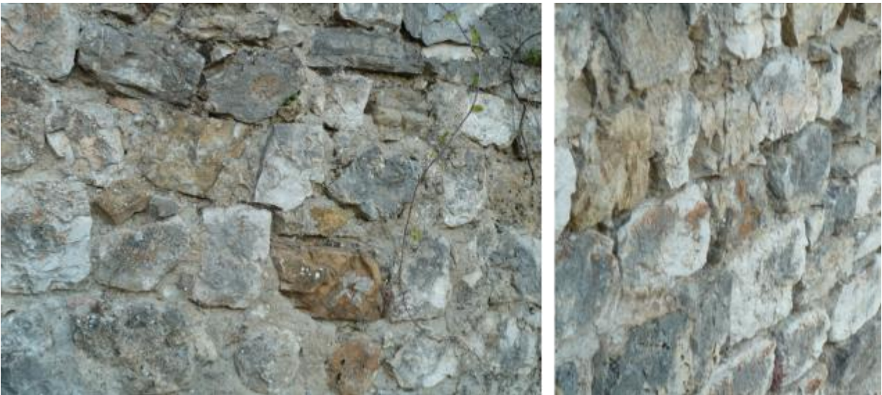
Vues des moellons de divers types de roches calcaires essentiellement, de provenance locale.
