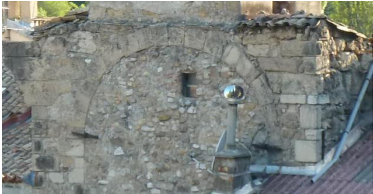
Vue des blocs de moyen appareil assisés, à bossage pour certains, en grès d'Annot ?
