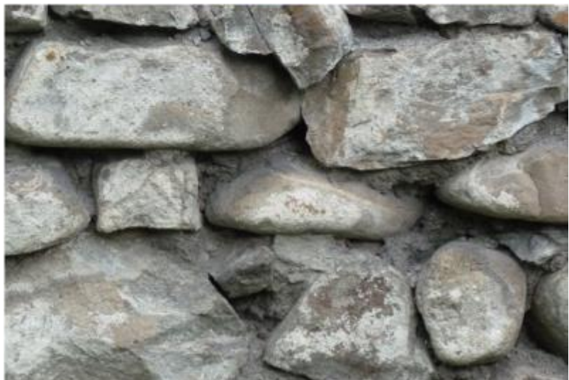
Vues des murs en petits moellons irréguliers et galets formant un tout-venant de divers types de roches d'origine locale.
