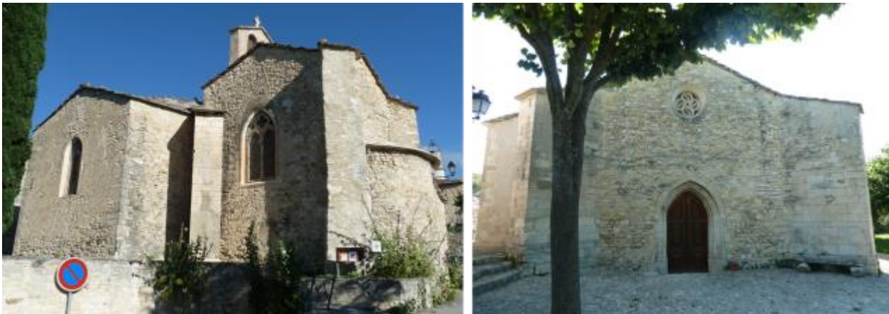
Vues d'ensemble de l'édifice.
