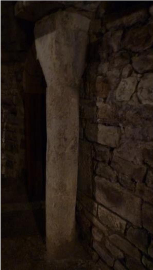
Vue des éléments taillés en calcaire gréseux glauconieux à grain fin, gris-beige-verdâtre, à patine grisâtre à brunâtre.
