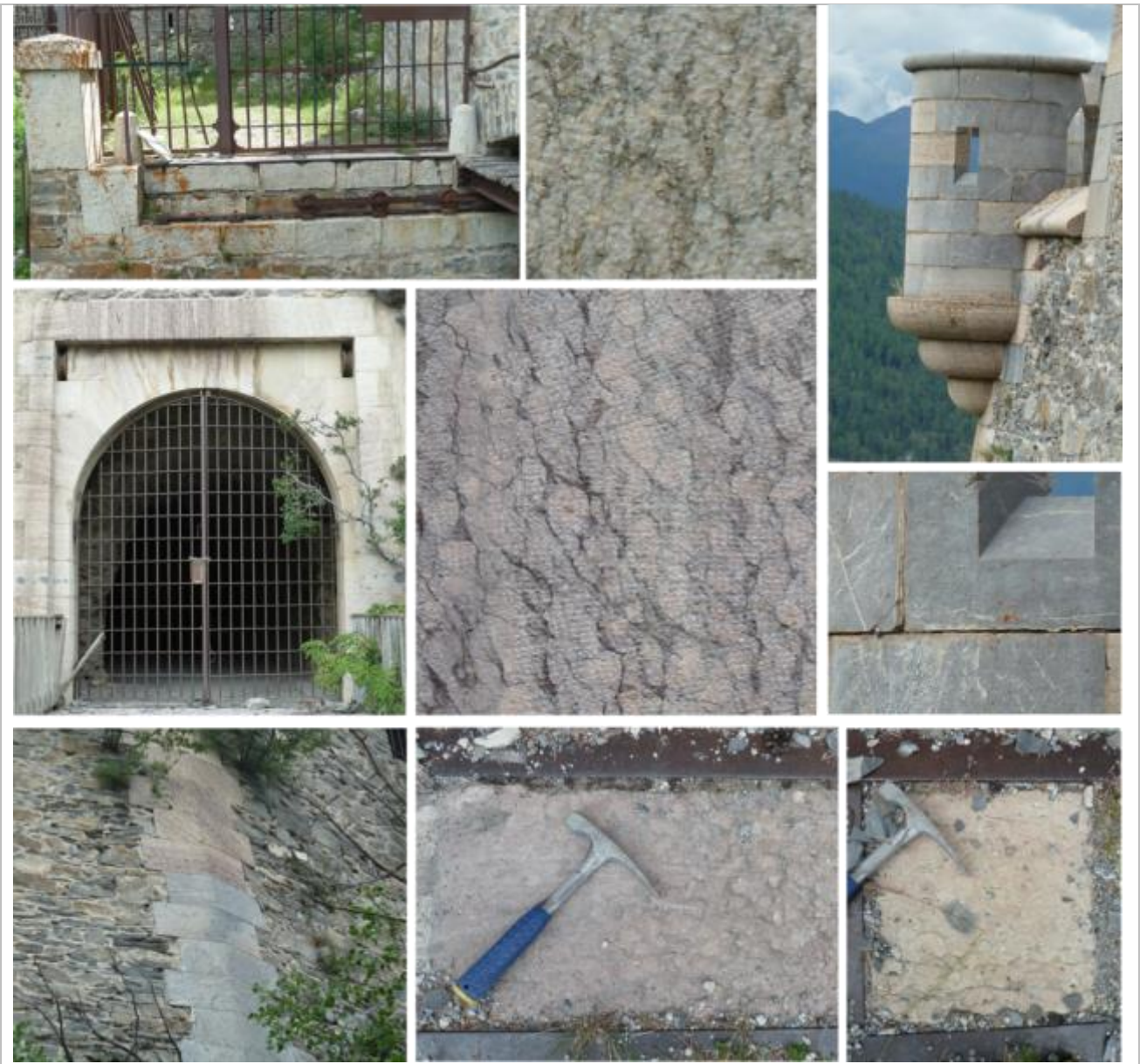
Vues des murs en moellons de calcaire à patine gris-bleuté et des grès à patine beige-orangé.
