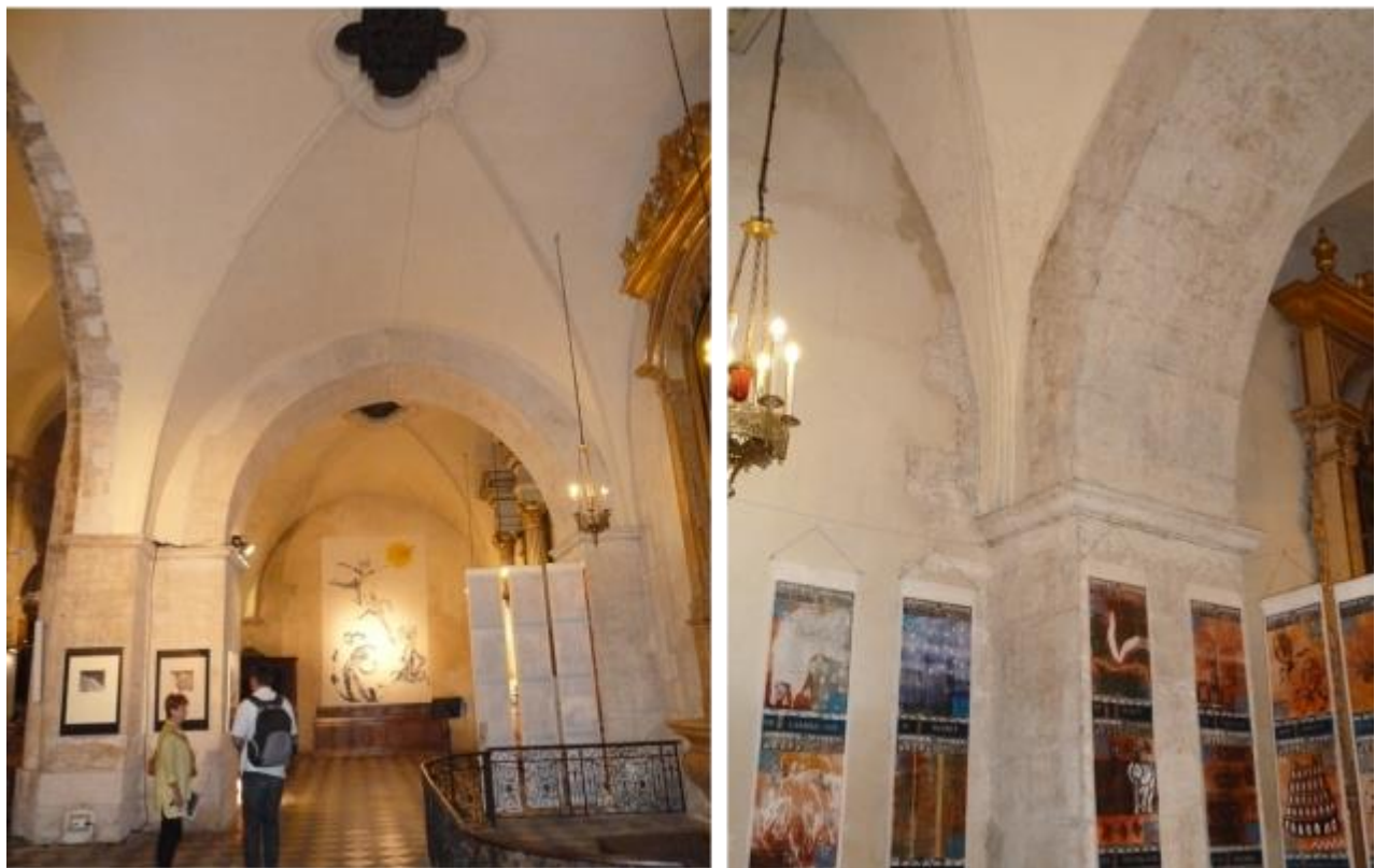
Vues intérieures de mise en œuvres du calcaire biodétritique assez tendre et poreux, de teinte beige à patine beige-grisâtre, à grain moyen à plus grossier et à aspect lité (Pierre de Mane).
