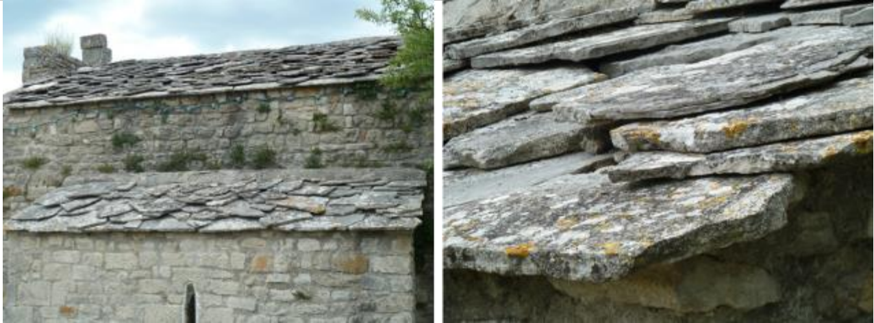
Chapelle : vues de la couverture en lauzes d'un calcaire fin blanchâtre finement lité.
