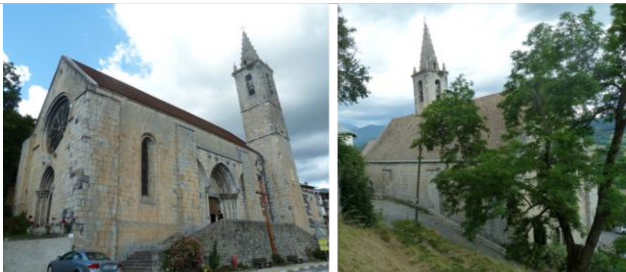
Vues d'ensemble de l'édifice.
