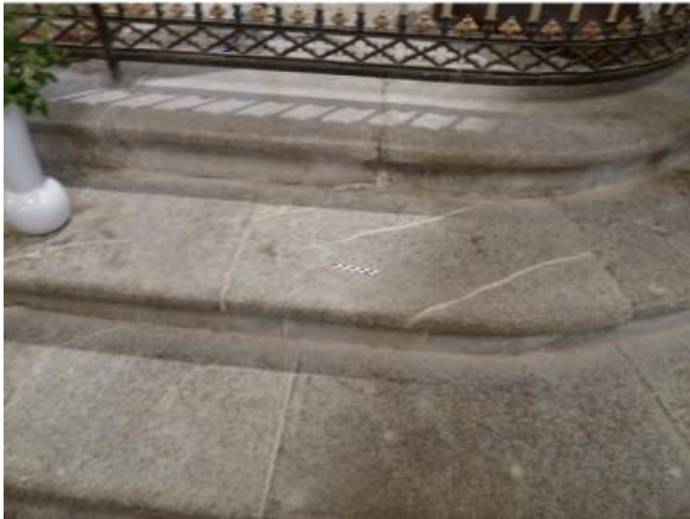
Vues de mise en œuvre intérieure du calcaire gris-brun à pâte fine, plus ou moins entrecoupés de veines blanches de calcite.
