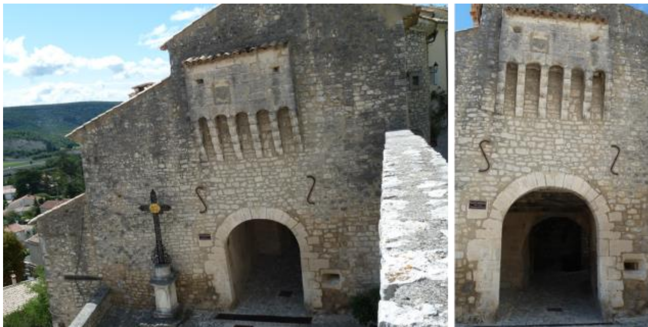
Vues d'ensemble de l'édifice.
