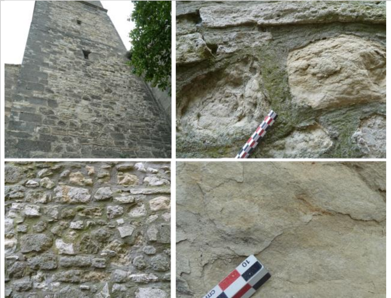
Vues des moellons épars en calcaire sablo-marneux gris-beige-verdâtre, très tendre et altérable (en mélange avec des moellons de Pierre de Mane).
