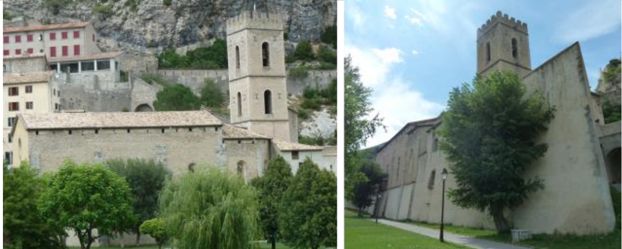
Vues d'ensemble de l'édifice.
