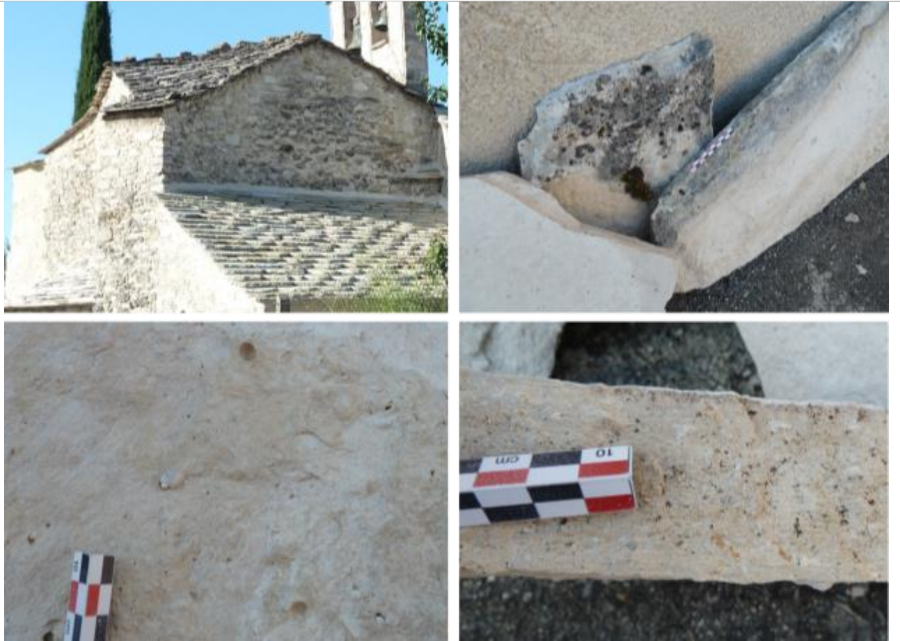
Vues de mise en œuvre des lauzes de calcaire beige légèrement marneux, à grain fin, finement lité (Pierre de Fontienne).
