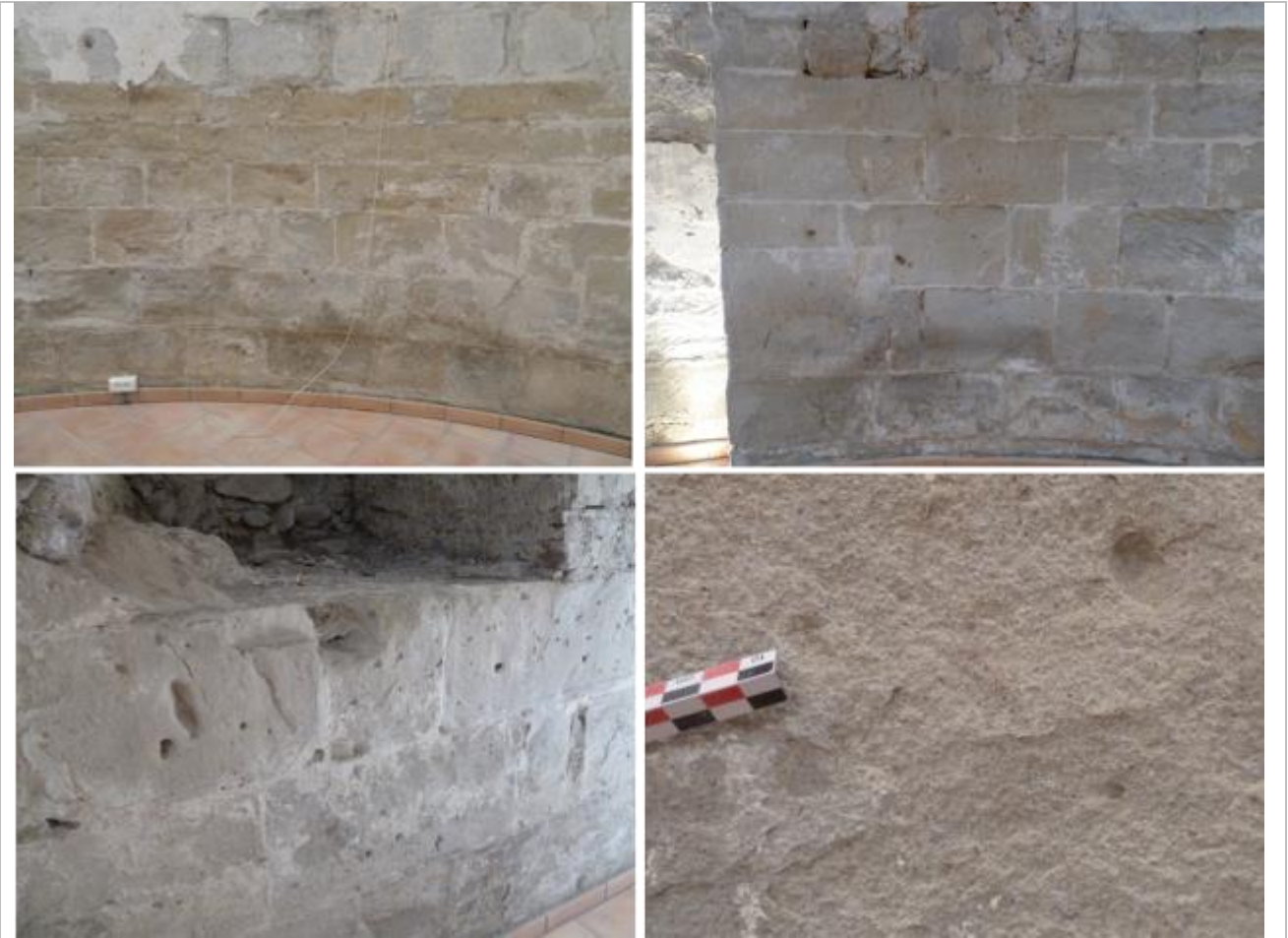
Vues intérieures de mise en œuvre du grès gris-beige à grain fin à moyen (Grès d'Annot, Oligocène).
