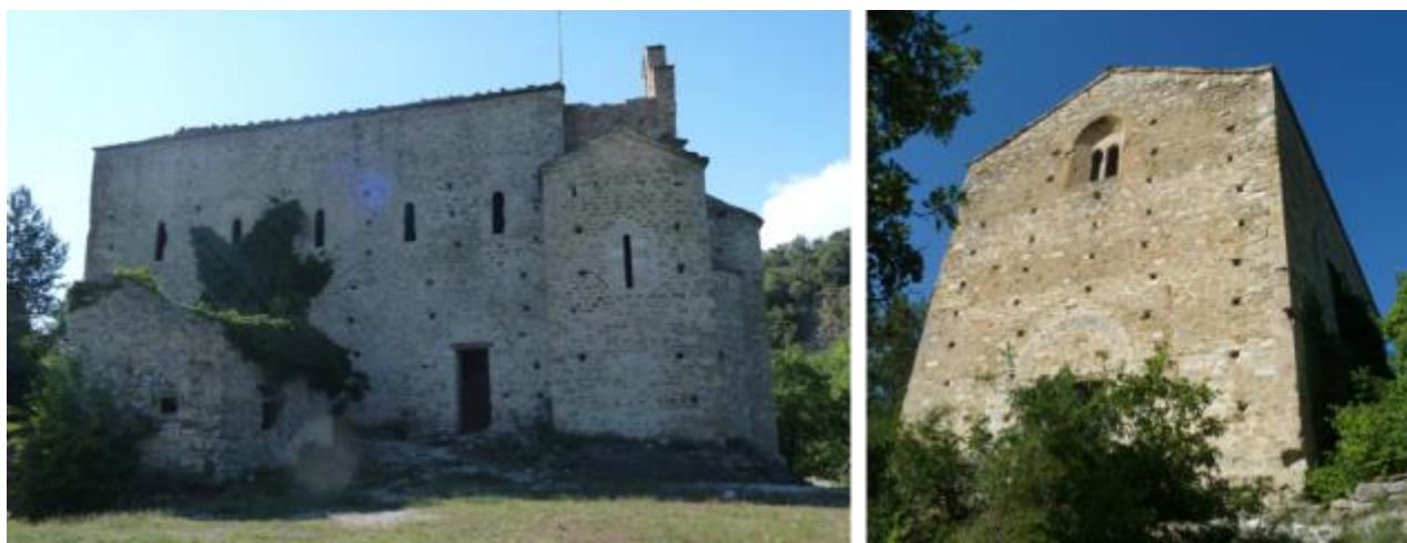
Vue d'ensemble de l'édifice.
