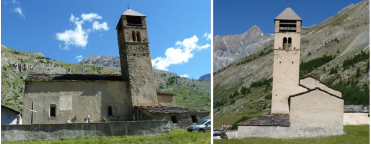
Vues d'ensemble de l'édifice.
