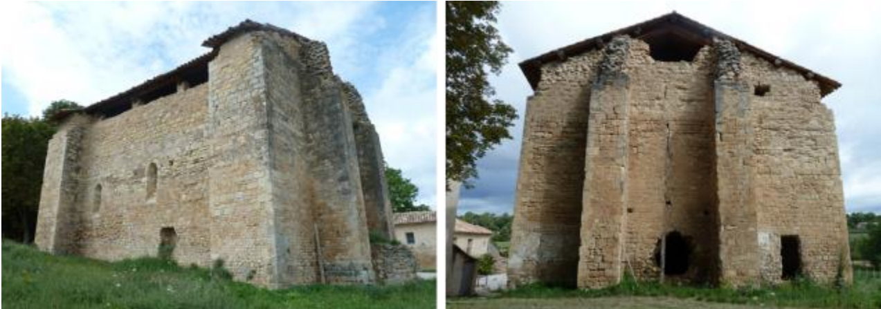
Vues d'ensemble de l'édifice.
