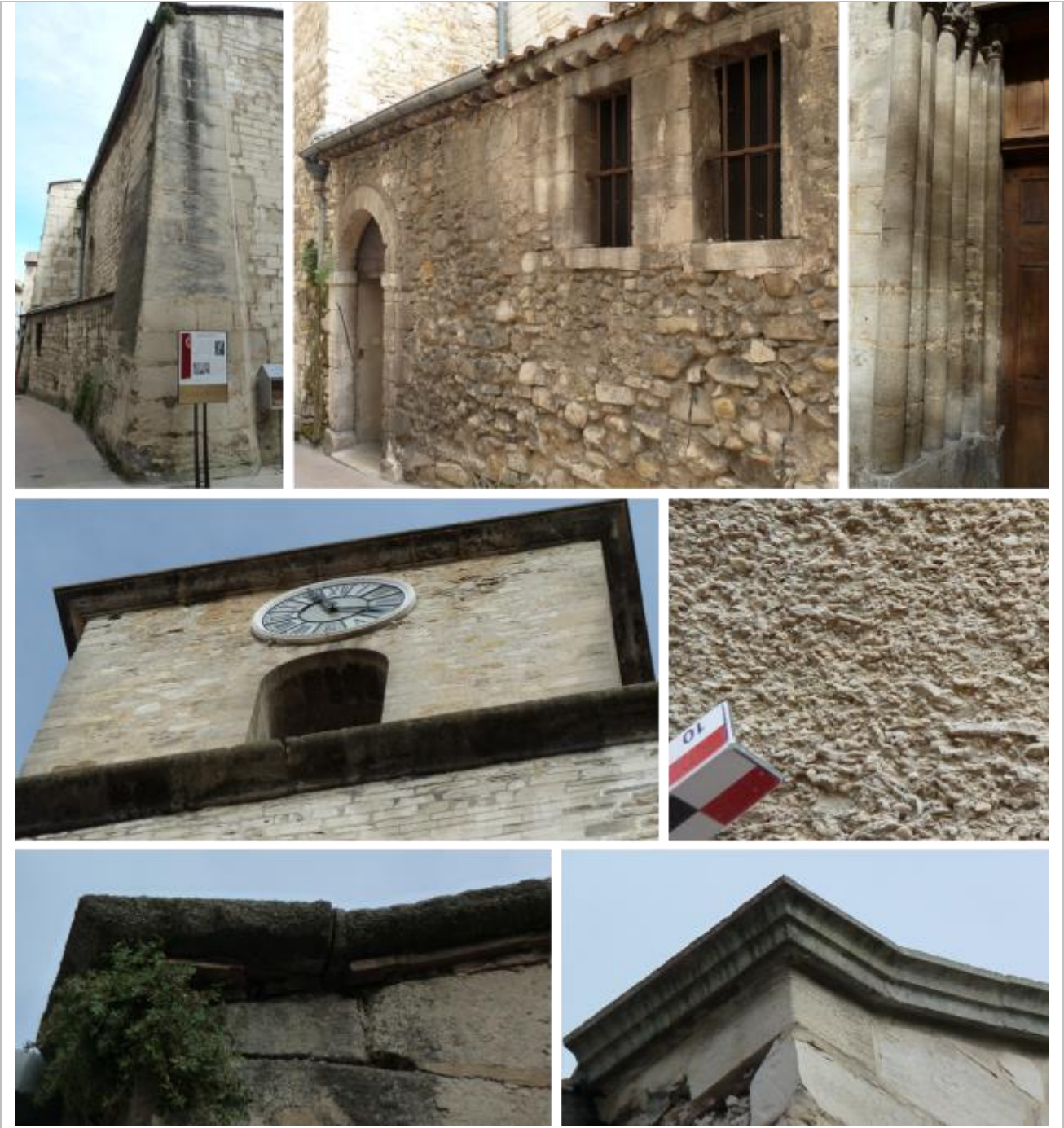
Vues de mise en œuvres du calcaire biodétritique assez tendre et poreux, de teinte beige à patine beige-grisâtre, à grain moyen à plus grossier et à aspect lité (Pierre de Mane).
