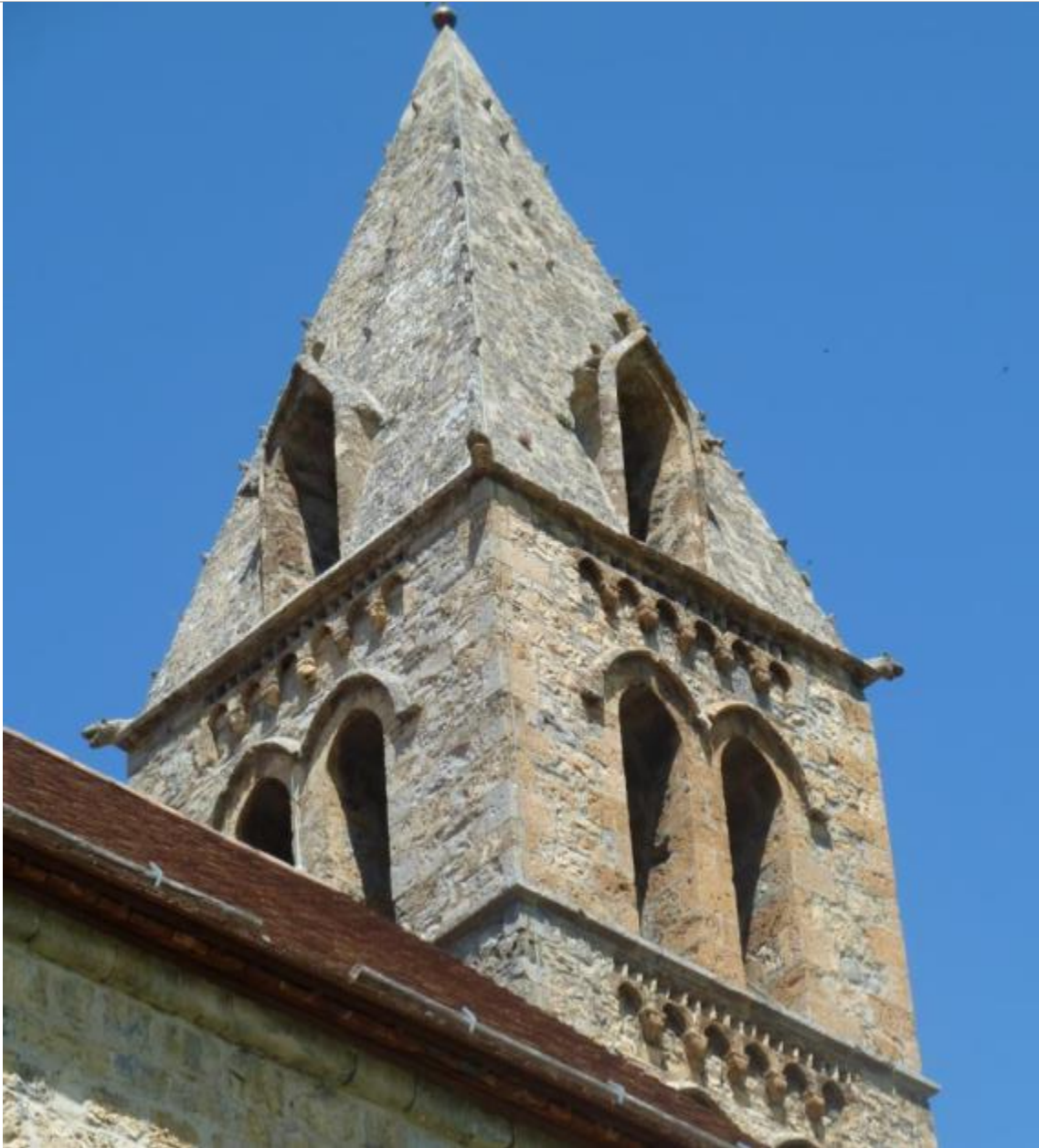
Vue du clocher en calcaire compact légèrement marneux, noirâtre, à patine jaunâtre et calcaire dolomitisé jaune-ocre plus ou moins cargneulisé.
