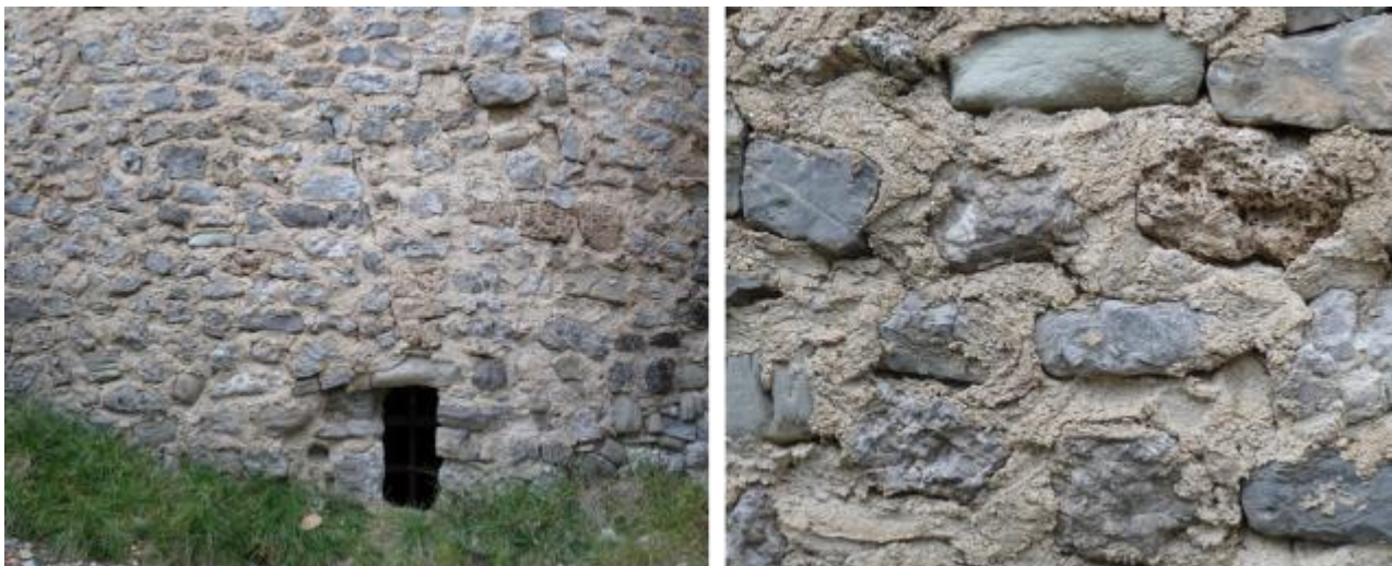
Vues des murs en moellons bruts de divers types de pierres locaux.
