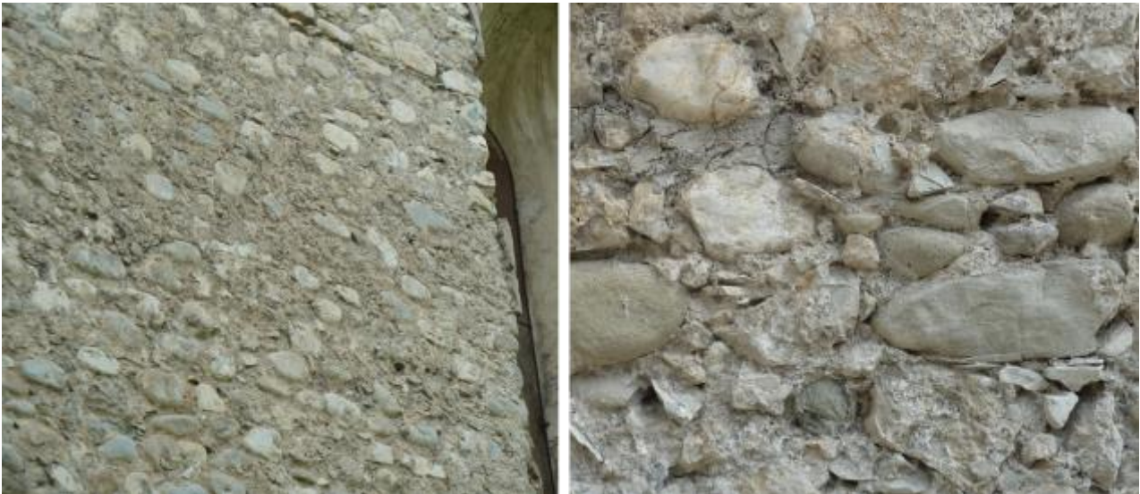
Vues des murs en galets issus de la rivière en contrebas, en mélange avec des petits moellons irréguliers, formant un tout-venant de divers types de roches.
