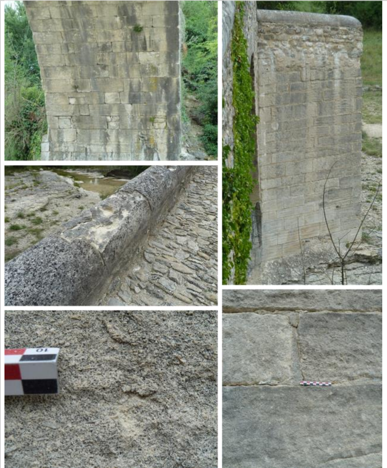
Vues de mise en œuvre de blocs taillés de calcaire beige-clair biodétritique, à grain moyen plus grossier assez homogène et léger litage (Pierre de Mane).
