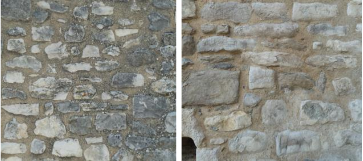
Vues des moellons irréguliers ou grossièrement équarris suivant les parties du murs, issus des différents types de calcaires locaux du Bédoulien.
