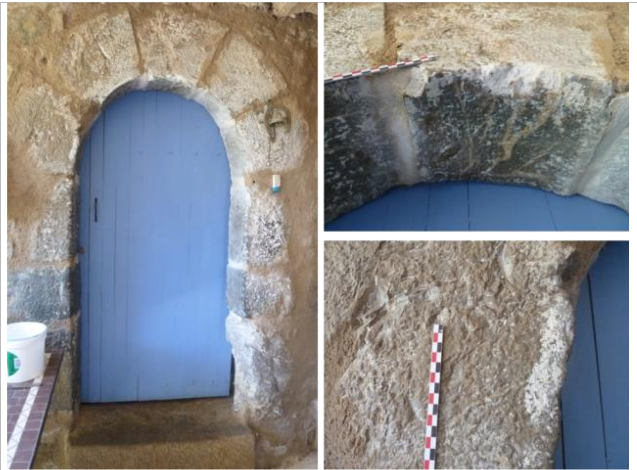
Vues du calcaire dur et compact (marbrier) noirâtre, entrecoupé de larges veines blanches de calcite.
