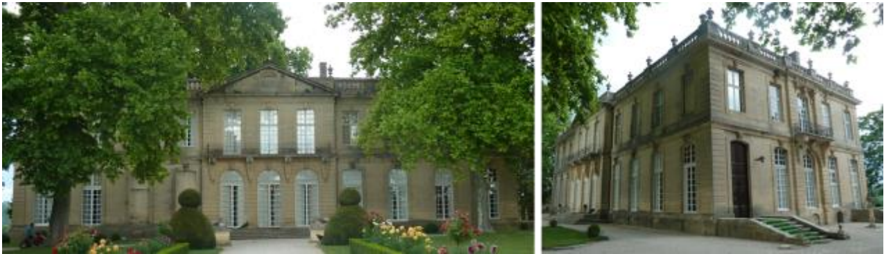
Vues d'ensemble de l'édifice.
