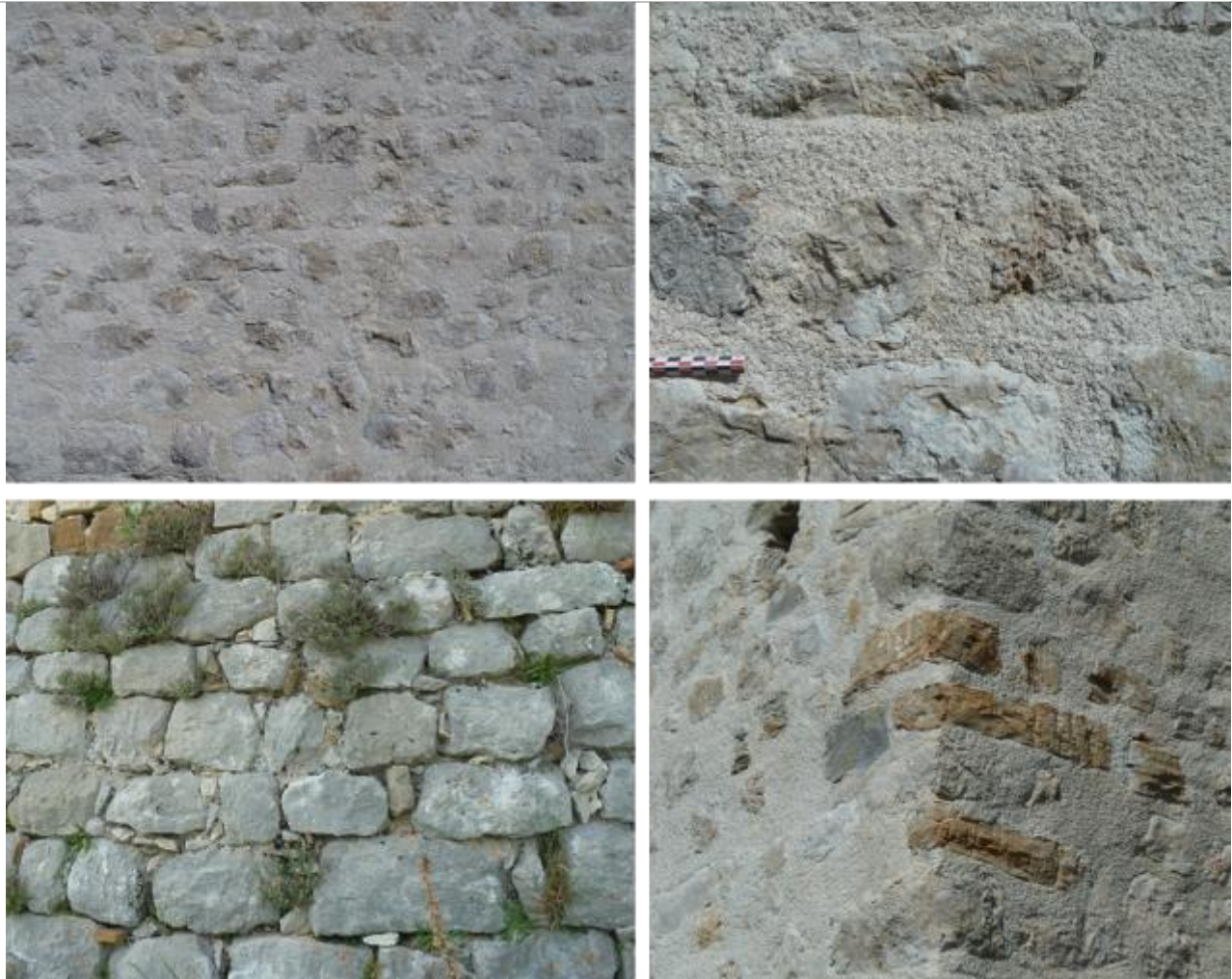
Vue des murs et chainages d'angle, en moellons irréguliers ou grossièrement équarris, de divers types de roches calcaires de provenance locale.
