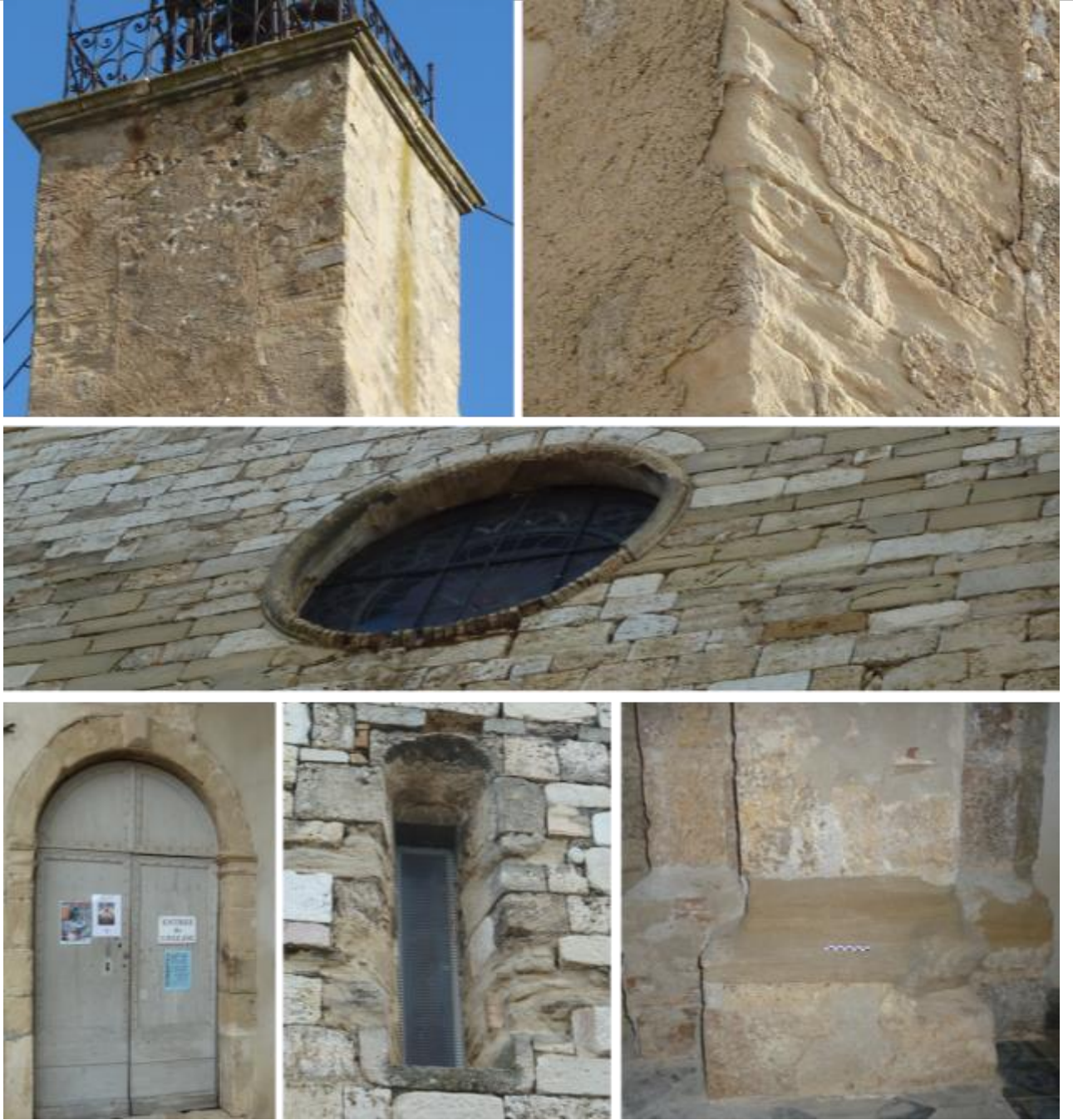
Vues de mise en œuvre de calcaire biodétritique beige-verdâtre, finement lité, assez friable et altérable.
