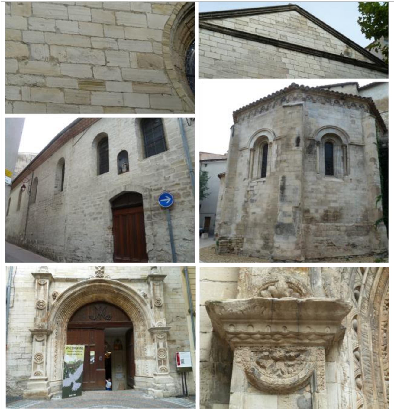
Vues extérieures de mise en œuvre du calcaire fin blanchâtre à beige-crème finement lité.
