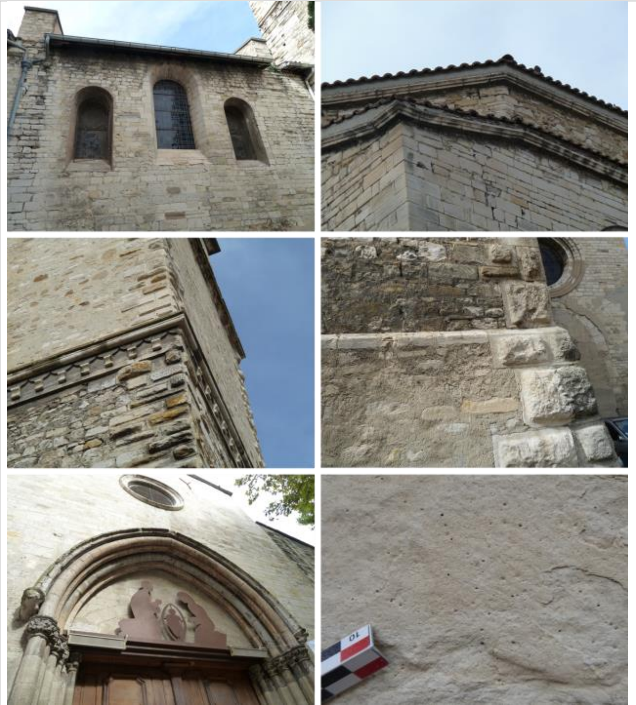
Vues extérieures de mise en œuvre du calcaire fin blanchâtre à beige-crème finement lité.
