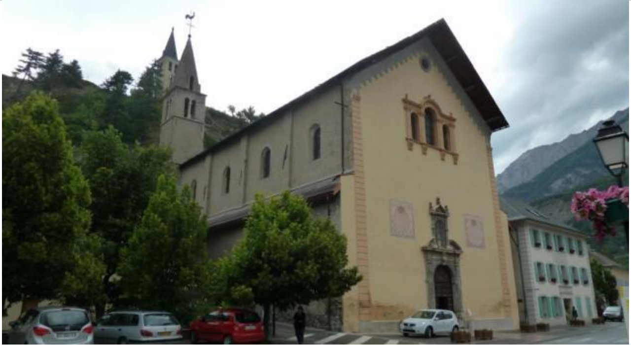
Vue d'ensemble de l'édifice.
