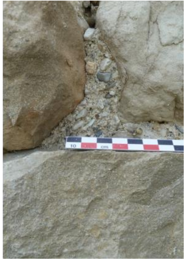
Vues des moellons en grès gris-brun-verdâtre à grain fin, à patine orangée à brune.
