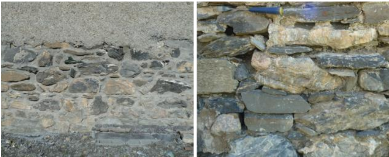
Vues des murs composés de moellons bruts formant un tout-venant, prélevés dans les dépôts glaciaires alentours et le lit de la rivière sous-jacente.
