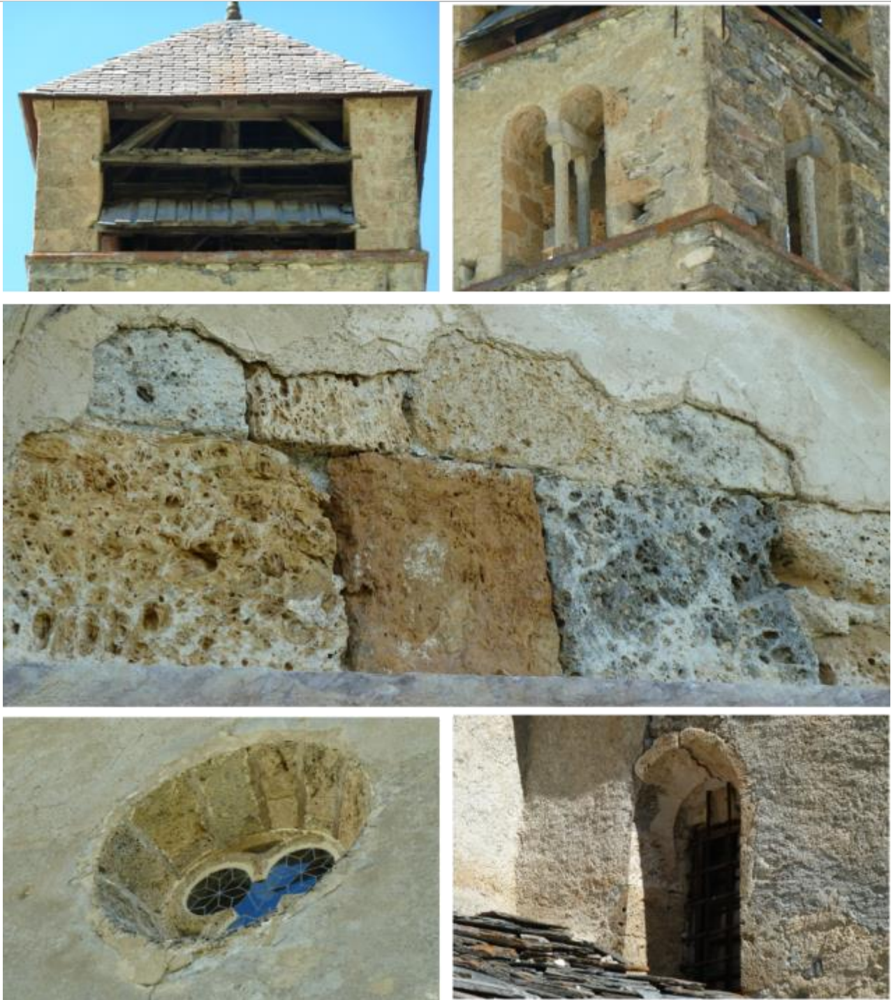
Vues de mise en œuvre de la cargneule beige à ocre parfois grisâtre, plus ou moins vacolaire et bréchique.
