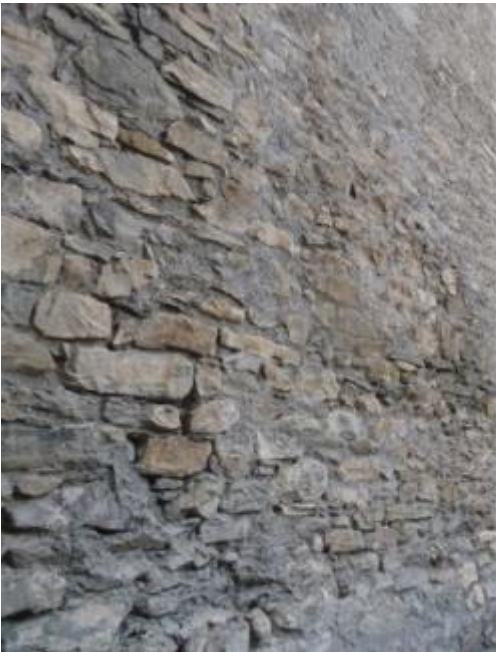
Vues des moellons plus ou moins équarris de forme allongée de calcaire assez dur et compact noirâtre à pâte fine parcourue de veines blanches de calcite, à patine blonde, en mélange avec un calcaire marneux gris-sombre à débit feuilleté.
