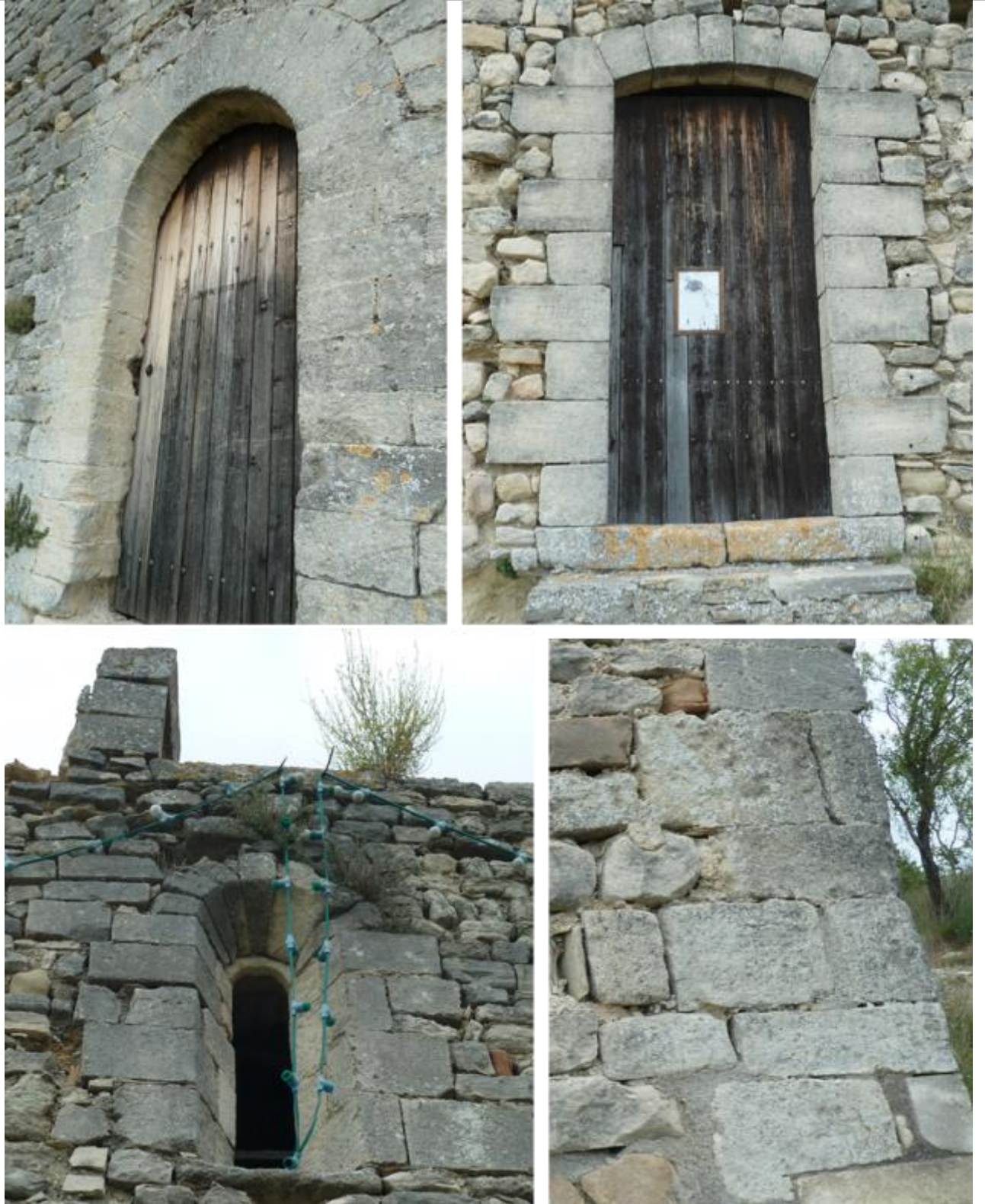
Chapelle : vues de mise en œuvre des blocs taillés de calcaire beige-clair biodétritique, à grain moyen à plus grossier assez homogène et léger litage (Pierre de Mane).
