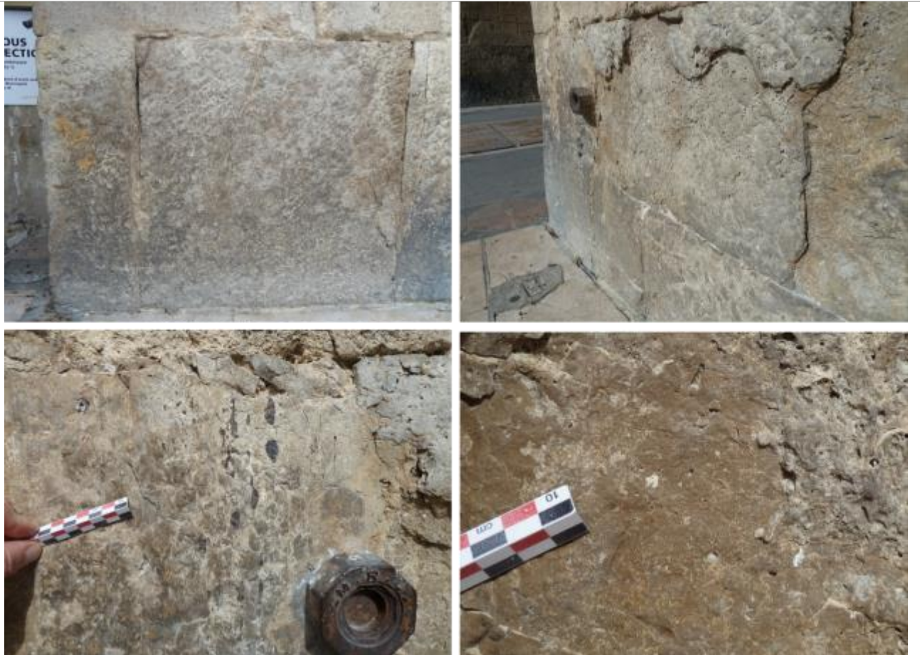
Vues de mise en œuvre du calcaire dur gris-brun à patine brunâtre, à pâte fine à conglomératique.
