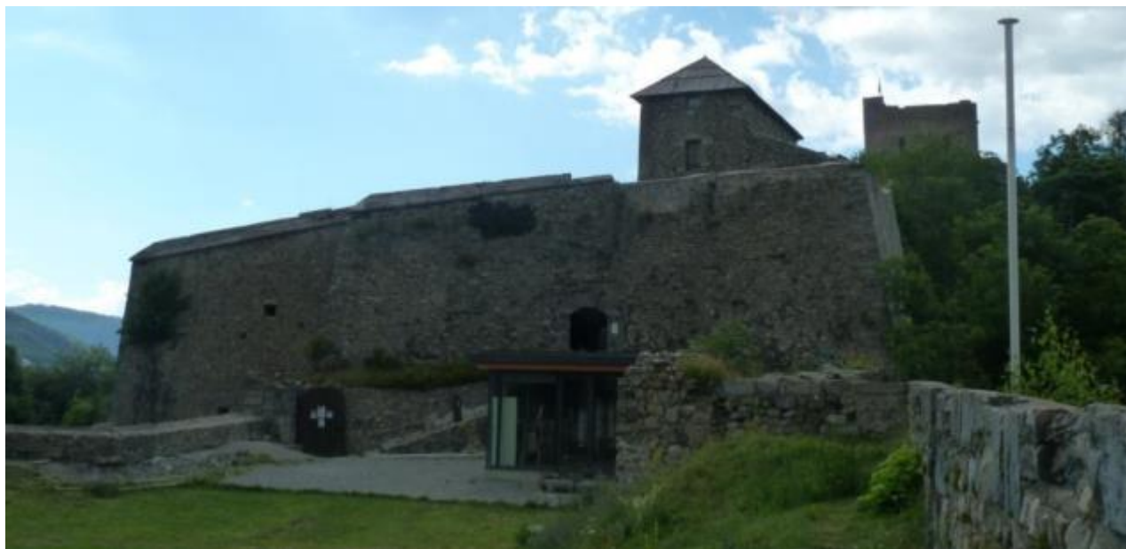
Vue d'ensemble de l'édifice.
