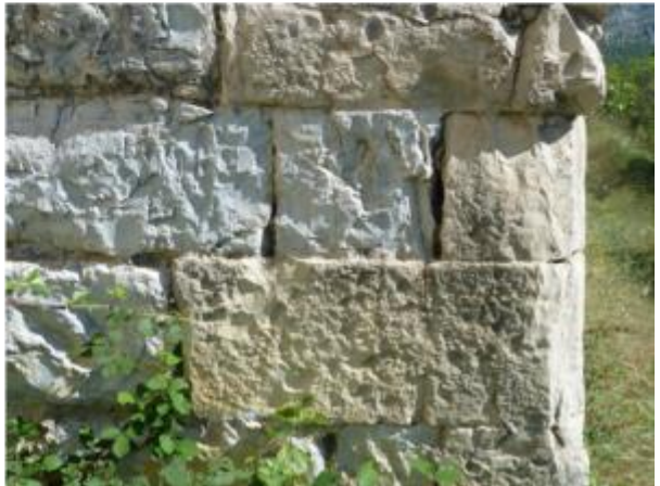
Vues des mises en œuvre du calcaire compact beige-brun, à pâte finement gréseuse et à patine beige.
