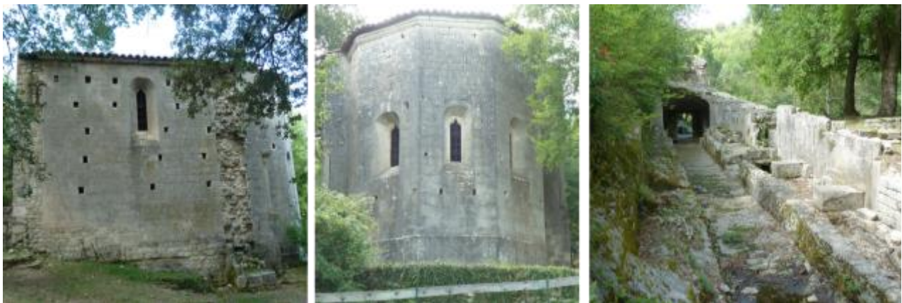
Vues d'ensemble de l'édifice.
