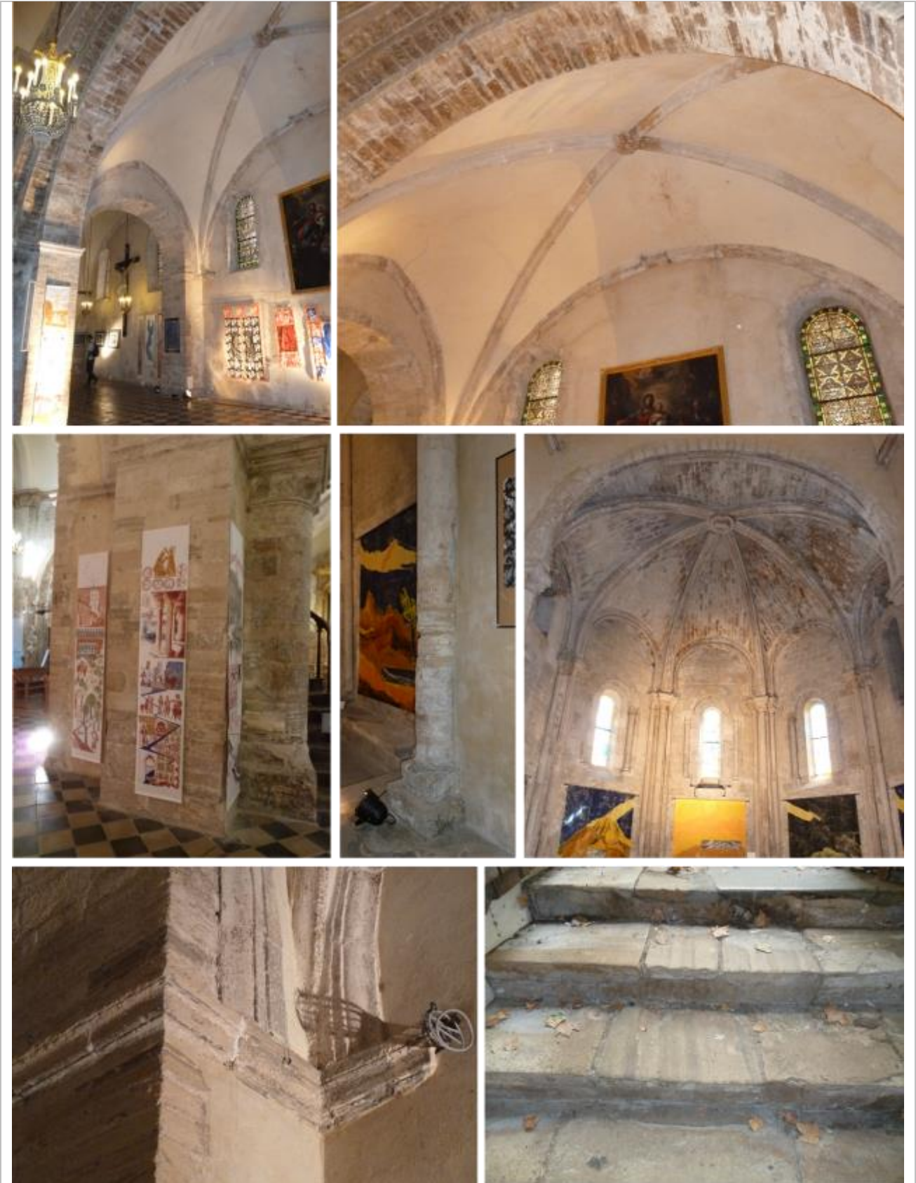
Vues intérieures de mise en œuvre du calcaire fin blanchâtre à beige-crème finement lité.
