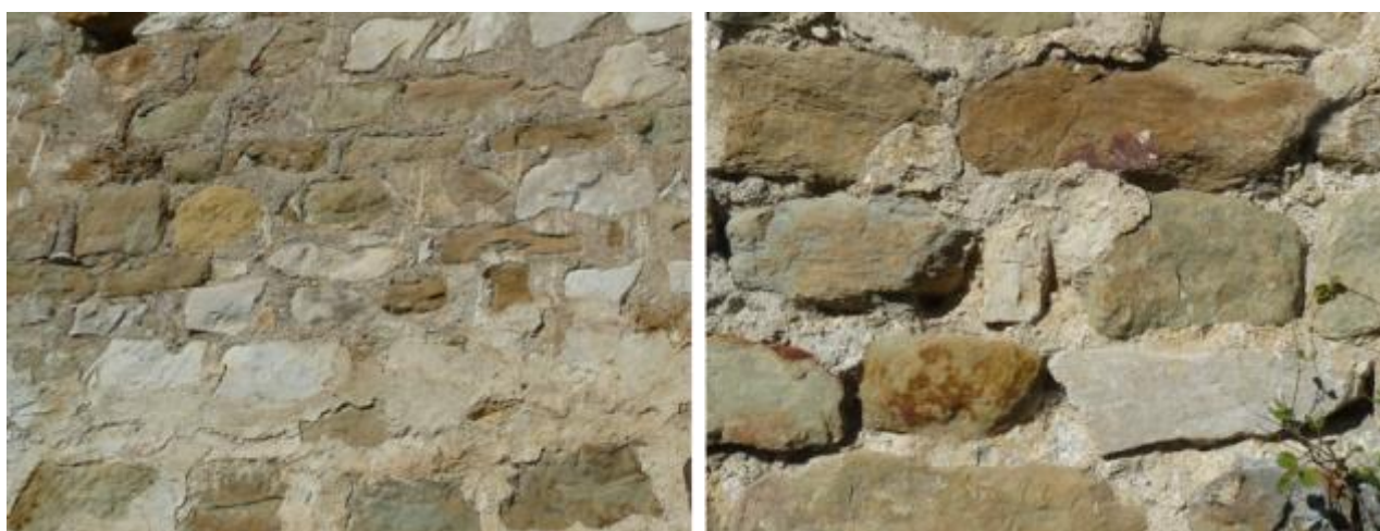
Vues des murs en moellons bruts de grès beige-verdâtre à grain fin et patine ocreuse, en mélange avec des calcaires fins légèrement argileux beige-clair, sonores, à patine claire grisâtre.
