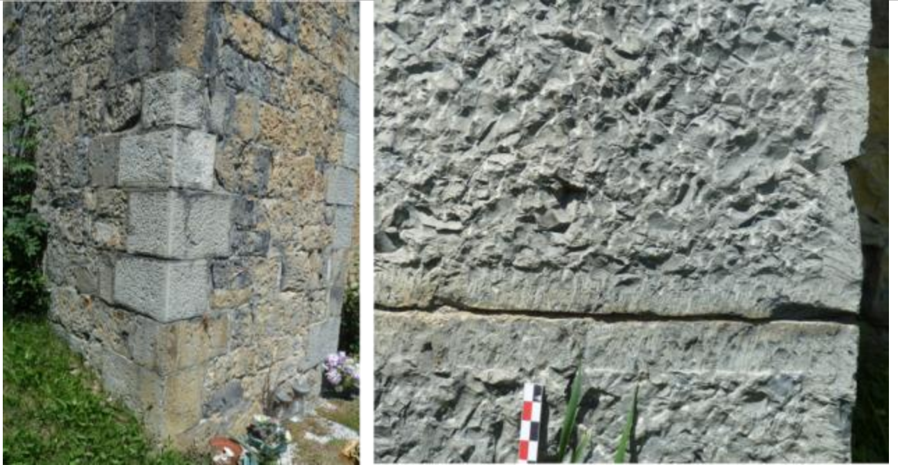
Vue des blocs de parement (restauration) en calcaire compact (marbrier) pseudo-bréchiq ue gris-brun, à patine gris-bleu (Pierre de Labeaume).
