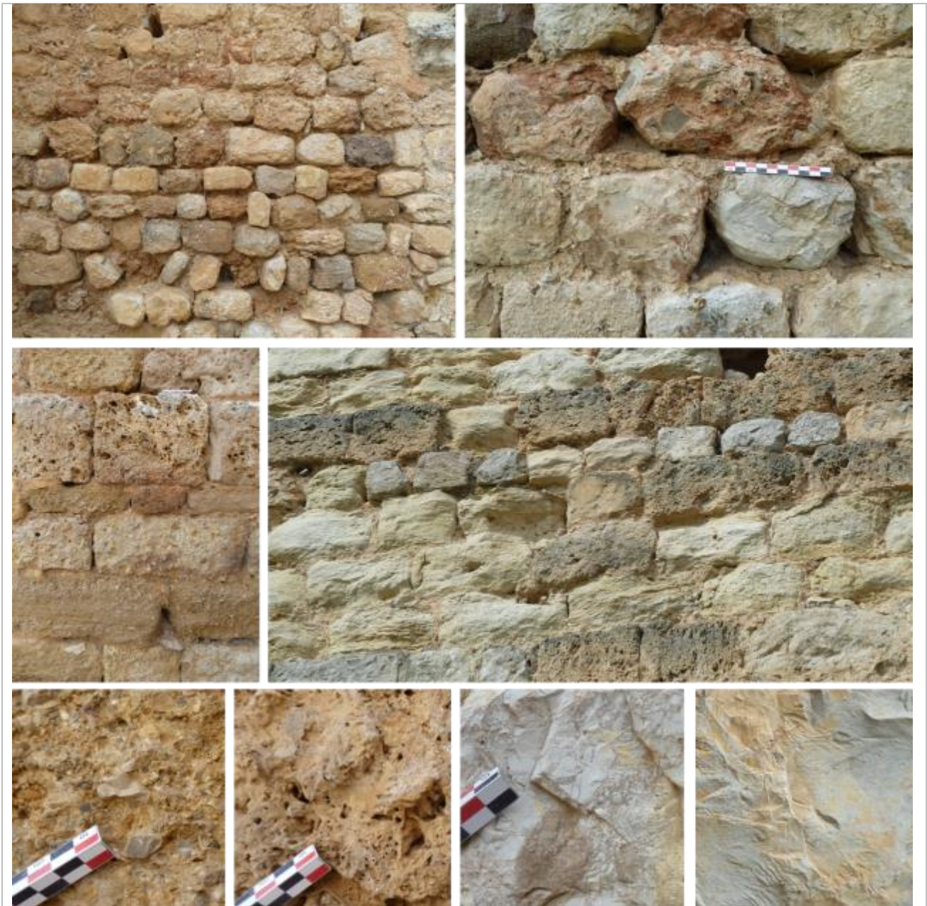
Vues des murs en moellons formant un tout-venant de divers types de roches.
