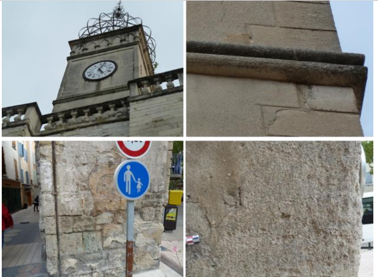
Vues de mise en œuvres du calcaire biodétritique assez tendre et poreux, de teinte beige à patine beige-grisâtre, à grain moyen à plus grossier et à aspect lité (Pierre de Mane).
