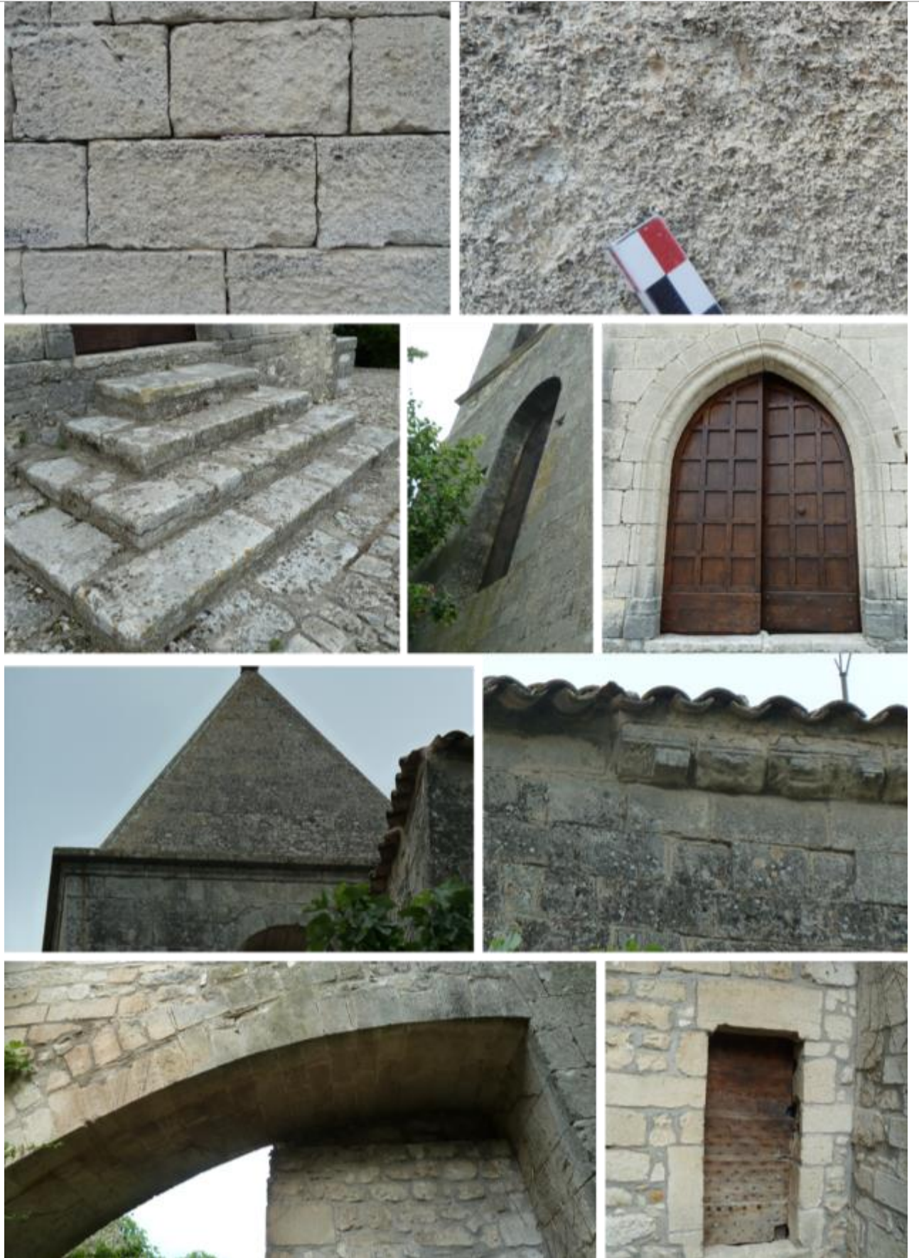
Vues extérieures de mise en œuvre extérieure du calcaire beige-clair biodétritique, à grain moyen à plus grossier assez homogène et léger litage (Pierre de Mane).
