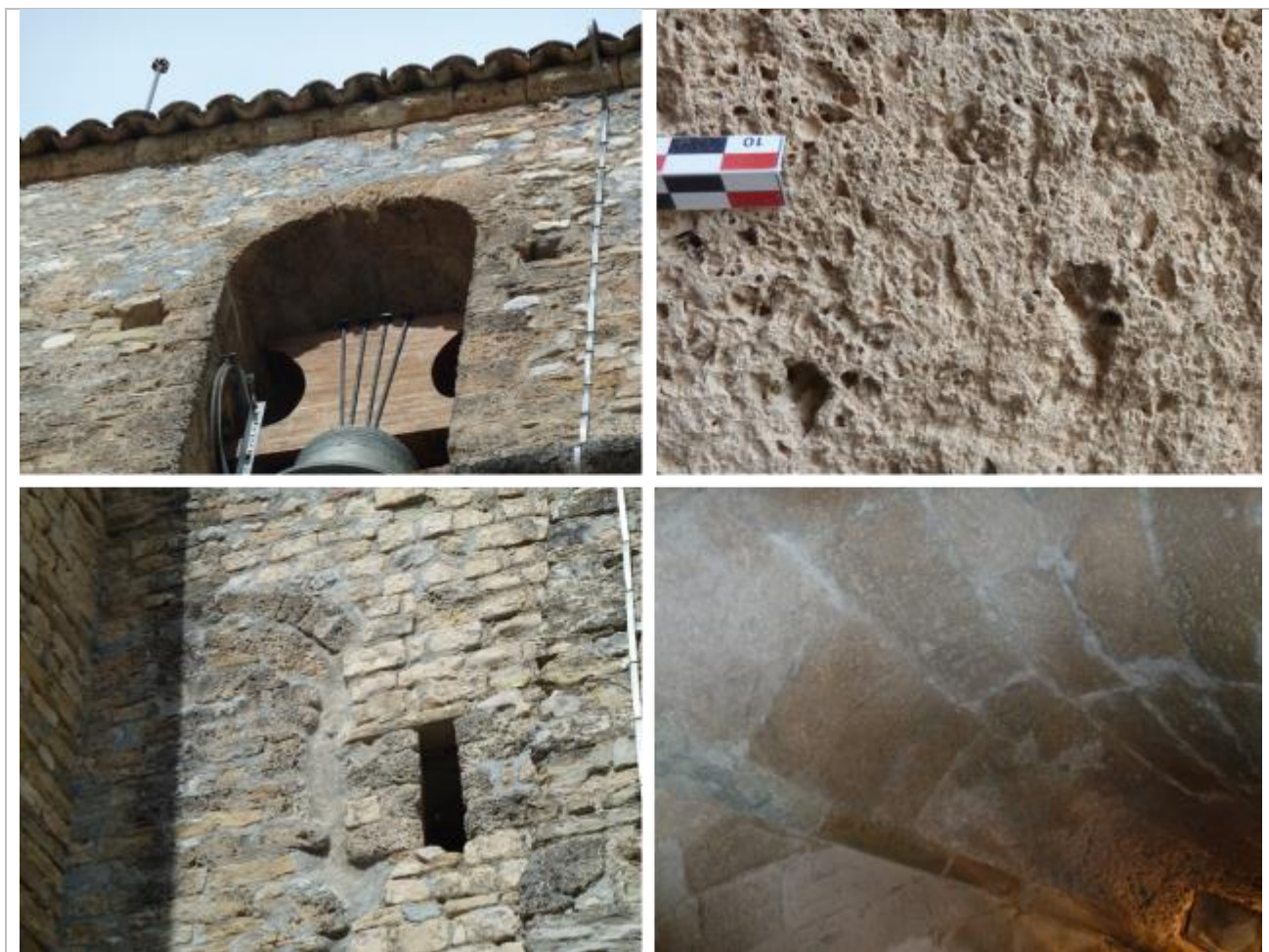
Vues de mise en œuvre du tuf de source beige plus ou moins vacuolaire à patine ocre-brun.
