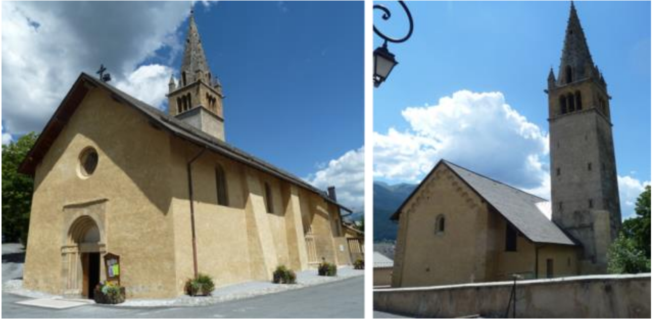
Vues d'ensemble de l'édifice.
