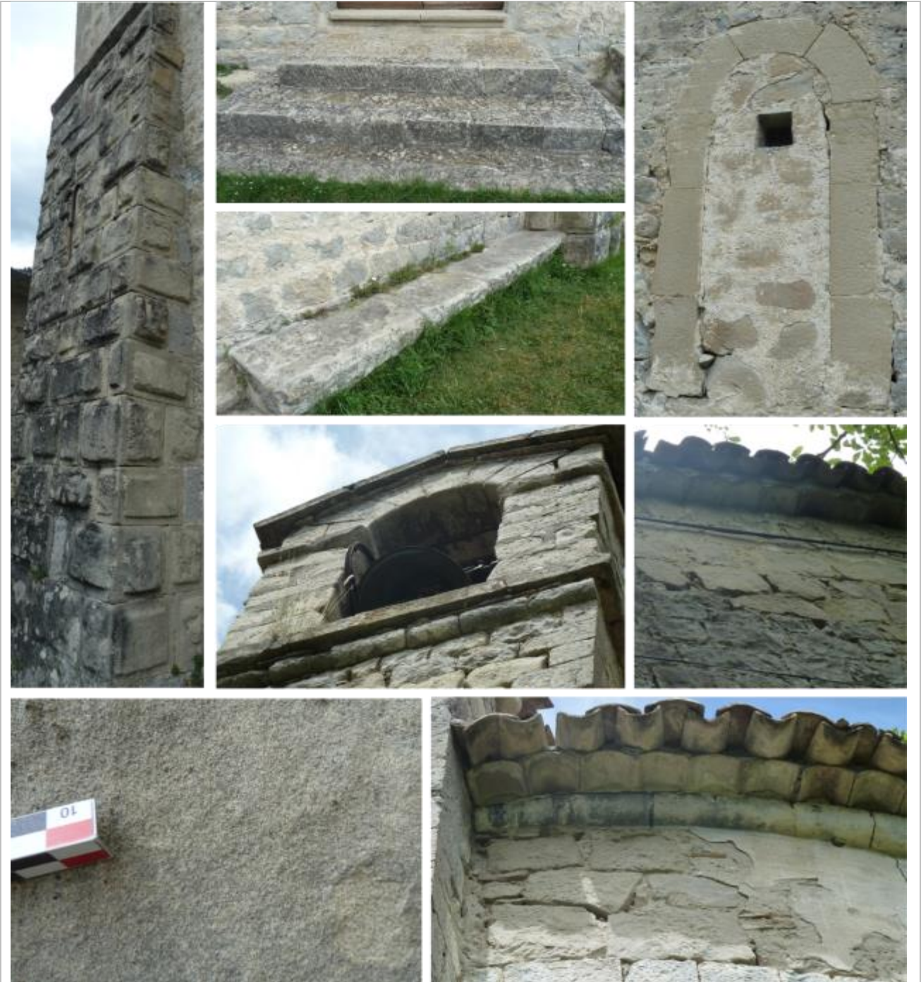
Vues de mise en œuvre des grés jaunâtre à grain fin à moyen, à patine beige-grisâtre (Grés d'Annot).
