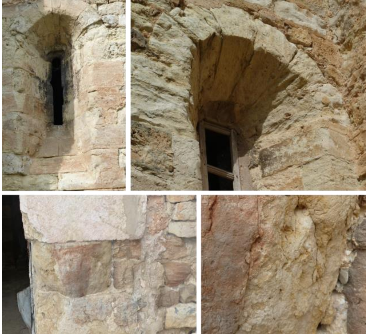
Vues de mise en œuvre du calcaire biodétritique finement lité beige-verdâtre, assez friable et altérable.
