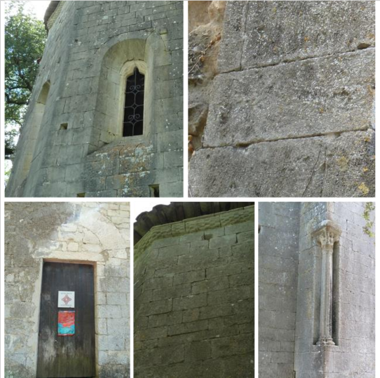
Vues de mise en œuvre du calcaire biodétritique beige-blanchâtre (molasse) à grain moyen assez homogène (Pierre de Cereste).
