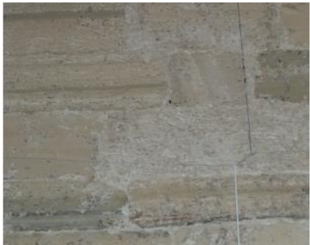
Vue comparée extérieur / intérieur de mise en œuvre du calcaire fin blanchâtre à beige-crème finement lité.
