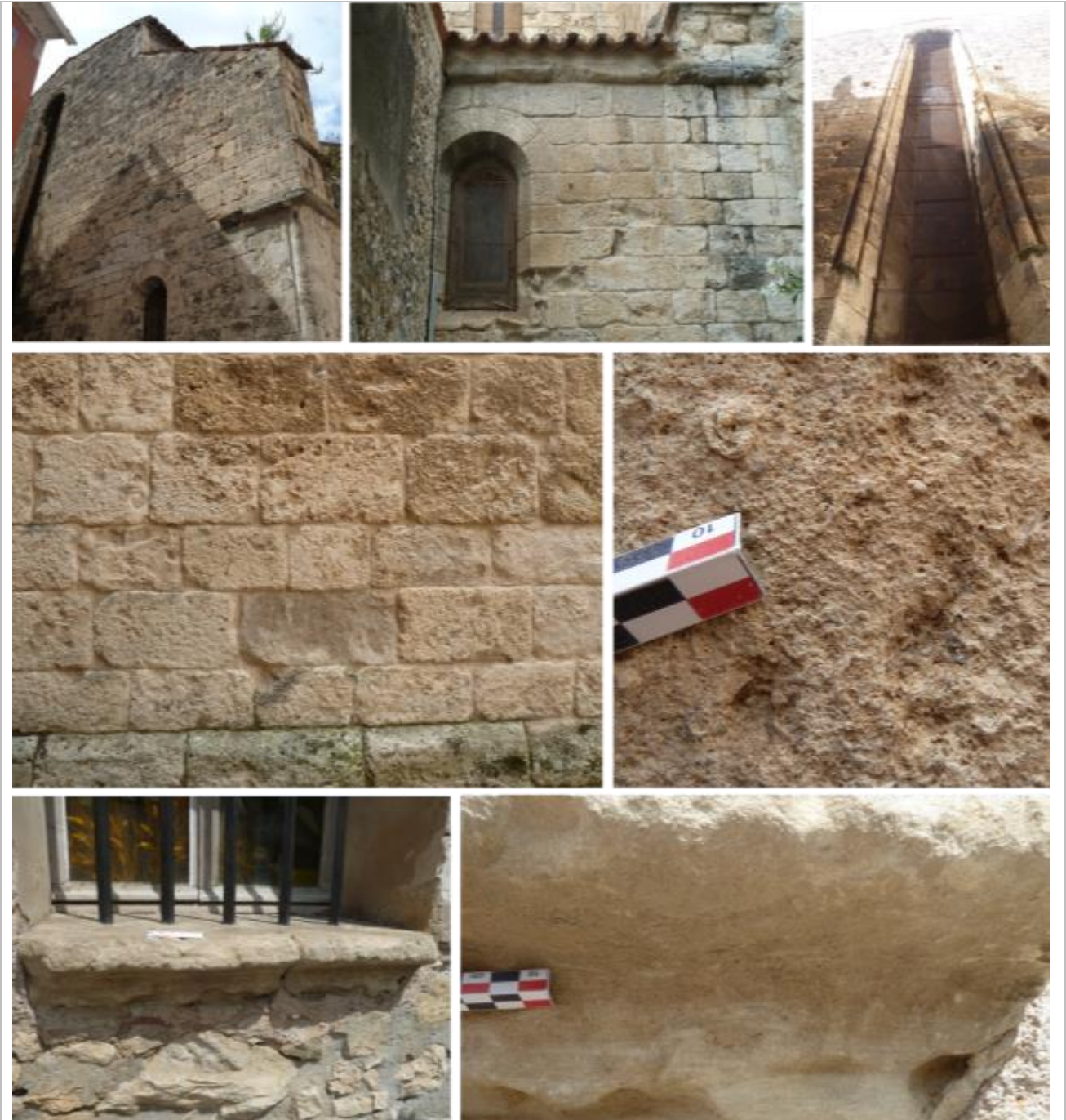
Vues de mise en œuvre du calcaire biodétritique beige-jaunâtre plus tendre à patine beige-orangée (molasse miocène ?).
