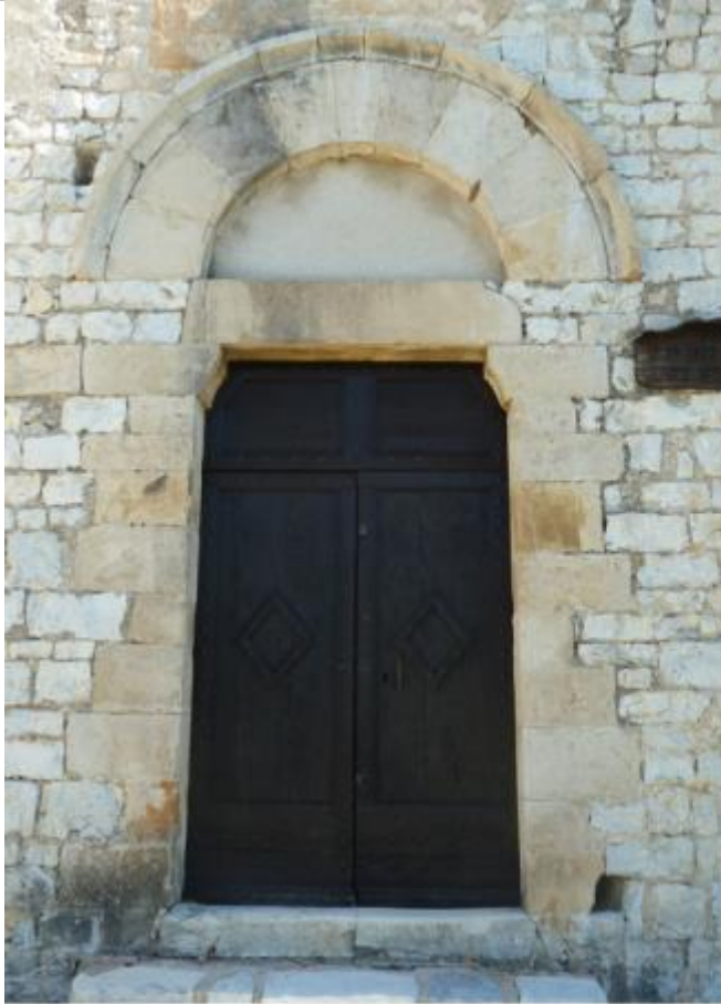
Vues des mises en œuvre du calcaire compact beige-brun, à pâte finement gréseuse et à patine beige.
