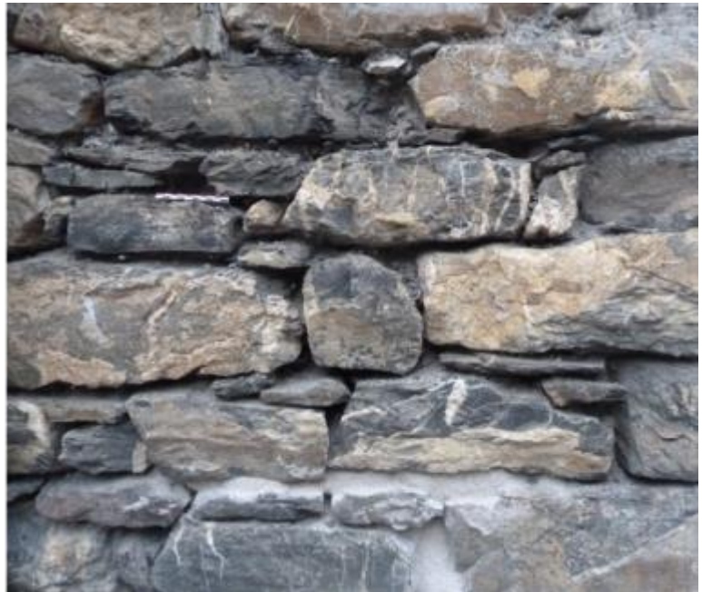
Vues des moellons plus ou moins équarris de forme allongée de calcaire assez dur et compact noirâtre à pâte fine parcourue de veines blanches de calcite, à patine blonde, en mélange avec un calcaire marneux gris-sombre à débit feuilleté.
