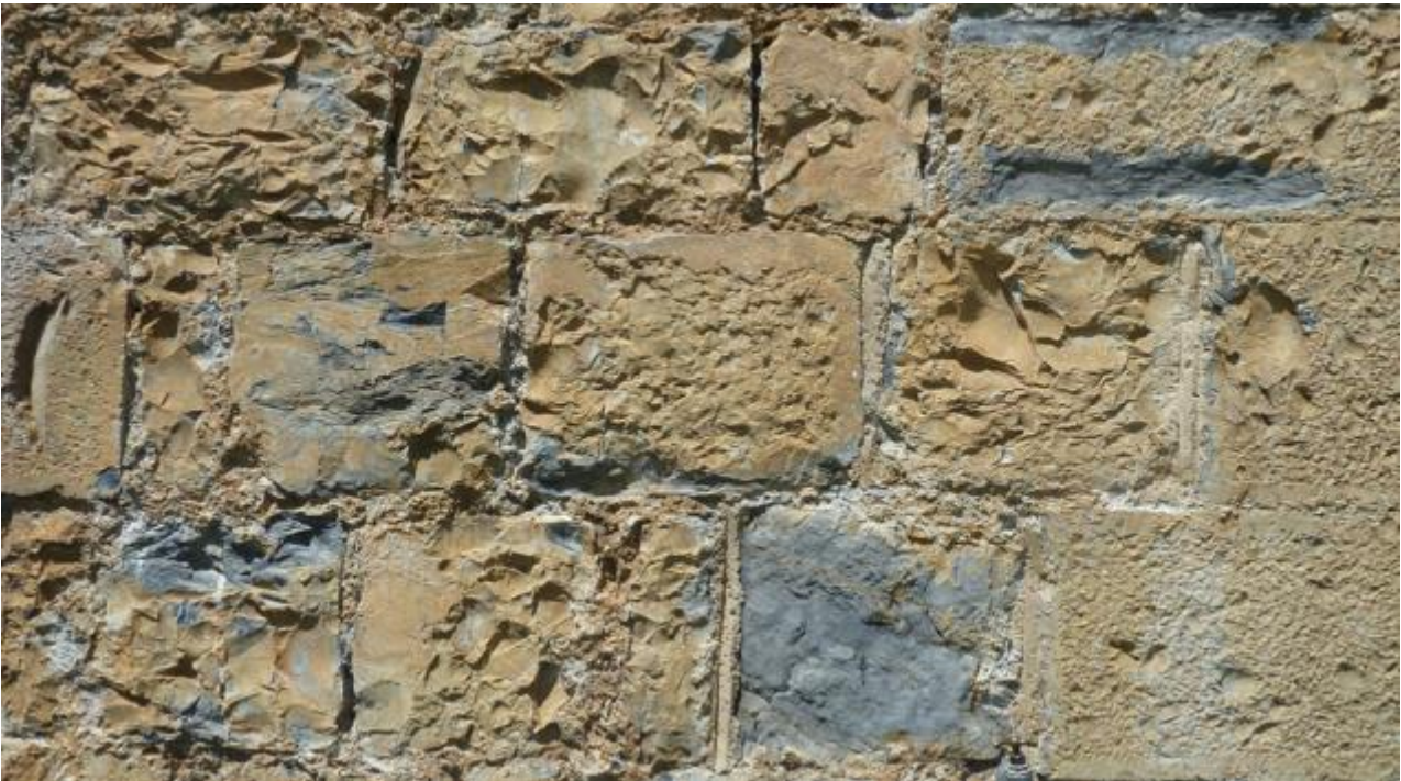
Vue des blocs taillés dans un calcaire noirâtre légèrement marneux, à patine jaunâtre, entrecoupé de quelques veines blanches de calcite.
