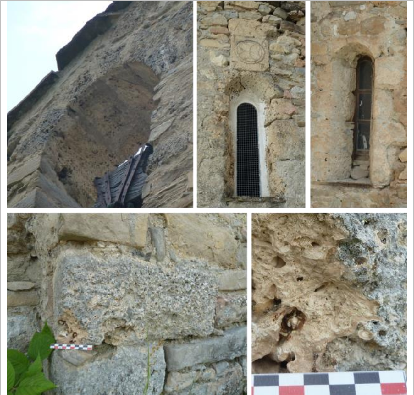
Vues de mise en œuvre du tuf de source plus ou moins vacuolaire beige-crème à patine grisâtre.
