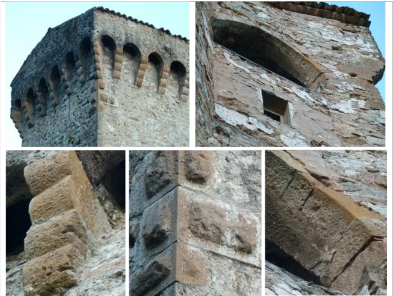
Vues de mise en œuvre du calcaire (dolomie ?) assez compact jaune-brunâtre à roux.
