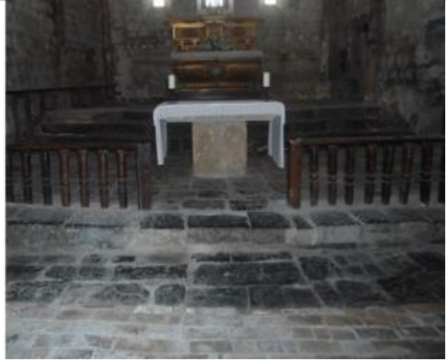
Vue des marches et du dallage en calcaire compact (marbrier) noirâtre à veines blanches de calcite.
