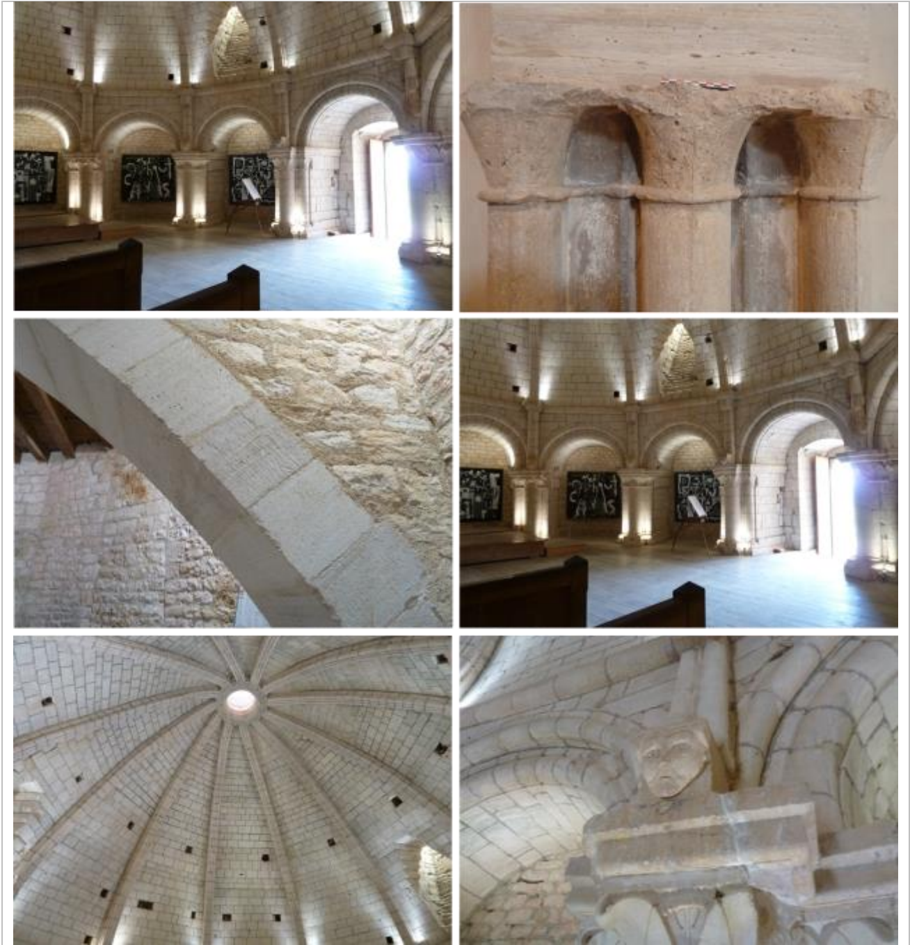
Vues intérieures de mise en œuvre d'éléments taillés en calcaires bioclastiques blanchâtres de l'Urgonien.
