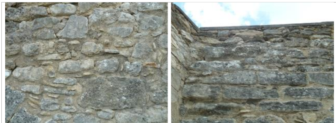
Vues des façades en moellons irréguliers de Pierre de Mane.
