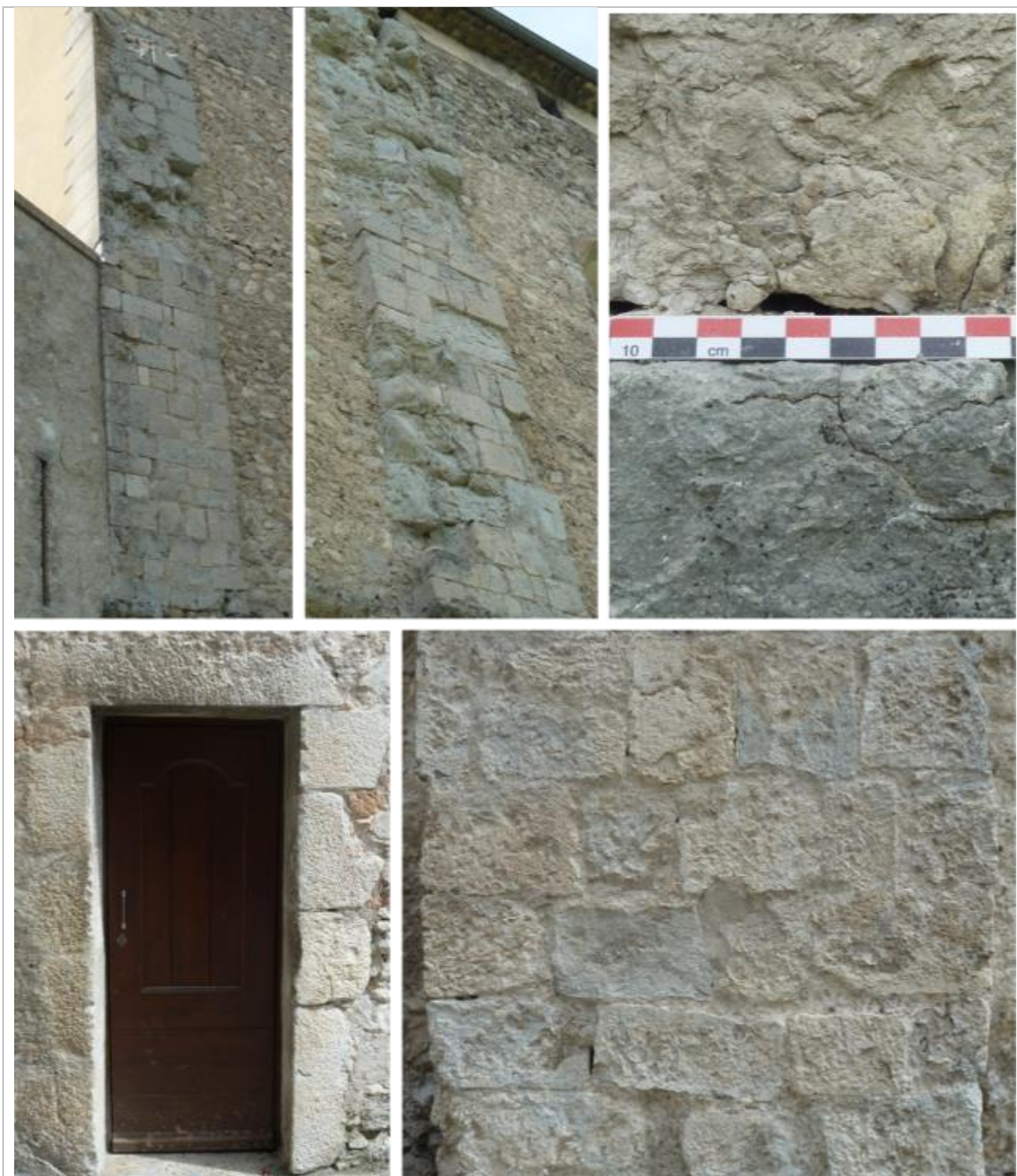
Vues de mise en œuvre du calcaire marneux gris-beige, tendre et altérable, à patine claire grisâtre parfois légèrement rousse.
