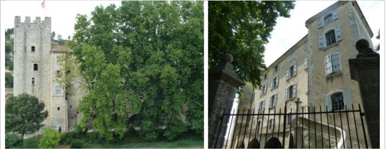
Vue d'ensemble de l'édifice.
