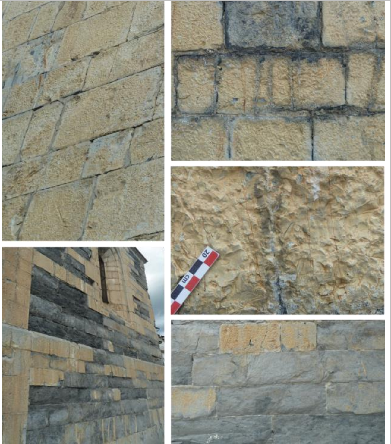
Vues du calcaire plus ou moins schisteux noirâtre à veines blanches de calcite et à patine ocre.
