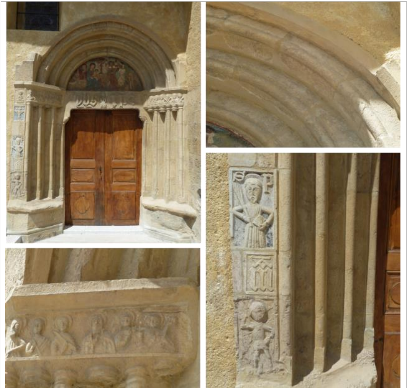
Vues du portail sud essentiellement en Marbre de Serenne rouge ou beige-vert recouvert d'un badigeon jaunâtre.
