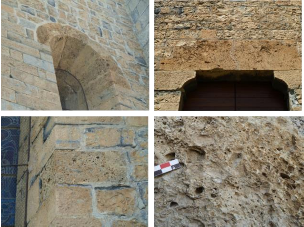
Vues des blocs de calcaires dolomitisés jaune-ocres plus ou moins vacuolaires et bréchiques (cargneulisés).
