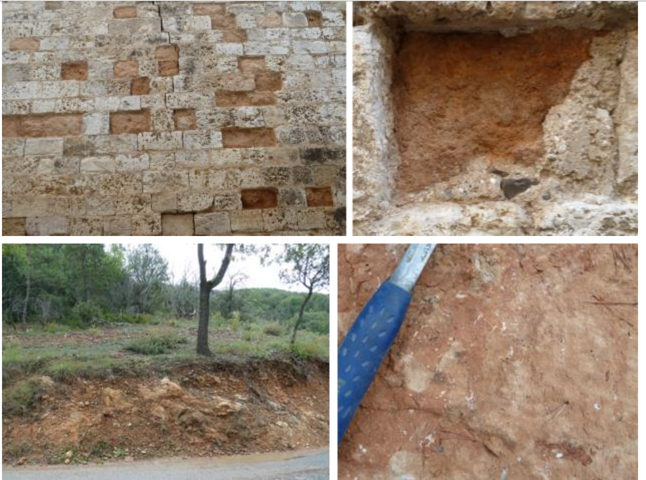
Vues de mise en œuvre et d'un affleurement de Grés « safre » de Gréoux-les-Bains.
