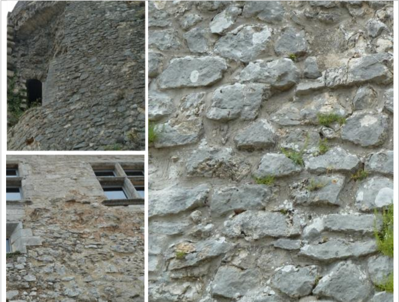
Vues de mise en œuvre des petits moellons irréguliers en calcaires d'origine locale à faciès urgonien.
