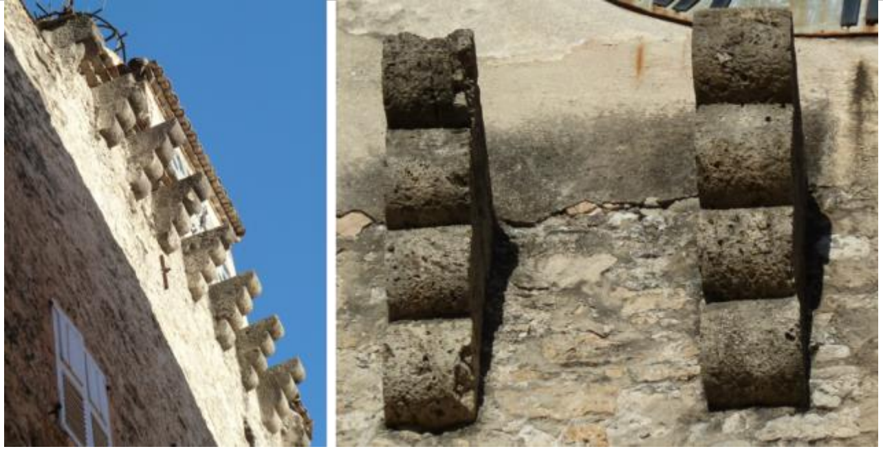
Vue des corbeaux en « tuf » (cargneule ?) à patine gris-beige.
