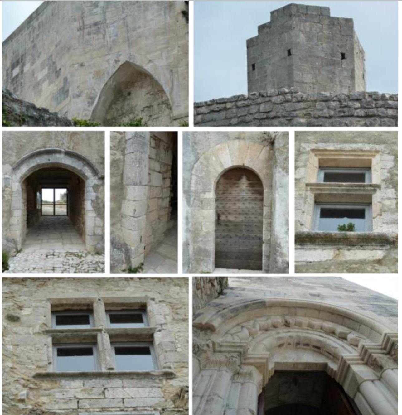
Vues extérieures de mise en œuvre d'éléments taillés en calcaires bioclastiques blanchâtres (faciès urgonien).
