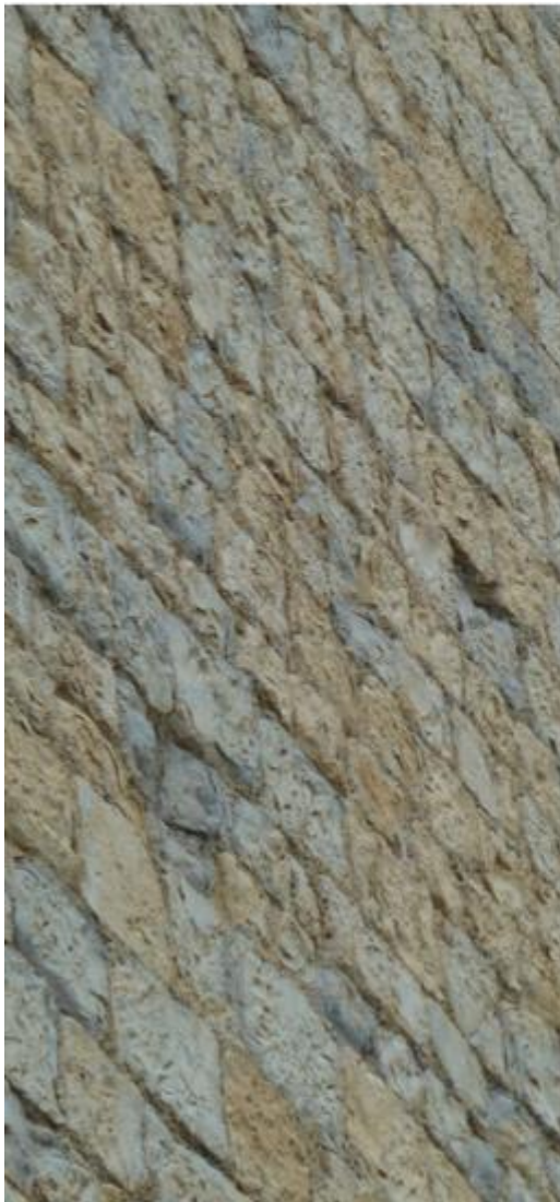
Vues du parement du donjon en calcaire plus ou moins marneux jaune ou gris (parfois bicolore) à grain très fin (Hauterivien).
