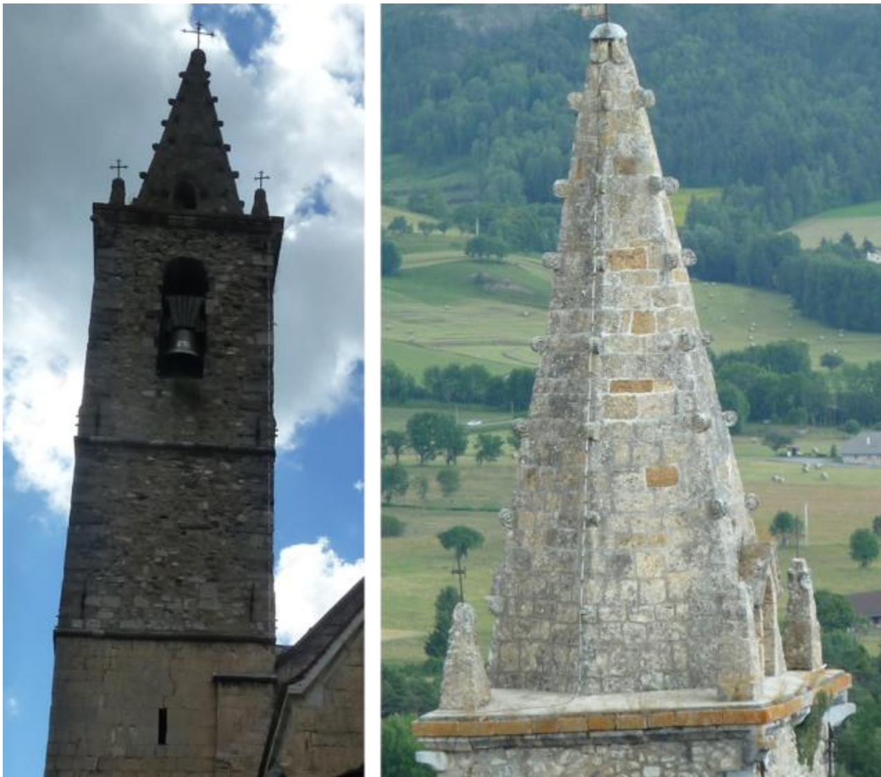
Vues des niveaux supérieurs du clocher majoritairement en calcaire schisteux et de sa flèche essentiellement en tuf calcaire beige à patine grise.
