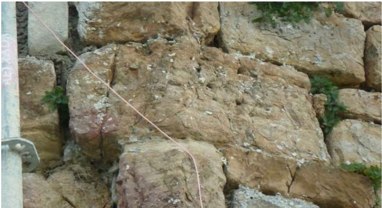
Tour : vues du grès calcaire grisâtre à grain fin légèrement lité, à patine jaune-roux
