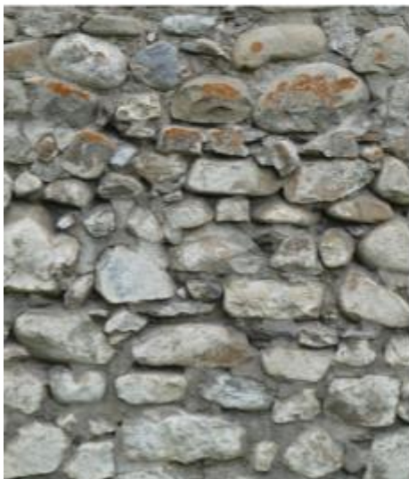
Vues des murs en petits moellons irréguliers et galets formant un tout-venant de divers types de roches d'origine locale.
