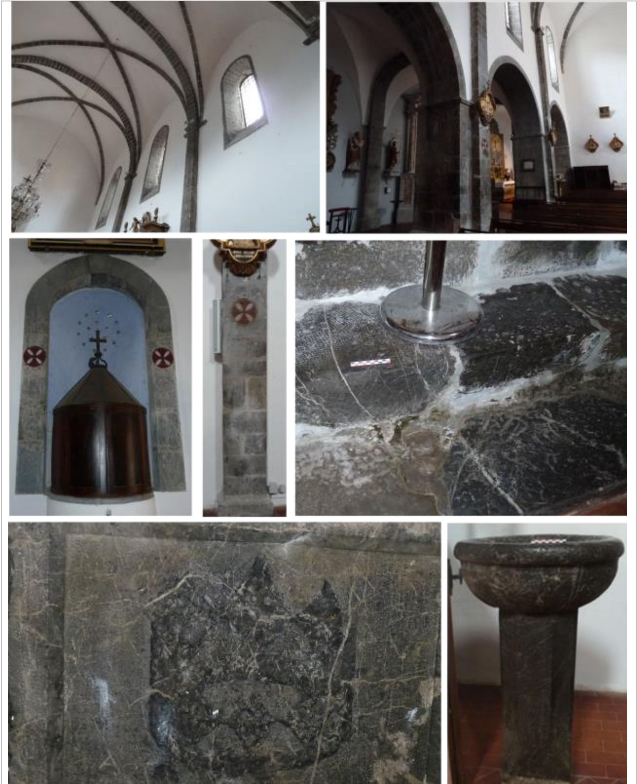
Vues extérieures de mise en œuvre du calcaire dur noir, à pâte fine (marbrier) et patine gris-clair, entrecoupé de veines blanches de calcite.
