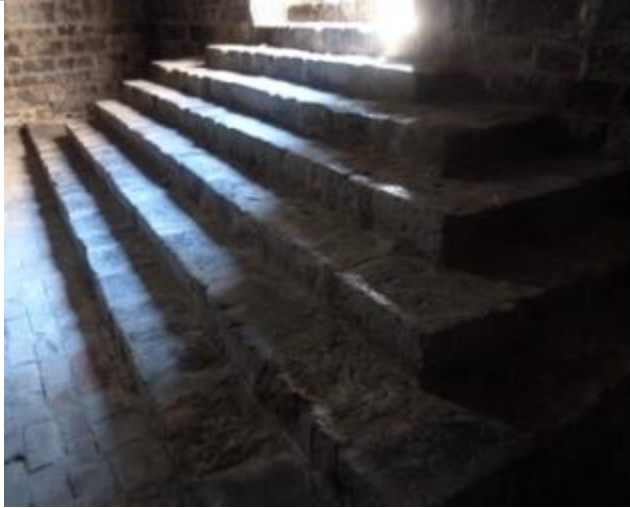
Vue des marches et du dallage en calcaire compact (marbrier) noirâtre à veines blanches de calcite.
