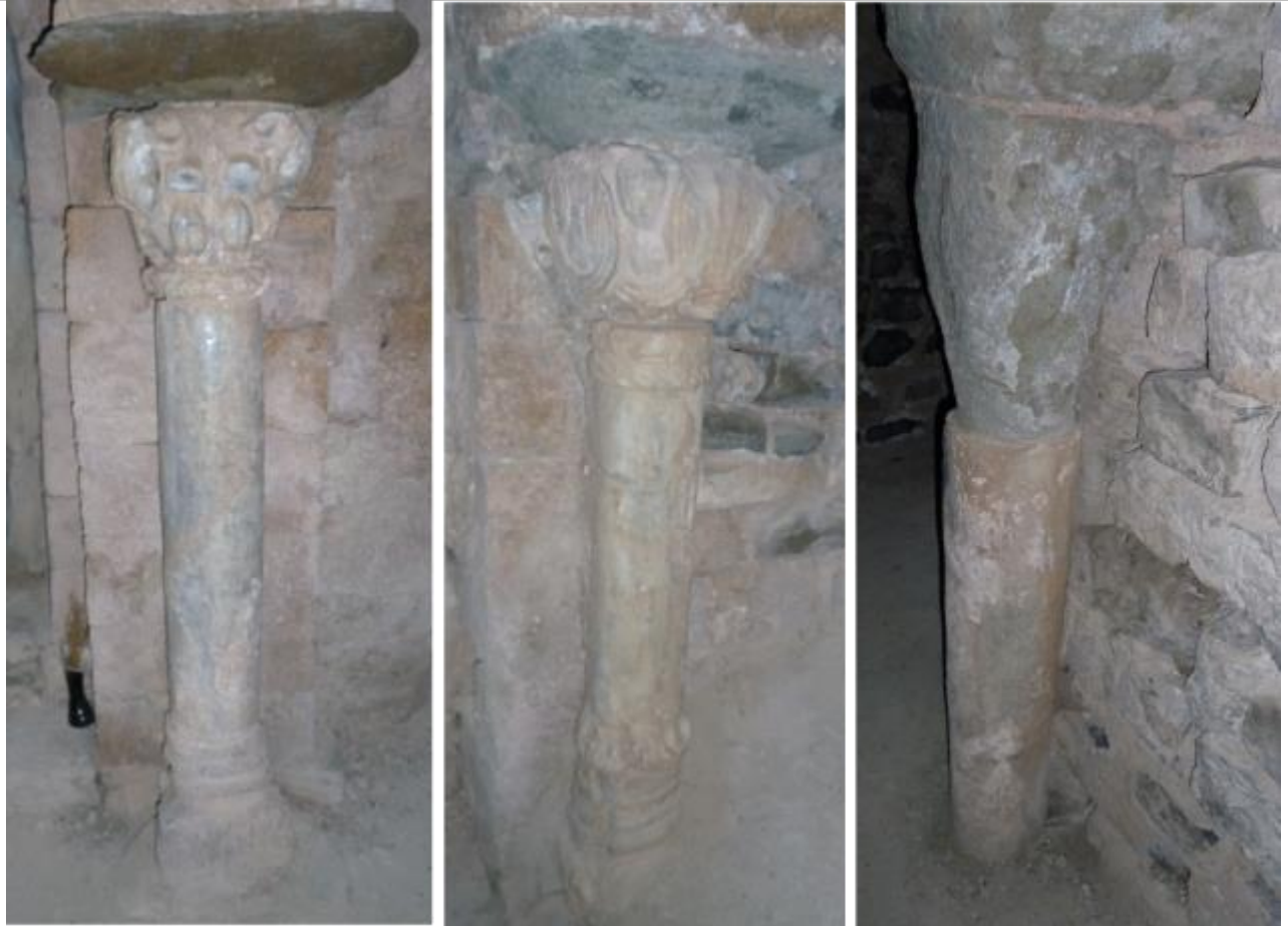
Vues des trois colonnettes, deux chapiteaux et deux bases en albâtre, et des trois tailloirs et du chapiteau en grès gris-verdâtre.
