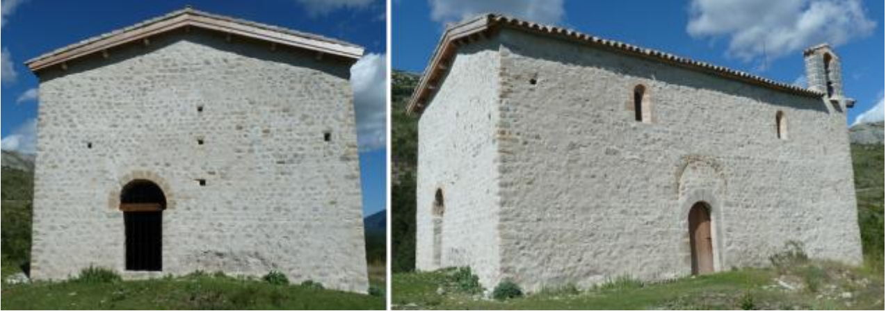
Vues d'ensemble de l'édifice.
