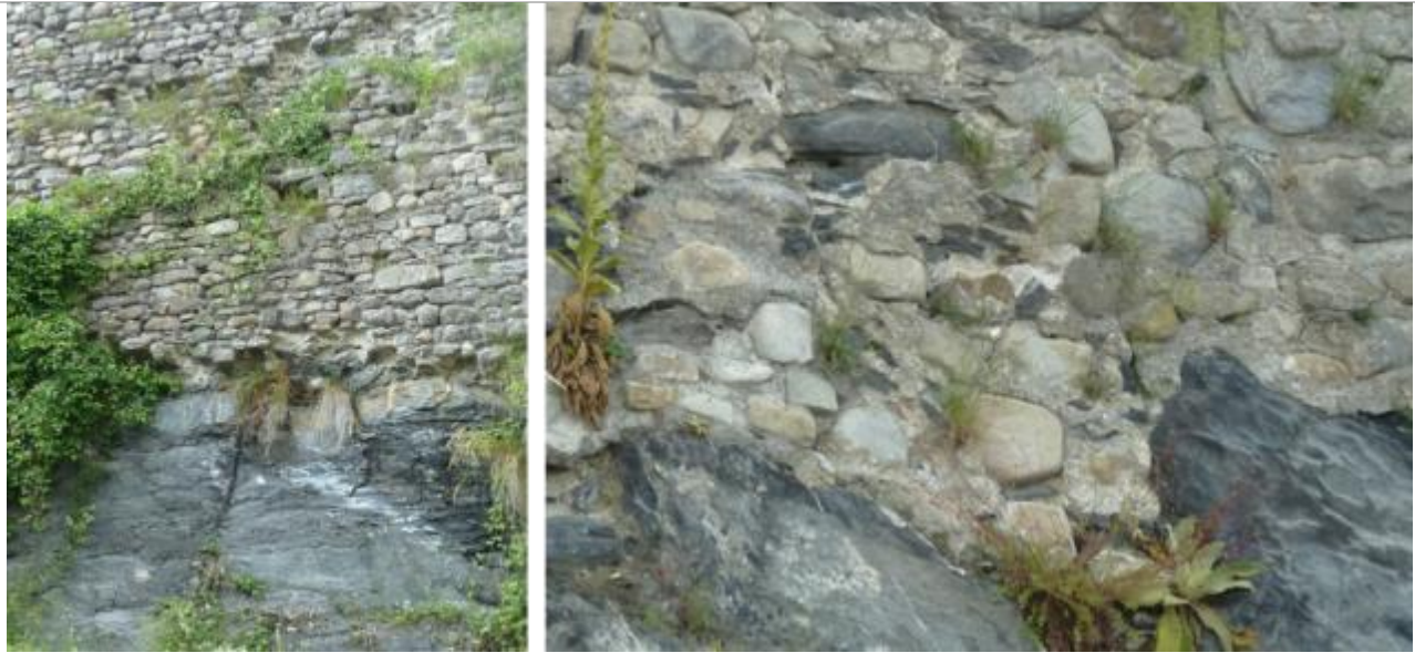
Vue des murs en « tout-venant » issu des dépôts morainiques alentours et calcaires marneux sous-jacents.
