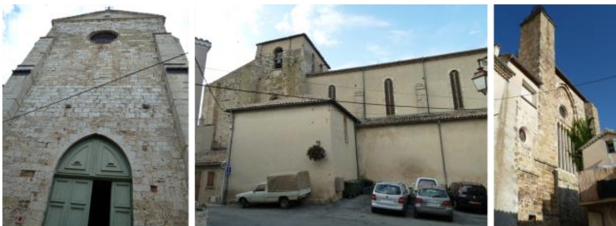
Vues d'ensemble de l'édifice.
