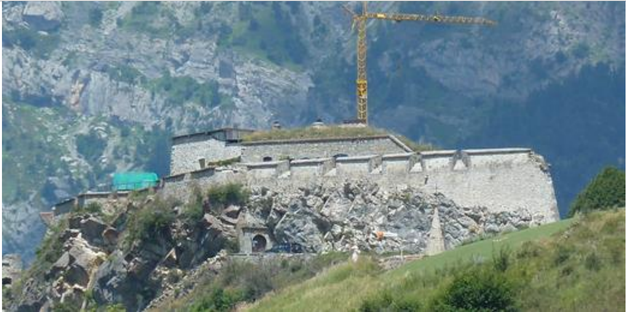
Vue d'ensemble de l'édifice.
