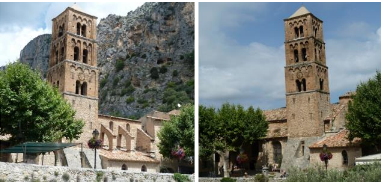
Vues d'ensemble de l'édifice.
