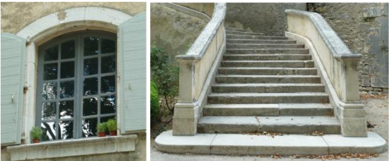
Vues de mise en œuvre au niveau du château du calcaire marmoréen blanchâtre à patine très claire (Portlandien-Berriasien).
