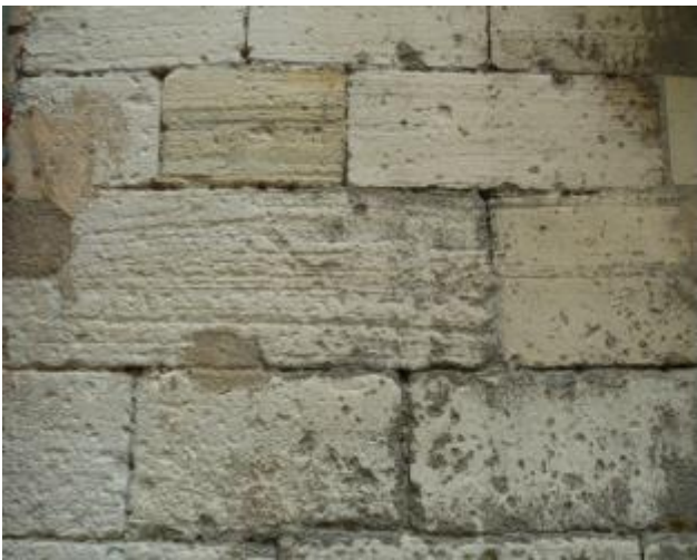
Vue comparée extérieur / intérieur de mise en œuvre du calcaire fin blanchâtre à beige-crème finement lité.
