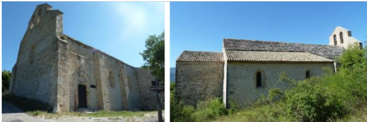
Vues d'ensemble de l'édifice.
