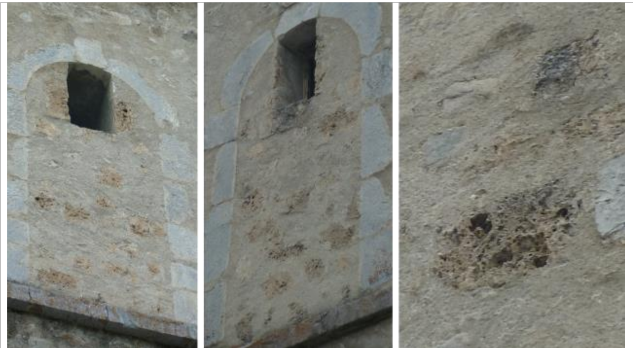
Vues de mise en œuvre au niveau du clocher du tuf beige-ocre vacuolaire.
