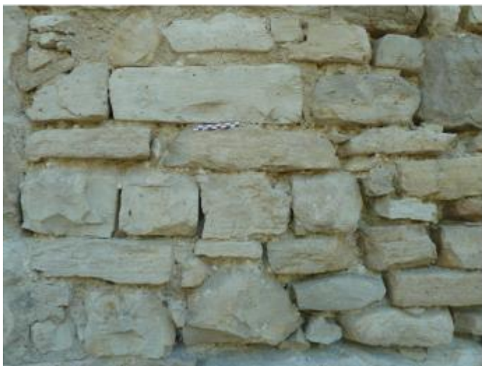
Vues de mise en œuvre des moellons allongés de calcaire beige légèrement marneux, à grain fin, finement lité (Pierre de Fontienne).
