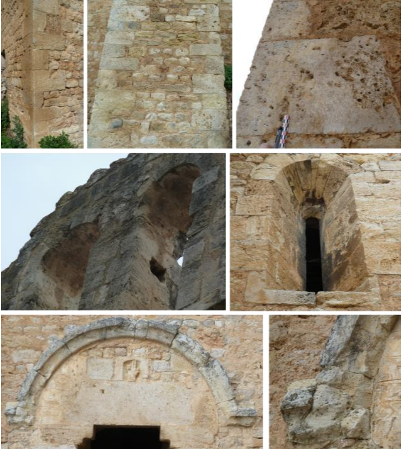
Vues extérieures de mise en œuvre de blocs taillés de calcaire travertineux dur blanchâtre à beige-ocre, plus ou moins caverneux, perforé de cavités millimétriques à centimétriques.
