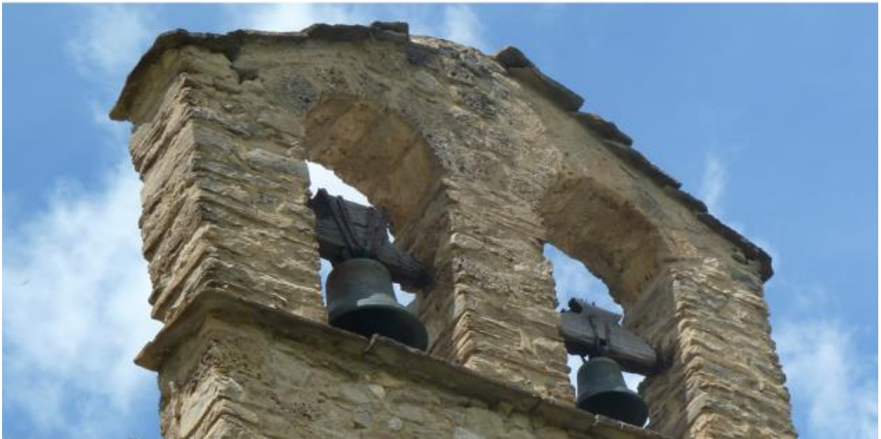
Vue des restes de la couverture originelle en lauzes calcaires.
