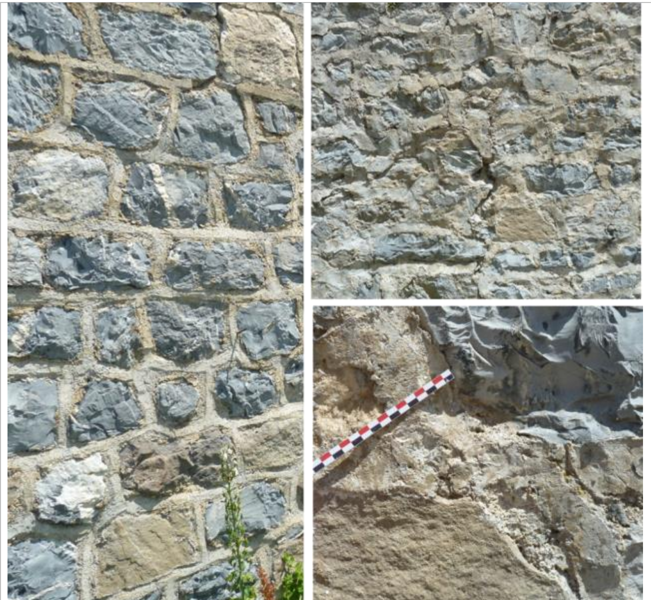
Vues des murs en moellons de calcaire à patine gris-bleuté et des grès à patine beige-orangé.
