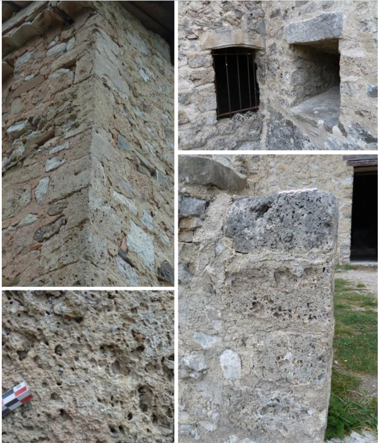
Vues extérieures de mise en œuvre du tuf calcaire.
