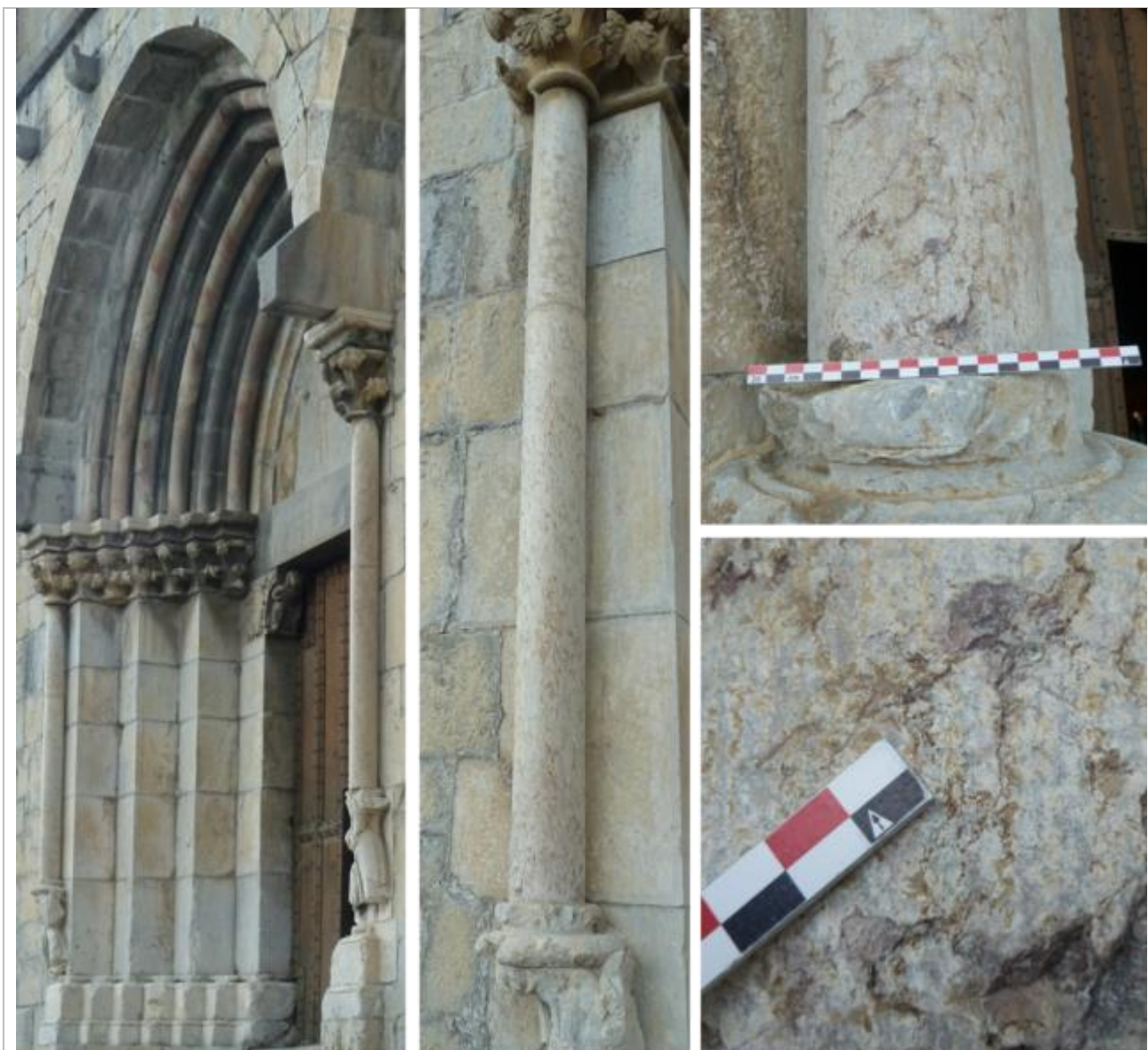
Vue des deux colonnettes en calcaire noduleux rosé de type Marbre de Guillestre s.l.
