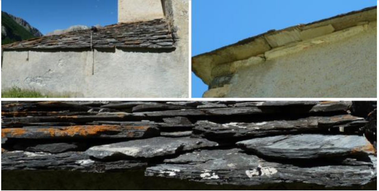
Vues de la couverture en calcschiste noirâtre à débit en lauze et patine grise.
