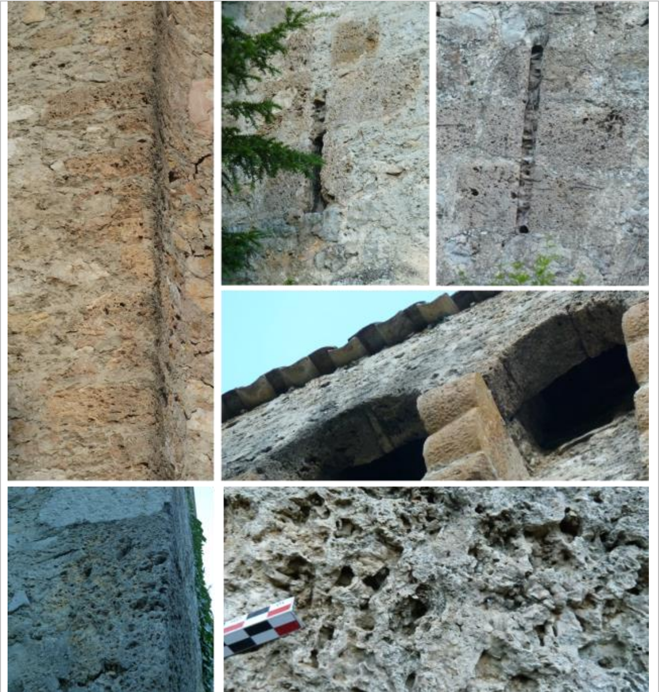
Vues de mise en œuvre du « tuf » (cargneule ?) à patine beige-gris.
