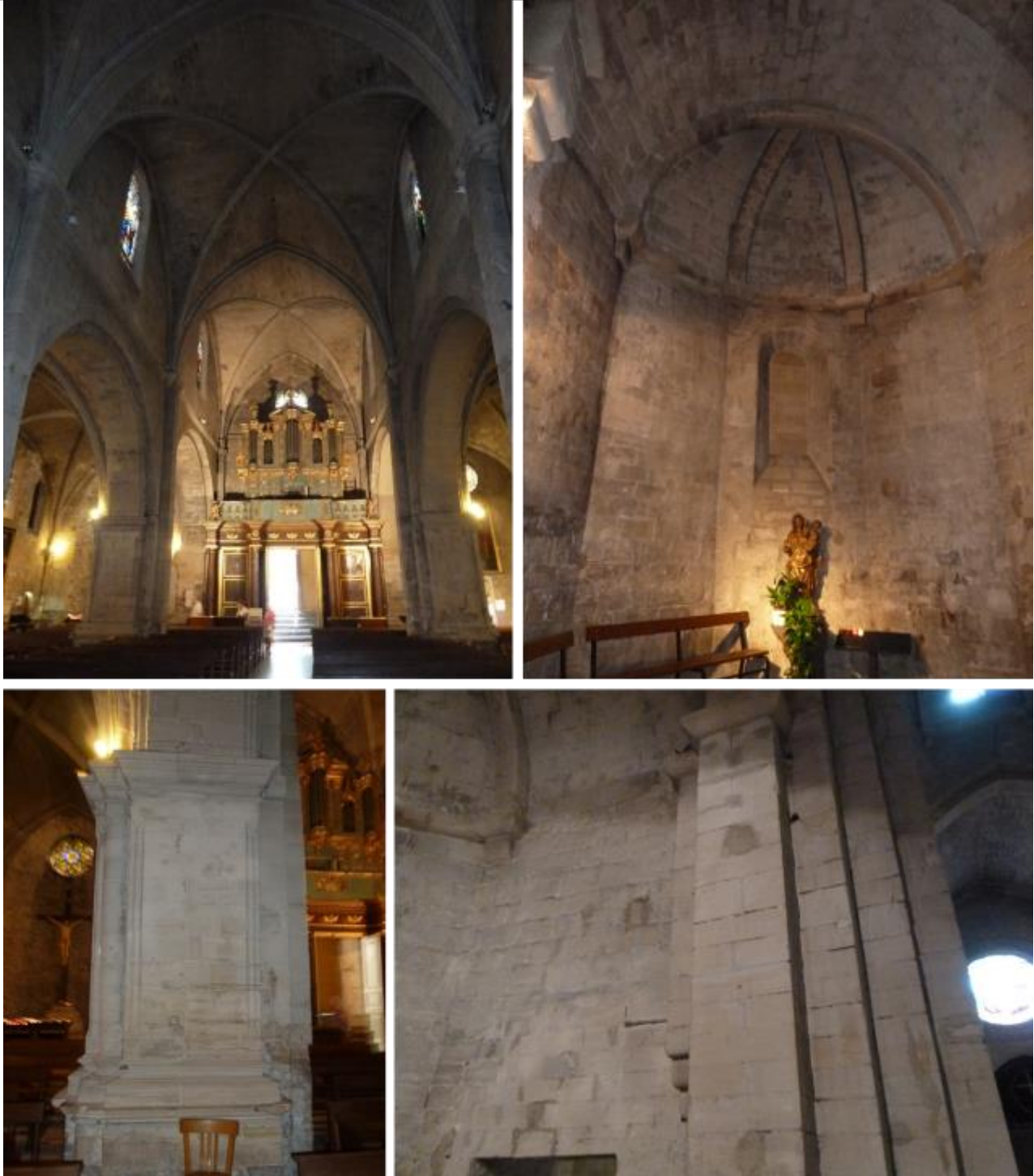
Vues intérieures de mise en œuvre du calcaire fin blanchâtre à beige-crème finement lité.
