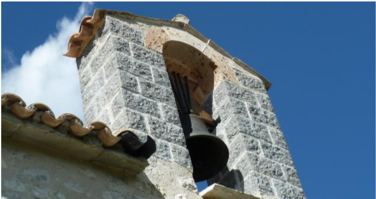
Vues du clocher à arcade restauré en calcaire (à entroques ?) gris-sombre.
