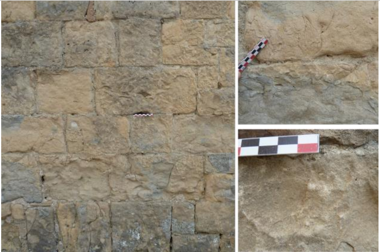
Vues des moellons en grès marno-calcaire brun-roussâtre à zonations grisâtres à grain fin.
