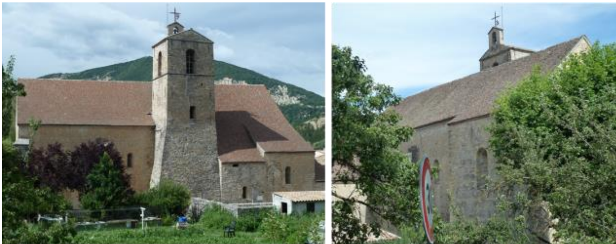
Vues d'ensemble de l'édifice.
