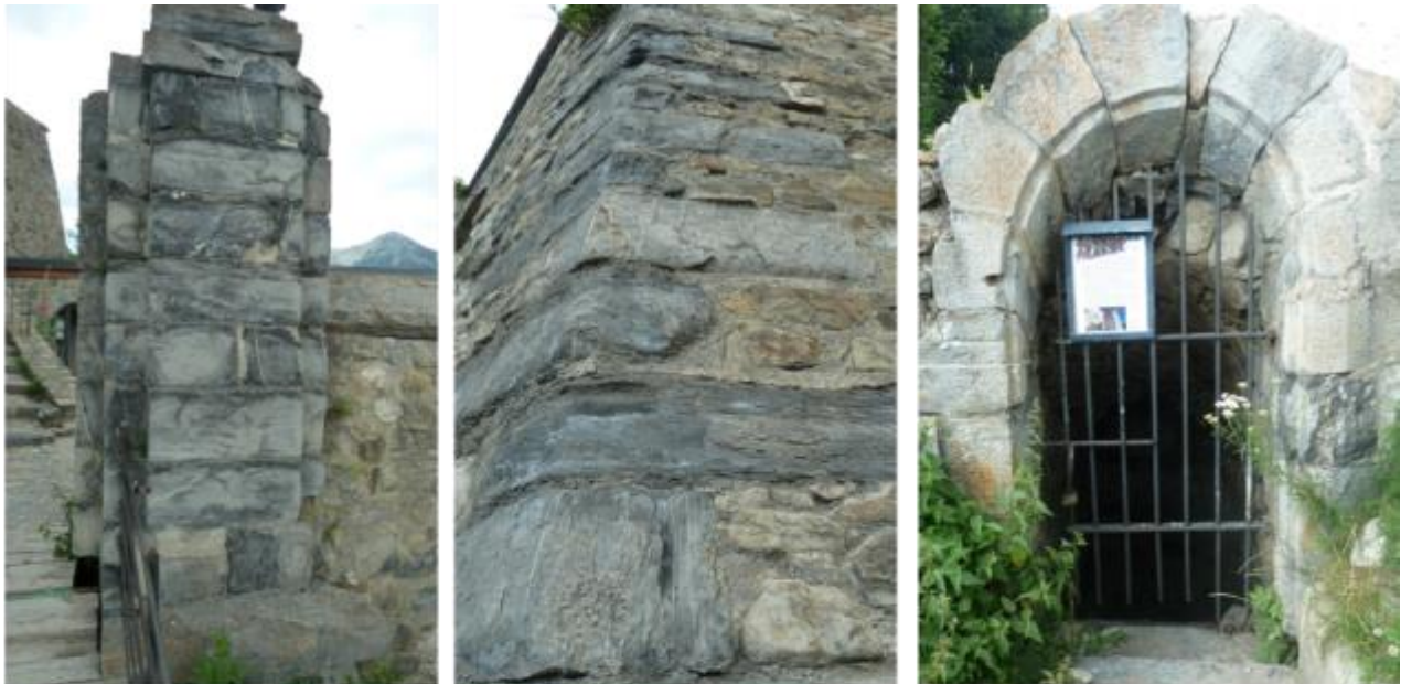
Vue des murs en « tout-venant » issu des dépôts morainiques alentours et calcaires marneux sous-jacents.
