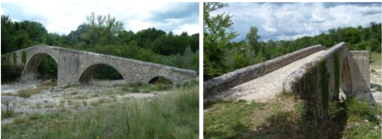
Vues d'ensemble de l'édifice.
