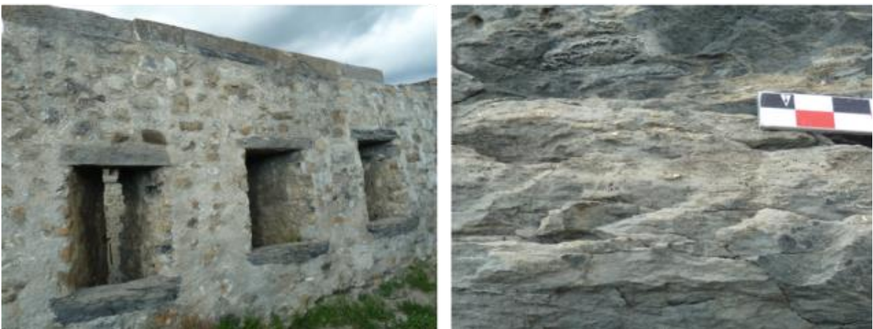
Vues de mise en œuvre sous forme de blocs taillés du calcaire marneux.
