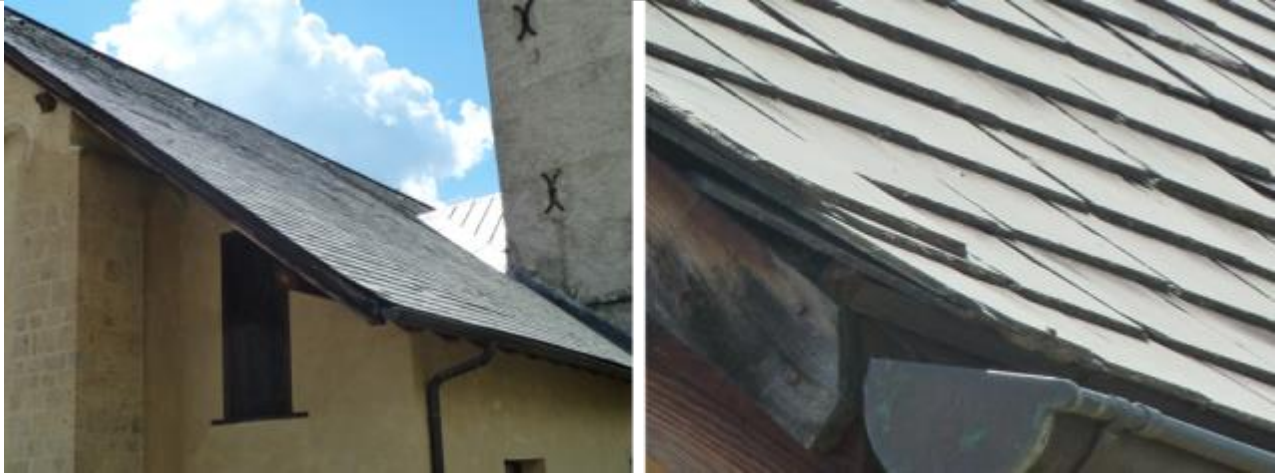
Vues de la couverture en ardoises gris-foncé assez fines refaite en 1983.
