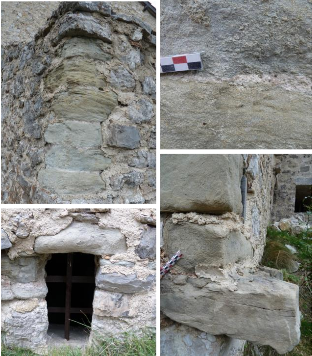
Vues de mise en œuvre extérieure du grès gris-verdâtre.
