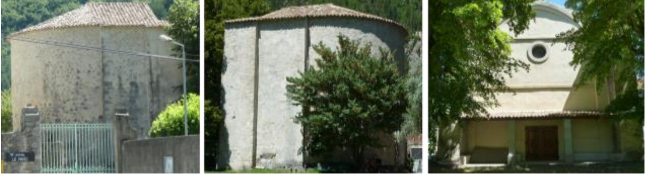
Vues d'ensemble de l'édifice.
