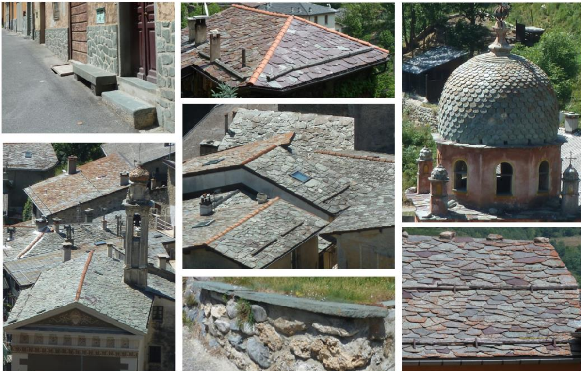
Illustration 4 : Tende – Exemples d'utilisation des pérites de Tende et de Fontan (couverture, revêtement de façade).
