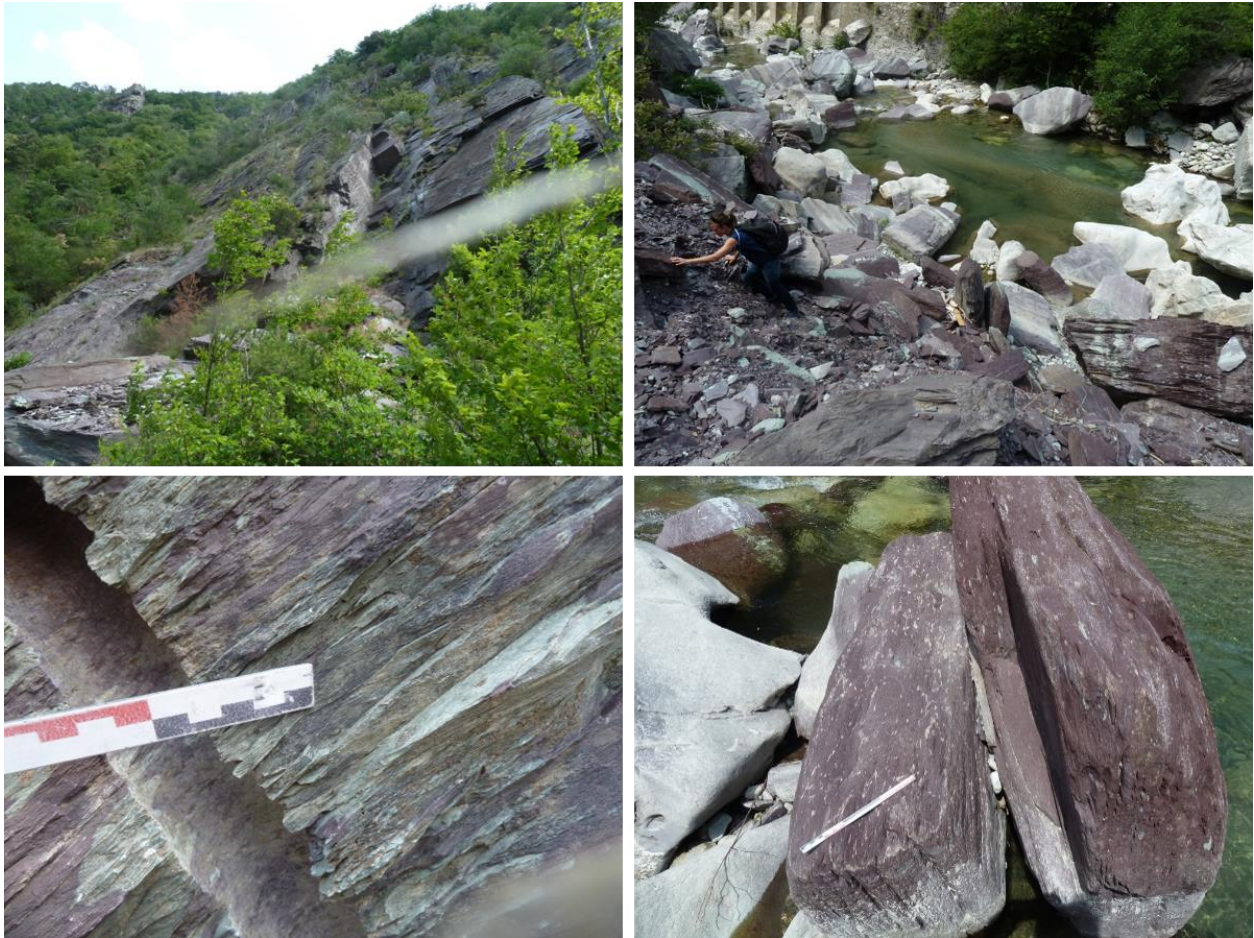
Illustration 23 : Site de l’ancienne carrière des Gorges de Berghe – Fontan, photos du 2 juillet 2018.
