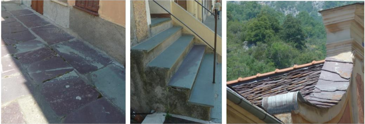
Illustration 5 : Fontan – Exemples d'utilisation des pélites de Tende et de Fontan (dallage, marches d'escalier, couverture).
