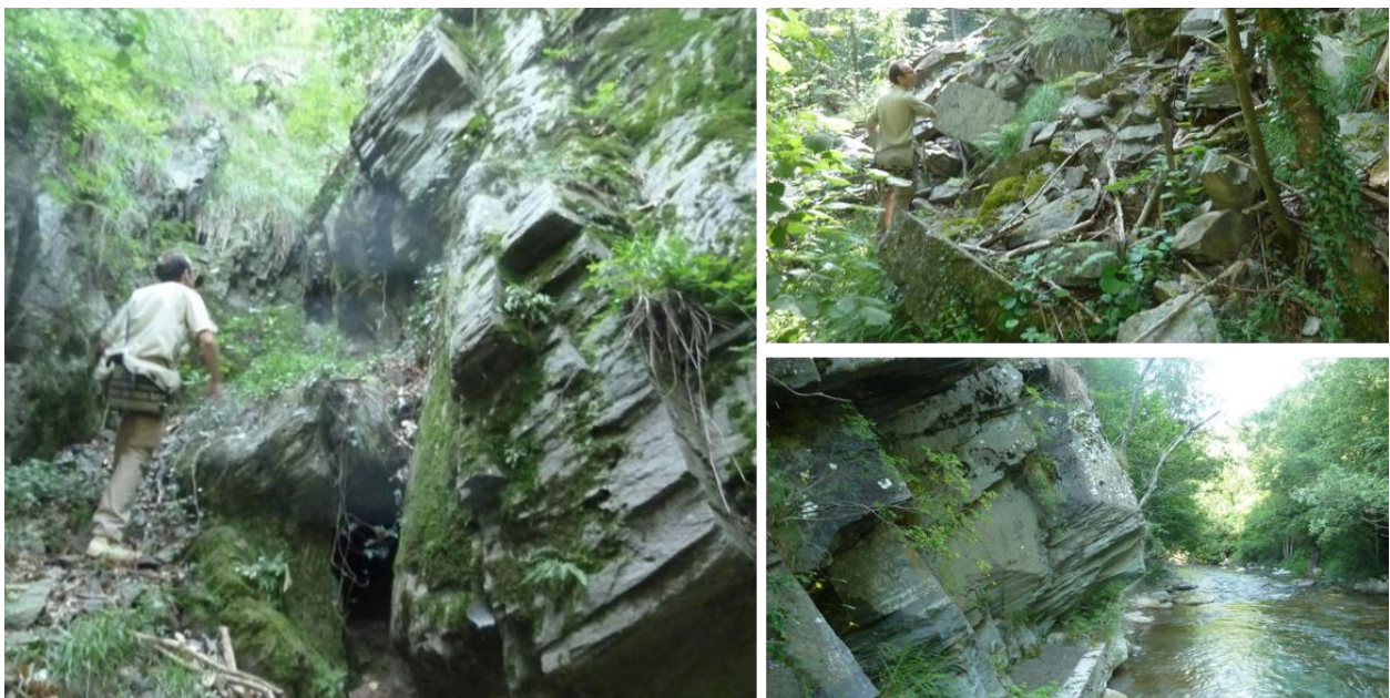
Illustration 14 : Ancienne zone d'extraction en bord de Roya – Tende, front de taille, photos du 3 juillet 2018.
