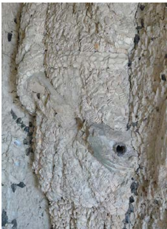
Fig. 27. Rocaillage des modules décoratifs et de la rosace de la voûte. Cliché F. Cranga, 2015.
