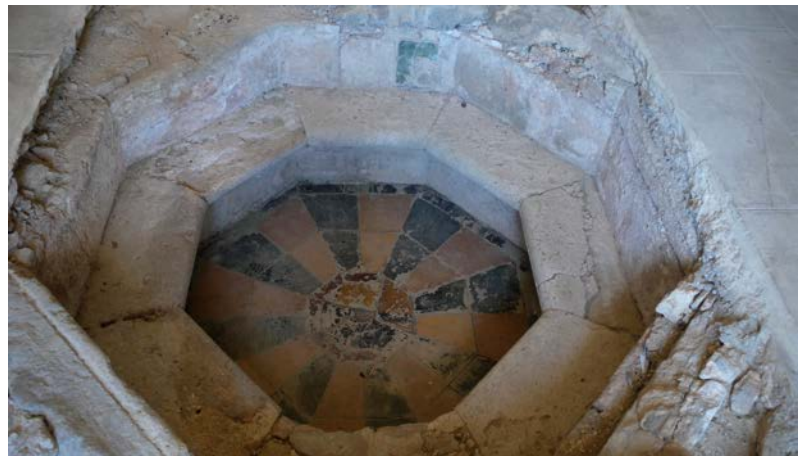
Fig. 27. Rocaillage des modules décoratifs et de la rosace de la voûte. Cliché F. Cranga, 2015.
