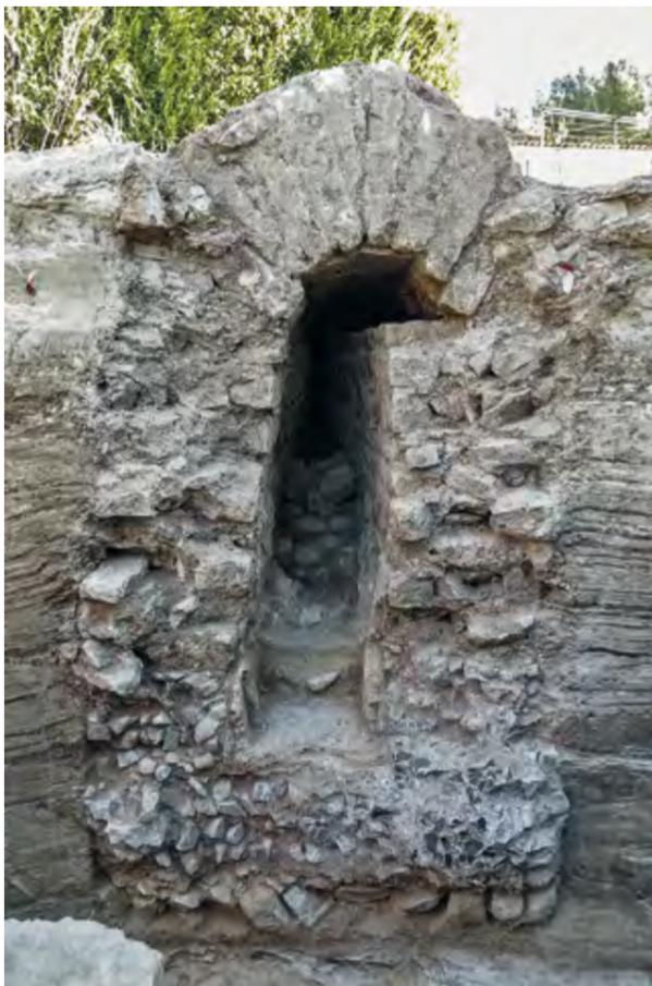
Fig. 60 – AIX-EN-PCE, 1, av. Georges Brassens. Conduit de l'aqueduc au niveau d'un regard, vue depuis le nord-ouest (cliché Cl. Auburtin).
