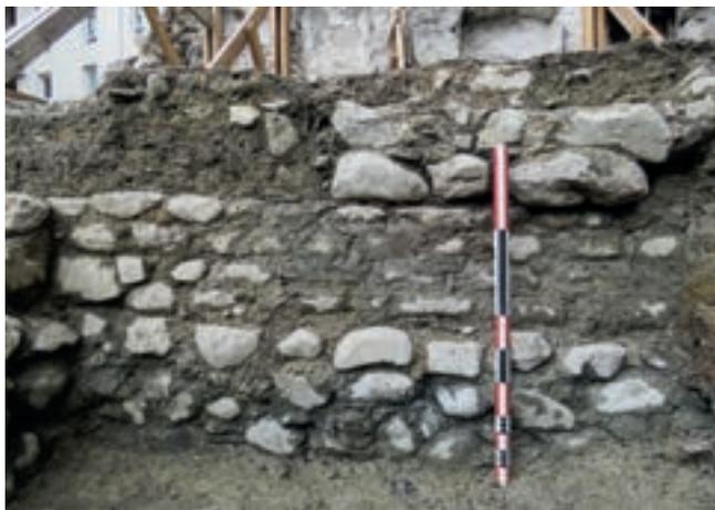
Fig. 23 – EMBRUN, Rue du Théâtre. Élévation et fondation d'un mur de façade du Haut-Empire surmonté par un support de pilier moderne (sondage 2). Vue depuis le sud-ouest (cliché P. Reynaud/Inrap).
