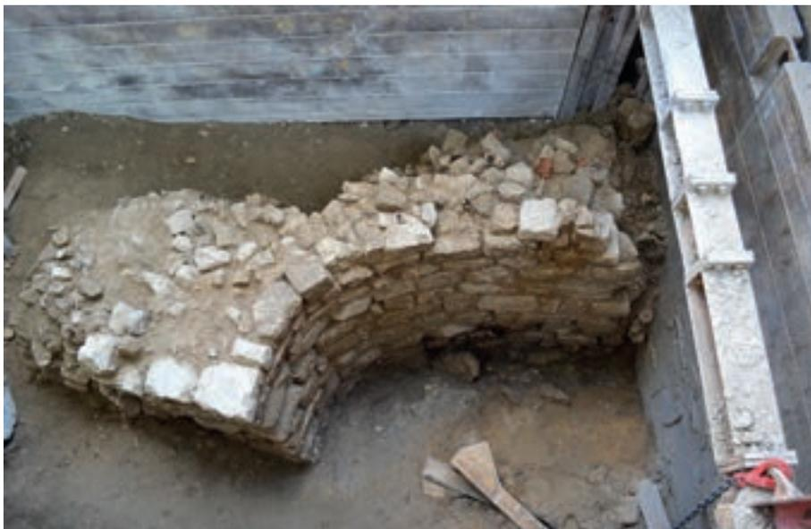
Fig. 81 – AIX-EN-PROVENCE, Place des Prêcheurs et abords. Mur de soutènement en arc de cercle (cliché A. Bouquet/DAMVA).
