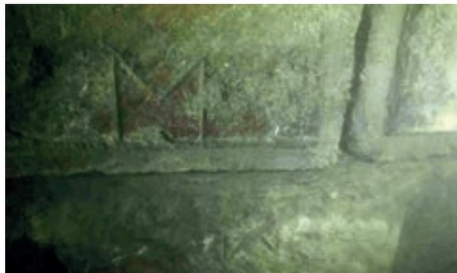
Fig. 93 – ARLES, Carte archéologique du Rhône, traversée d'Arles. Pont de bateaux médiéval, assises de pierres à bossage avec marques de tâcheron (cliché L. Masselin, 2ASM/Explogéo).
