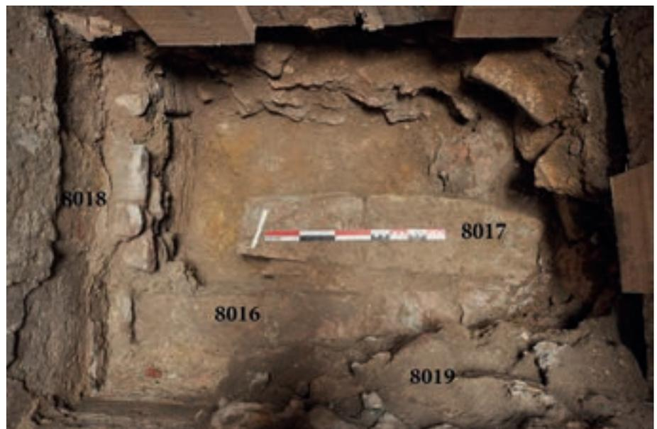
Fig. 117 – MARSEILLE, Cathédrale de la Vieille Major. Fondation de la pile sud-ouest de la première et unique travée conservée (l'US 8016 correspond à la fondation maçonnée de la pile) (cliché L. Deye/Hadès, 2016).
