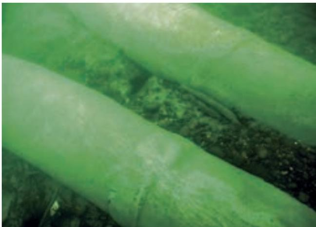
Fig. 92 – ARLES, Carte archéologique du Rhône, traversée d'Arles. Vue des conduites sous-fluviales en plomb RD 9 et 10 (cliché G. Spada, 2ASM).
