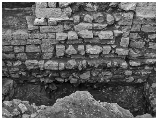
Fig. 175 – LA CELLE, monastère. Vue de l'arrêt de chantier du cloître (cliché M. Borréani / SDACGV).
