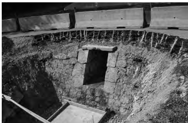
Fig. 227 – LE TIGNET, vallon Saint-Pierre. Caniveau aménagé de la première moitié du XIX e s. (cliché St. Fulconis).
