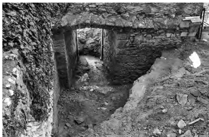
Fig. 195 – BUOUX, château. La porte d'accès à la salle basse et l'escarpement rocheux intérieur (cliché Chr. Markiewicz).
