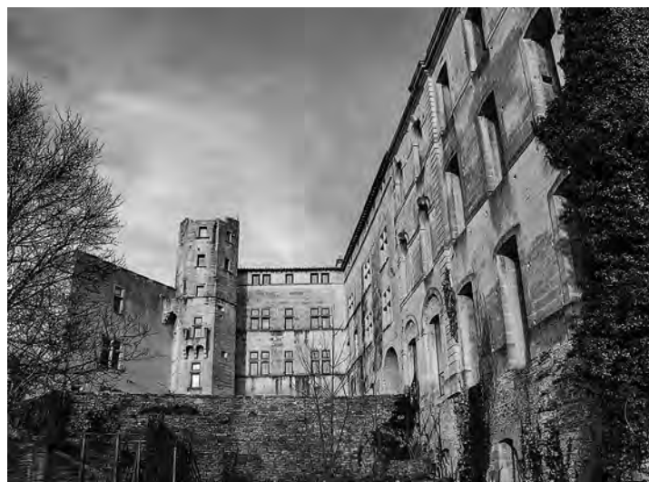
Fig. 194 – BUOUX, château. Vue d'ensemble du château, à droite l'aile inachevée XVIII e s. et le soubassement initial (cliché Chr. Markiewicz).
