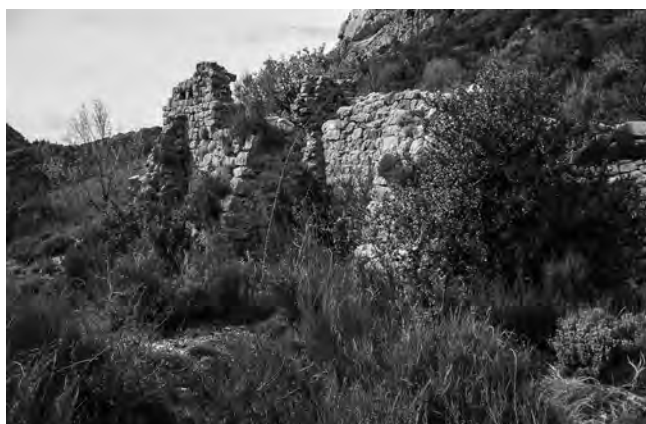
Fig. 228 – BARGÈME, Ferrage-église de Saint-Laurent. Mur gouttereau Sud avec ses contreforts (XI e s.) (cliché St. Fulconis).
