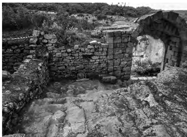
Fig. 196 – BUOUX, Fort. Vue de l'entrée à l'issue des terrassements (cliché Chr. Markiewicz).
