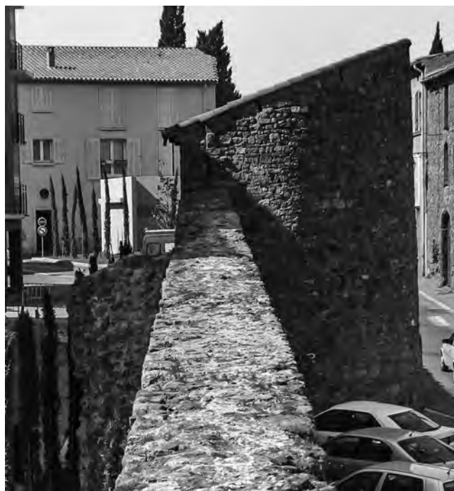
Fig. 186 – FRÉJUS, rue Aubenas : tour médiane. Vue de la tour dans le prolongement du mur d'enceinte (cliché P. Excoffon / SPVF).
