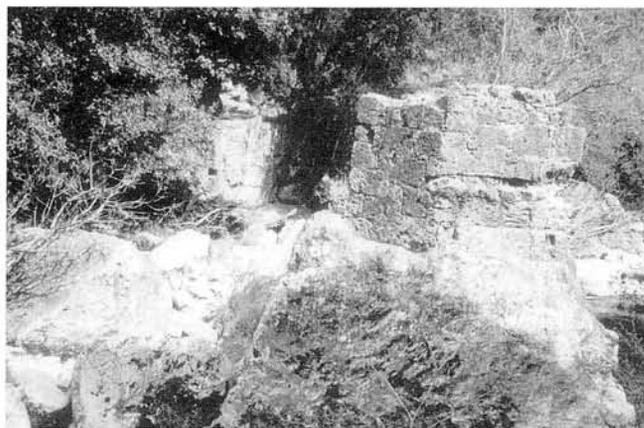
Fig. 132 – HAUTE VALLÉE DE LA SIAGNE, voies de communication. Le Veirachon, pont médiéval. Au premier plan, la pile ; au fond, la culée de rive gauche dans la végétation. Noter le trou de boulin dans le rocher, sous la pile (S. Fulconis).
