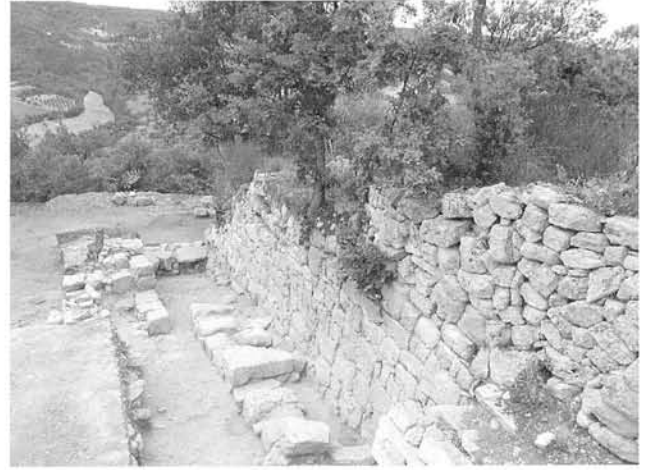
Fig 132 – Territoire antique au confluent Calavon-Enchrême. Viens, Vache d'or. Vue vers l'ouest du dispositif d'entrée de l'oppidum. Les blocs en avant de la courtine correspondent au renfort de l'Antiquité tardive.
