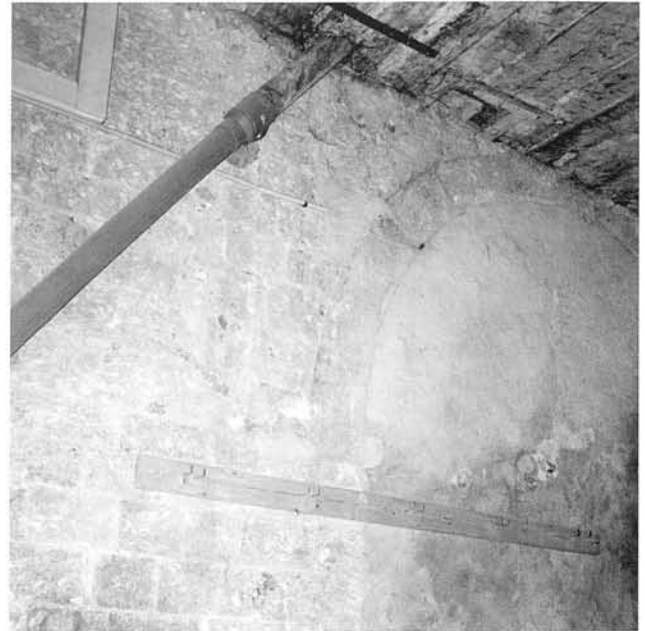
Fig. 65 – CUERS, place de la Convention. Façade médiévale percée d'un grand arc.
