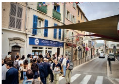
Réaménagement d'une rue étroite et passage à l'aide de voiles temporaires à Cuers.
