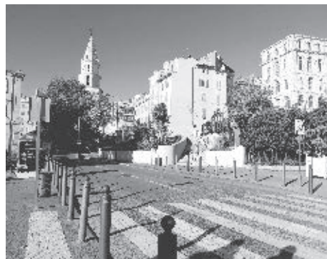
Des recommandations spécifiques ont également été formulées sur différents sous-ensembles de la rue Caisserie.
