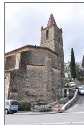
Orientée au nord-est, d'une longueur de 41,90 m et d'une largeur de 20,50m, l'église est constituée d'une grande nef unique à quatre travées, flanquée de chapelles latérales communicantes ; d'un chœur comprenant une travée droite ouvrant de part et d'autre sur le clocher et la sacristie, et une abside à trois pans. Le clocher est une haute tour de plan carré abritant un escalier en vis sur noyau.
