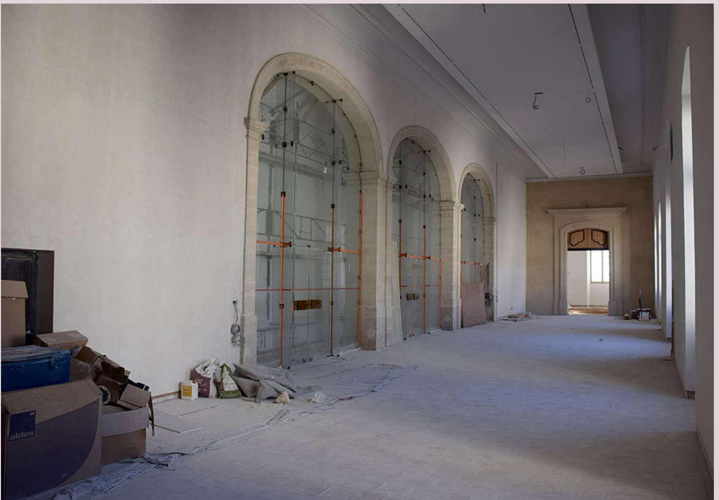
Chantier Hôtel Dieu de Carpentras – Septembre 2021
