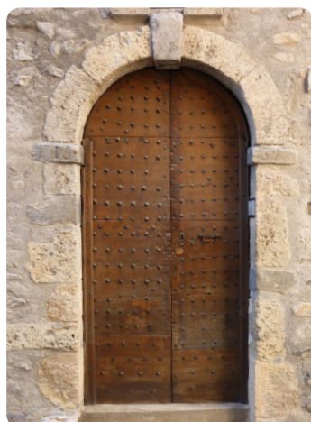
Porte à doubles lames croisées et clous forgés - Arc en plein cintre -
