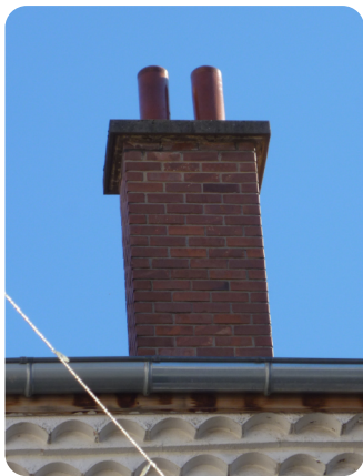
Souche de cheminée Maçonnée, section carrée ou rectangulaire, et enduite / peinte dans une teinte sombre mate
