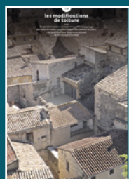
14 les modifications de toiture
