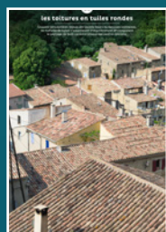
05 les toitures en tuiles rondes
