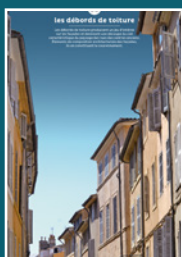
06 les débords de toiture
