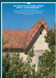
16 les toitures en tuiles plates dites marseillaises
