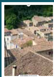
05 les toitures en tuiles rondes
