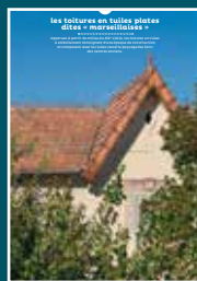
16 les toitures en tuiles plates dites marseillaises
