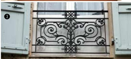
Les garde-corps de fenêtres sont très exposés aux intempéries. Plus le décor est riche plus il est fin et fragile. Quant il participe à la structure, sa détérioration peut entraîner la ruine de l'ensemble.
