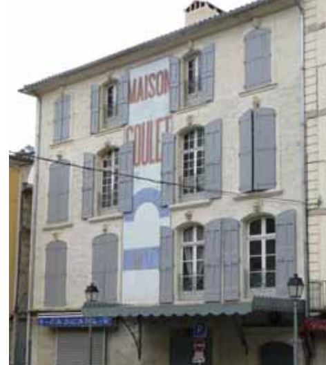
L'immeuble « maison Coulet » place des 3 six, conservation des menuiseries des XVIII e et XIX e siècles sur rue et restitution des croisées à meneaux sur cour en lien avec la découverte de plafonds peints.
