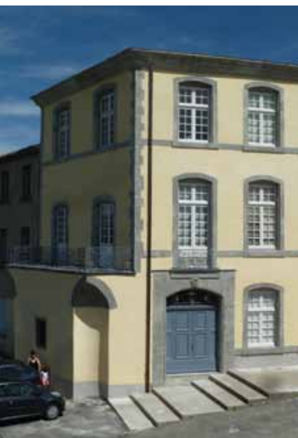
Façade sud et pignon occidental en retour.
