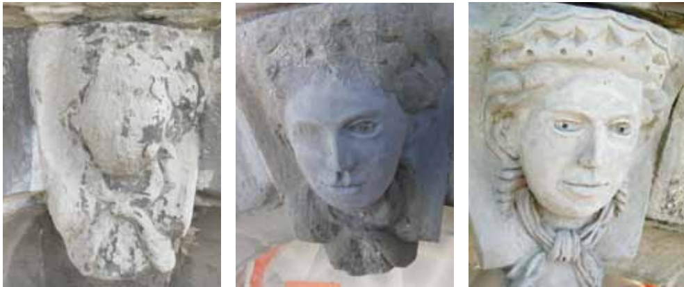
Mascaron de la travée centrale avant, en cours et après intervention.
