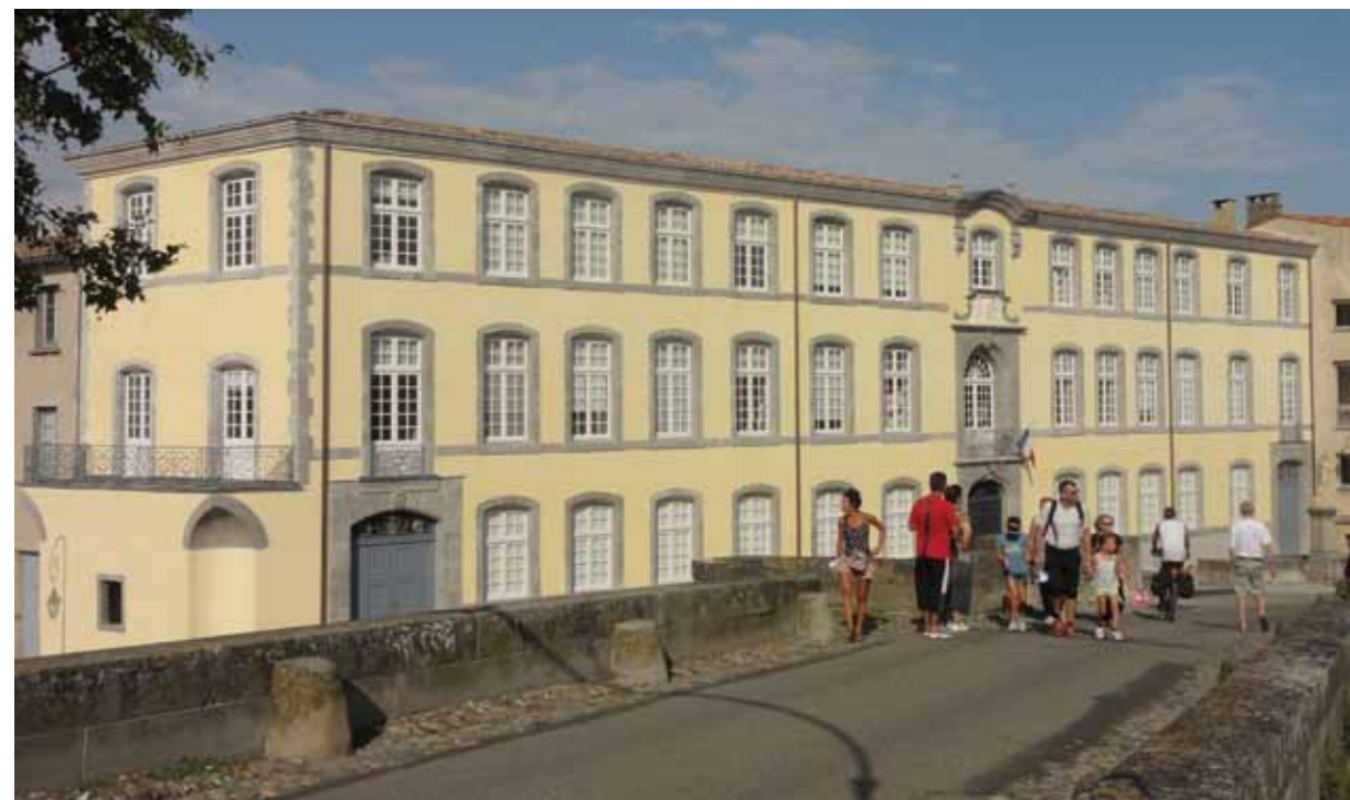
Vue générale de la façade sud.
