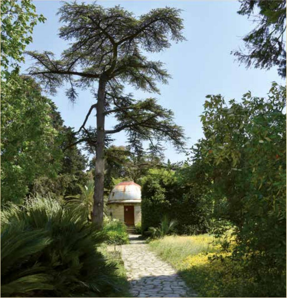
planétarium se présente sous la forme d'un petit bâtiment de plan circulaire construit en maçonnerie de pierre de taille et couvert par une coupole métallique. Son dôme fut construit à Toulouse par le célèbre mécanicien – serrurier Wibratte. Le télescope de Foucault, de 20 cm de diamètre et d'une focale de 13 cm, qui fut mis en place a été réalisé dans les ateliers de l'observatoire parisien par les
