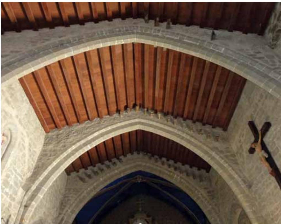
L'église de Couffoulens est un bon exemple du sort complexe réservé au couvrement des églises méridionales. Les corbeaux en place révèlent l'emplacement de la charpente primitive ; au-dessus, les traces des voûtes sur les murs gouttereaux avec la surélévation. La couverture actuelle, des années 1970, vient encore au-dessus.
