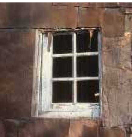
Cabane, détail d'une paroi en bidon déroulé.
