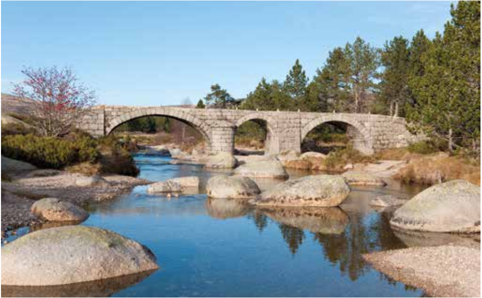
Le pont du Tarn sur le Mont Lozère.
