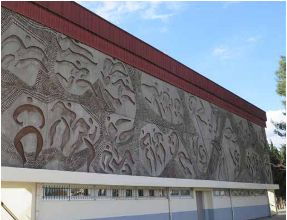
Mur des tribunes du stade de Vauvert (Gard).
