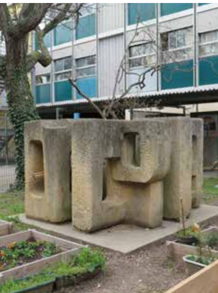
Ecole du Clos d'Orville, Nîmes (Gard) : La Volière et détail du mur sur rue.
