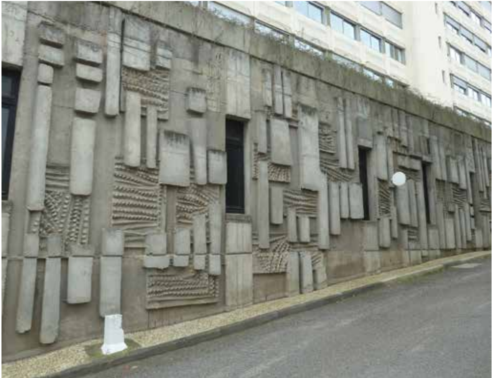
Mur de la résidence Le Parc des Cèdres, Nîmes (Gard).
