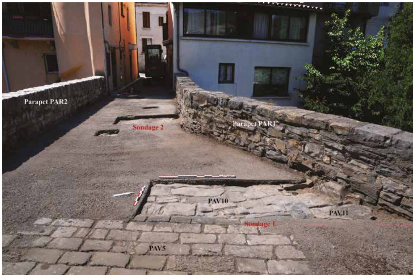
Millau, le Pont Vieux. Les sondages 1 et 2 après enlèvement de l'enrobé.
