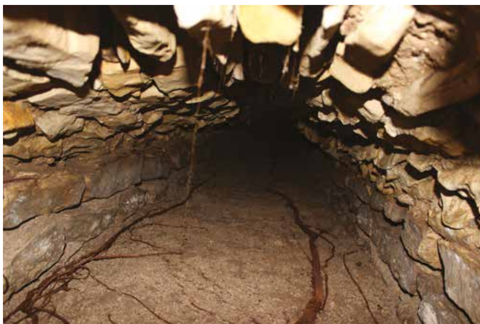
Cahors, 110 rue des Capucins. Vue de l'intérieur de l'égout.
