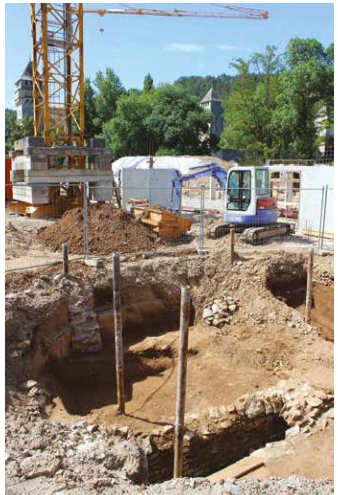
Cahors. 113 avenue A. Breton. Hôtel Best Western. Vue générale de l'intervention. Au fond de l'excavation, l'égout antique (© L. Guyard – Département du Lot).
