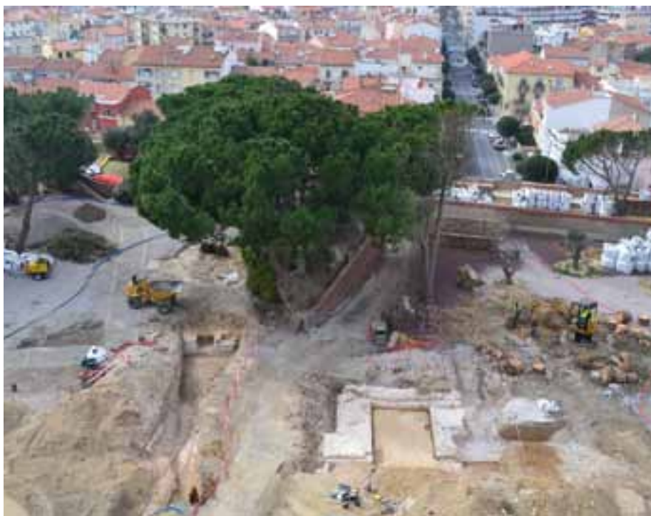
Fig. 1 : Vue générale des jardins du palais en cours de travaux. On distingue au centre le porche, à droite le tracé du rempart et au-dessus, dans la tranchée, le mur de contrescarpe qui maintient la rive ouest de l'ancien fossé. (PAD 66)
