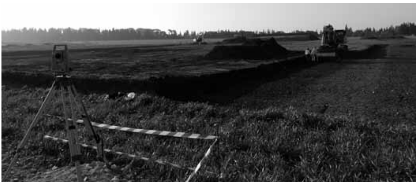
Fig. 1 : Mas de Vouland, Nîmes : vue générale de la fouille mécanisée, avec tachéomètre en station et trois pelles mécaniques dont deux à l'ouverture et une troisième à la gestion des déblais.
