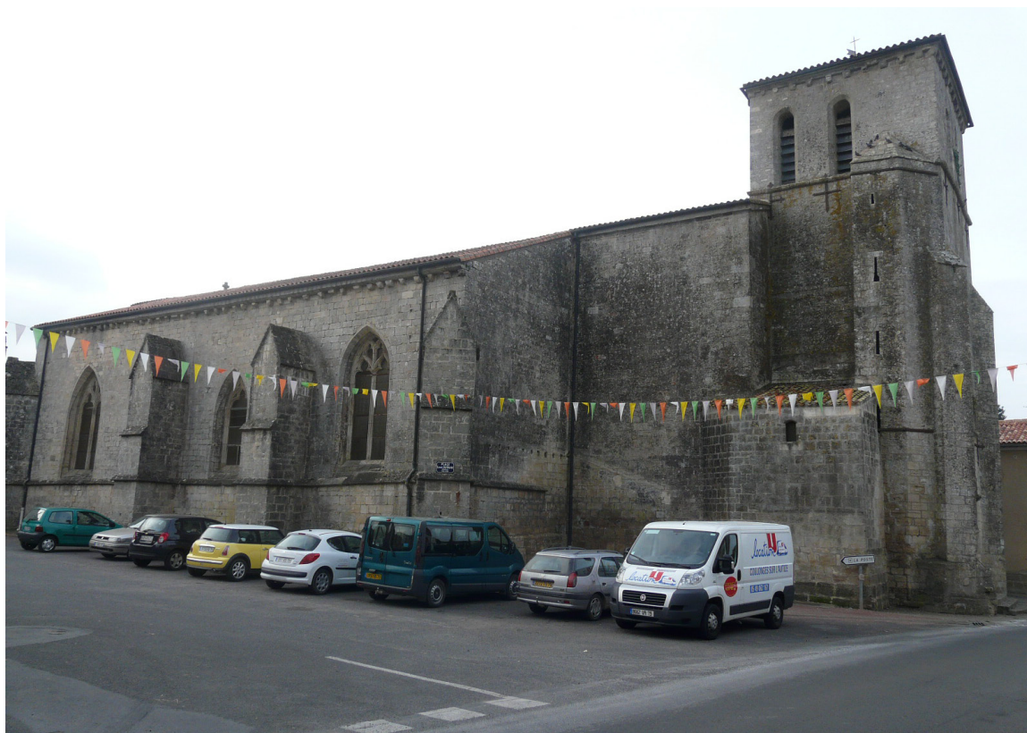
Élévation nord-est de l'église
