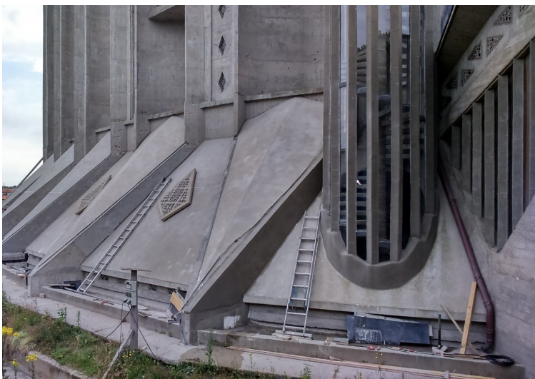
Vue des nouvelles toitures du bas-côté nord
