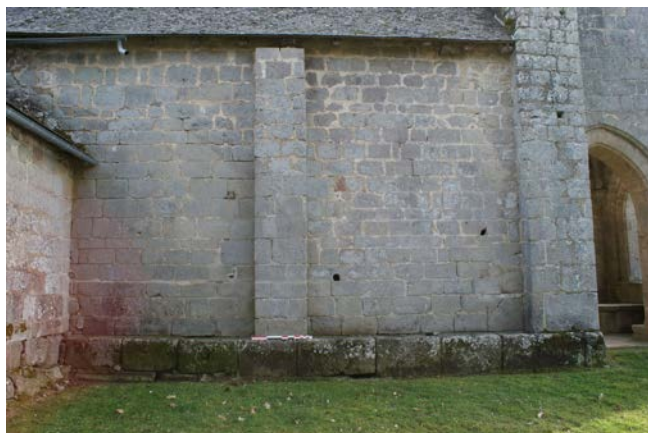
Fig. 1 : vue du mur gouttereau nord de l'église de Liginiac (19) ; la base de la maçonnerie est construite exclusivement avec des blocs antiques de grand appareil.
