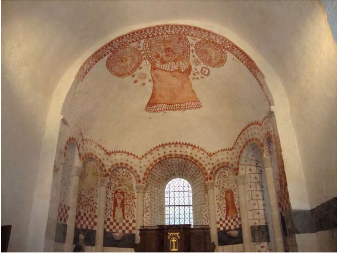
Choeur de l'église de Sagnat (Creuse) après travaux de restauration
