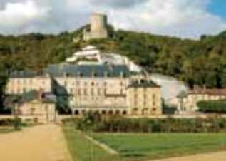
Château de la Roche-Guyon
