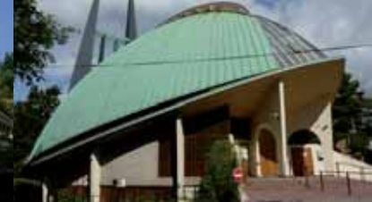
Eglise Notre-Dame-du-Chêne à Viroflay, Sainsaulieu architecte
