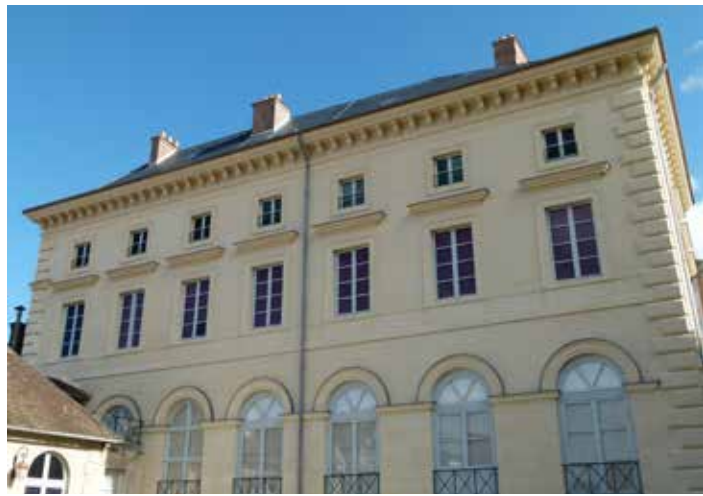
PALAIS DU ROI DE ROME - FAÇADE PRR APRÈS RÉNOVATION-2012 OCT © M. BOURGUELLE
