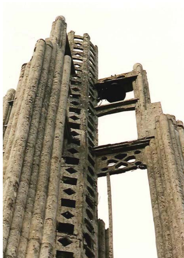
Dégradations du clocher (1996)
