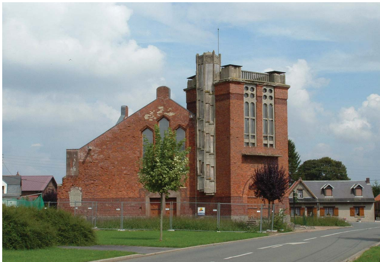
Déconstruction de la tour du clocher - mise en sécurité de l'édifice (2002)
