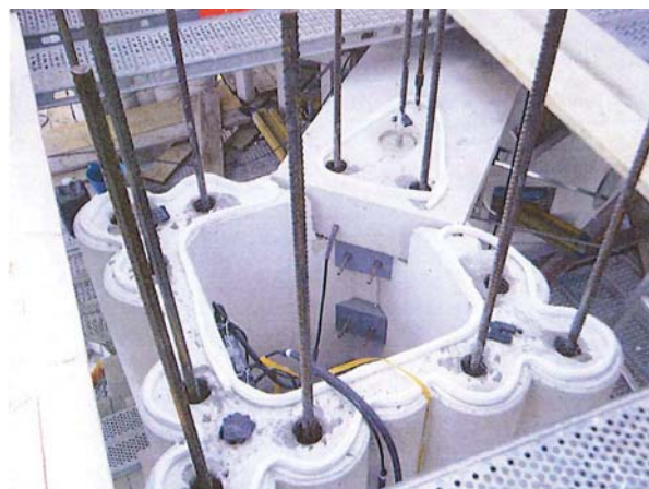
Piliers : étrésoillons en cours
