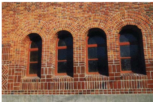
Fenêtres Sacristie, façade Sud.
