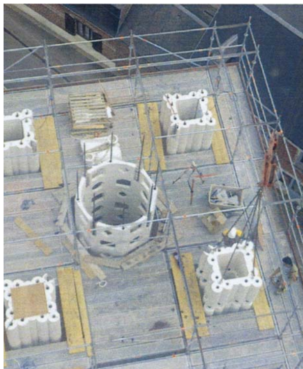
Pose des éléments
