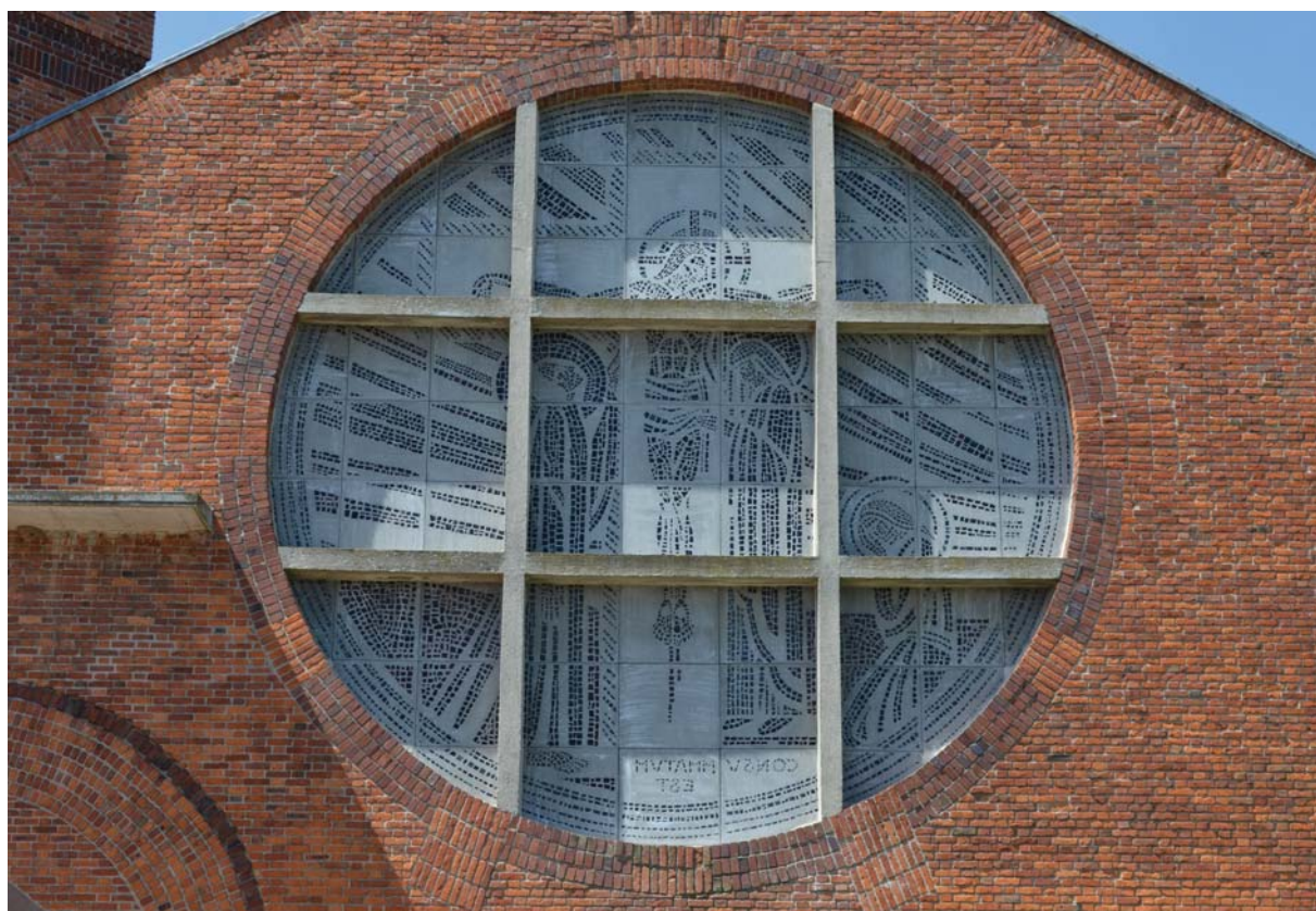
Rosace façade sud après restauration - Vue extérieure
