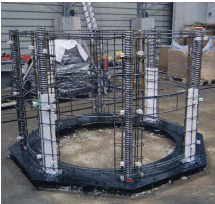
Coffrage ferrailage tour centrale
