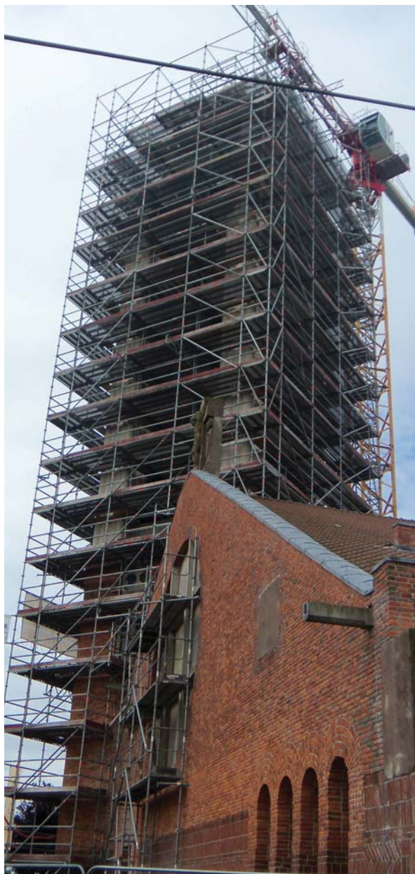
Montage de l'échafaudage suivant la pose des éléments de la tour du clocher.
