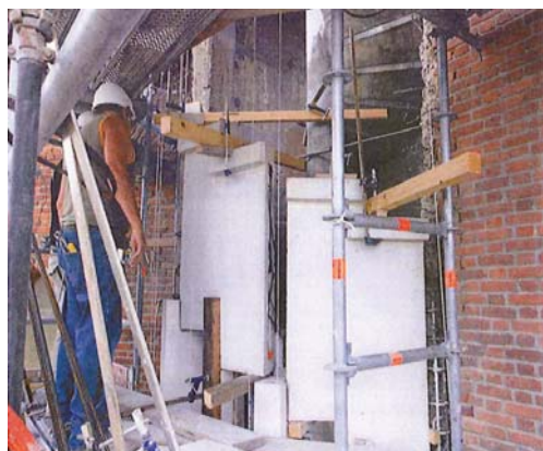
Montage de la cage d'escalier
