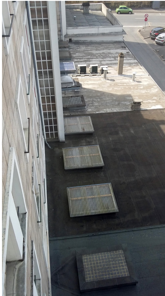
Îlot 17: toiture terrasse à R+1 visible depuis les étages supérieurs.
