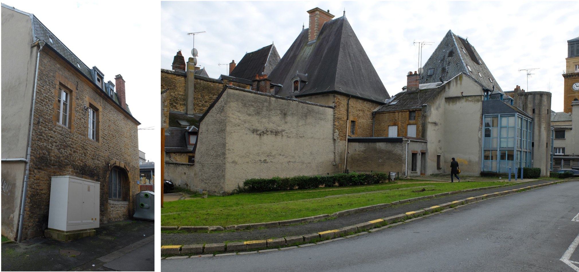
Rue de l'orme et rue Euskirchen. État actuel.
