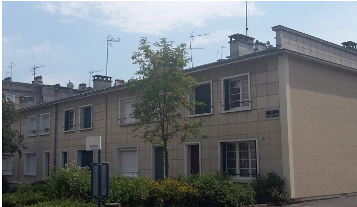
1 à 15 (impairs) rue du Rethélois (îlot 16)
