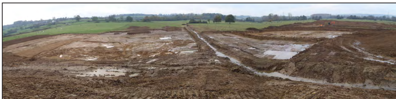
PROLONGEMENT DE L'A34 : REMILLY-LES-POTHÉES Le Mazy Vue du nord de l'ensemble de l'opération (cliché : Y. Rabasté, Inrap)
