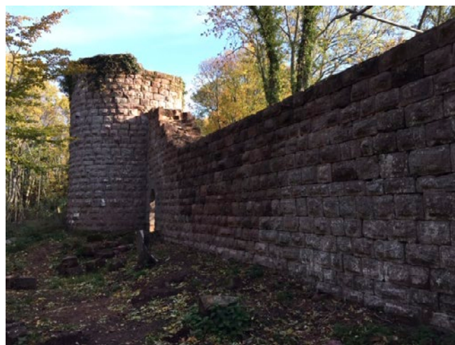
MOLLKIRCH, château du Guirbaden Mur M01, parement extérieur après remontage (cliché : G. PERALS)
