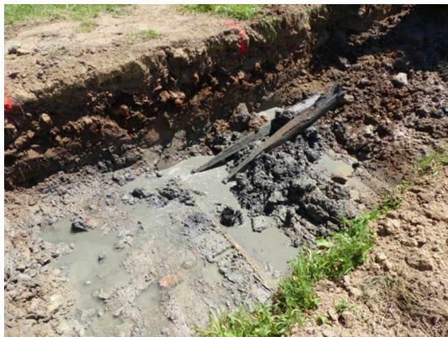
SOULTZ-SOUS-FORÊTS, rue de la Saline Vue des pieux de fondation du château des barons de Fleckenstein, en cours de dégagement. Ils sont datés par dendrochronologie de 1259 (cliché : N. STEINER)
