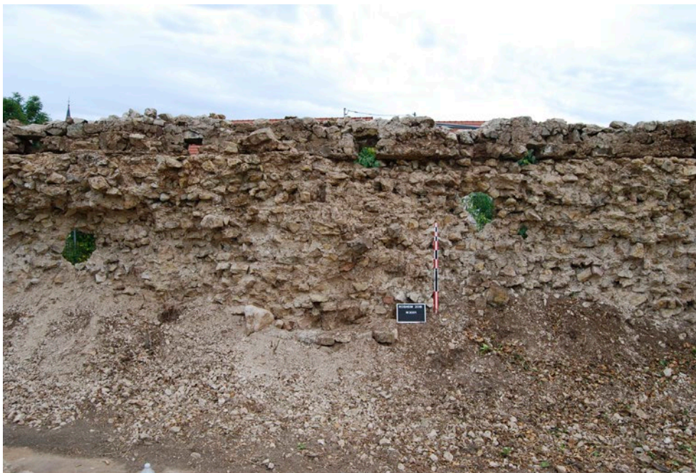
ROSHEIM, enceinte extérieure Portion dégradée de l'enceinte avant le démontage, 2016 (cliché : A. LORPHELIN)
