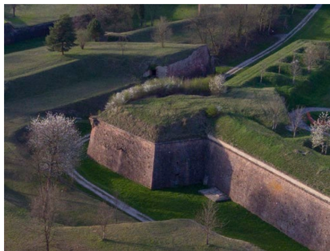
NEUF-BRISACH, fortifications, tour bastionnée n° 6 Photographie de la tour bastionnée n° 6, mars 2017 (cliché : J.-M. BALLIET)
