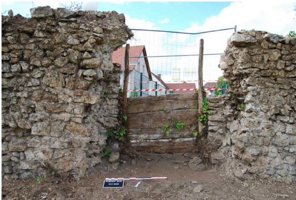
ROSHEIM, enceinte extérieure Ouverture aménagée dans l'enceinte, 2016 (cliché : A. LORPHELIN)
