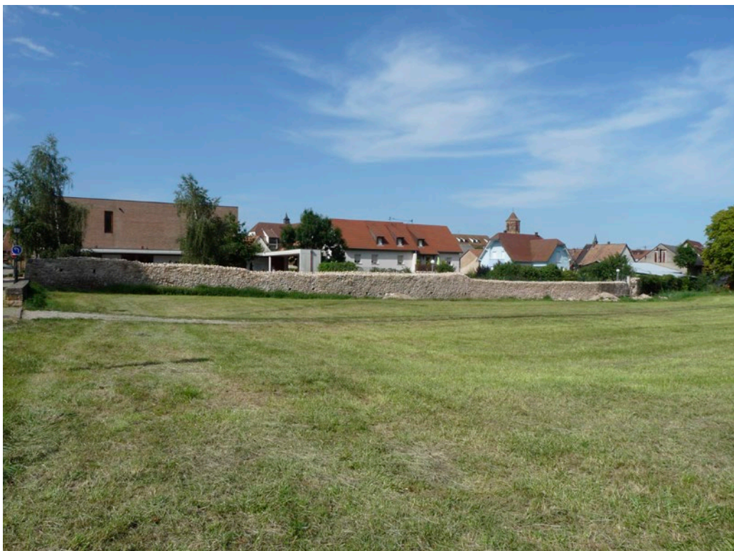
ROSHEIM, enceinte extérieure L'enceinte de Rosheim après la restauration, 2017 (cliché : A. LORPHELIN)
