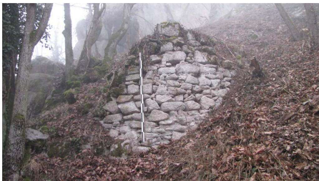
SCHERWILLER, château du Ramstein Tourelle sud-est avant intervention (cliché : C. FREY)
