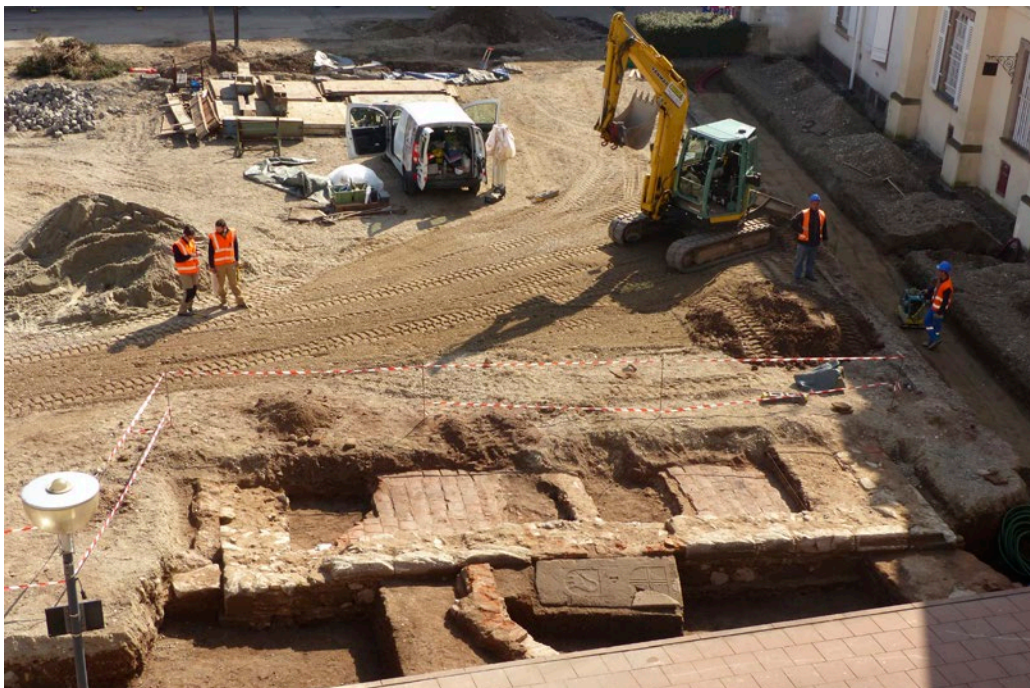
SÉLESTAT, place Gambetta, place du Vieux-Marché-aux-Vins et boulevard du Général Leclerc (zone 1) Vue de l'église des Hospitaliers de Saint-Jean de Sélestat depuis l'ouest (cliché : A. VUILLEMIN)
