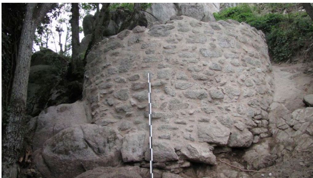
SCHERWILLER, château du Ramstein Tourelle sud-est maçonnée et jointoyée (cliché : C. FREY)
