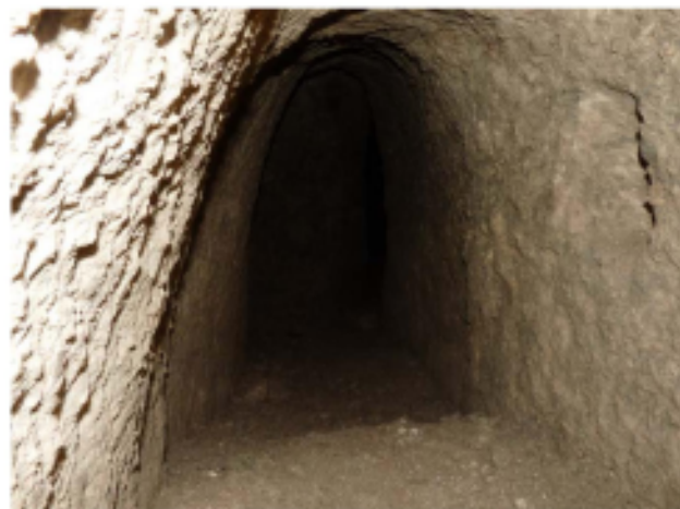
Galerie et aménagement de paroi (2)
