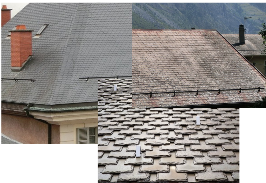
Ardoises d'Angers utilisées à Chambéry Ardoises de Maurienne et détail d'ardoises de Morzine
