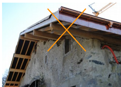
Surépaisseur en débord de toiture formant caisson
