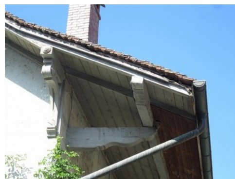
Chablais Débord de toiture et zinguerie Large avant toit en tuiles ligaturées
