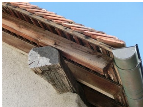
Avant-Pays Savoyard Détail de rive et débord de toiture en tuiles
