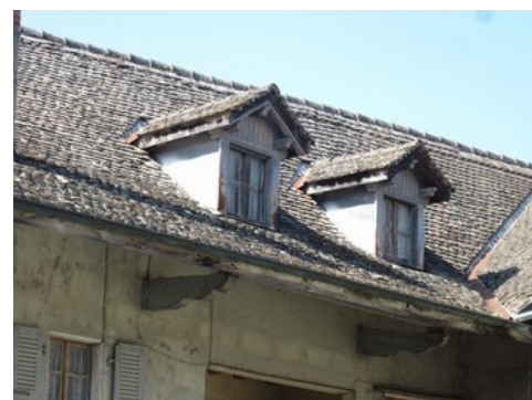
Chablais Toiture en tuiles écaille et lucarnes proportionnées
