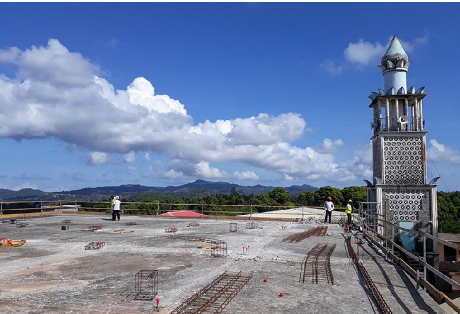
Copyright : DAC Mayotte / Travaux de restauration de la Mosquée de Tsingoni
