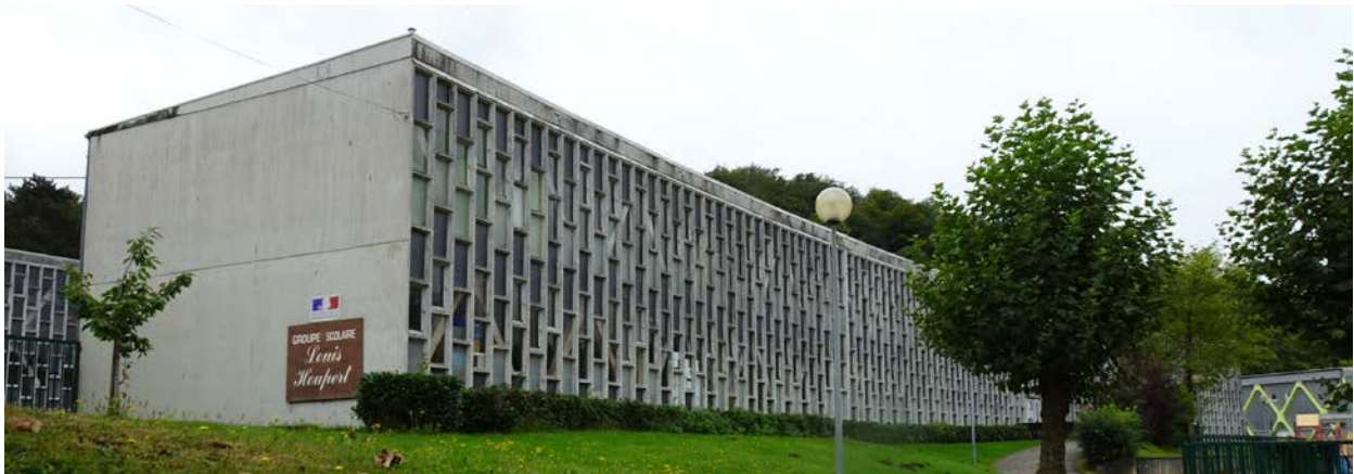
Pignon nord-est et façade nord-ouest
