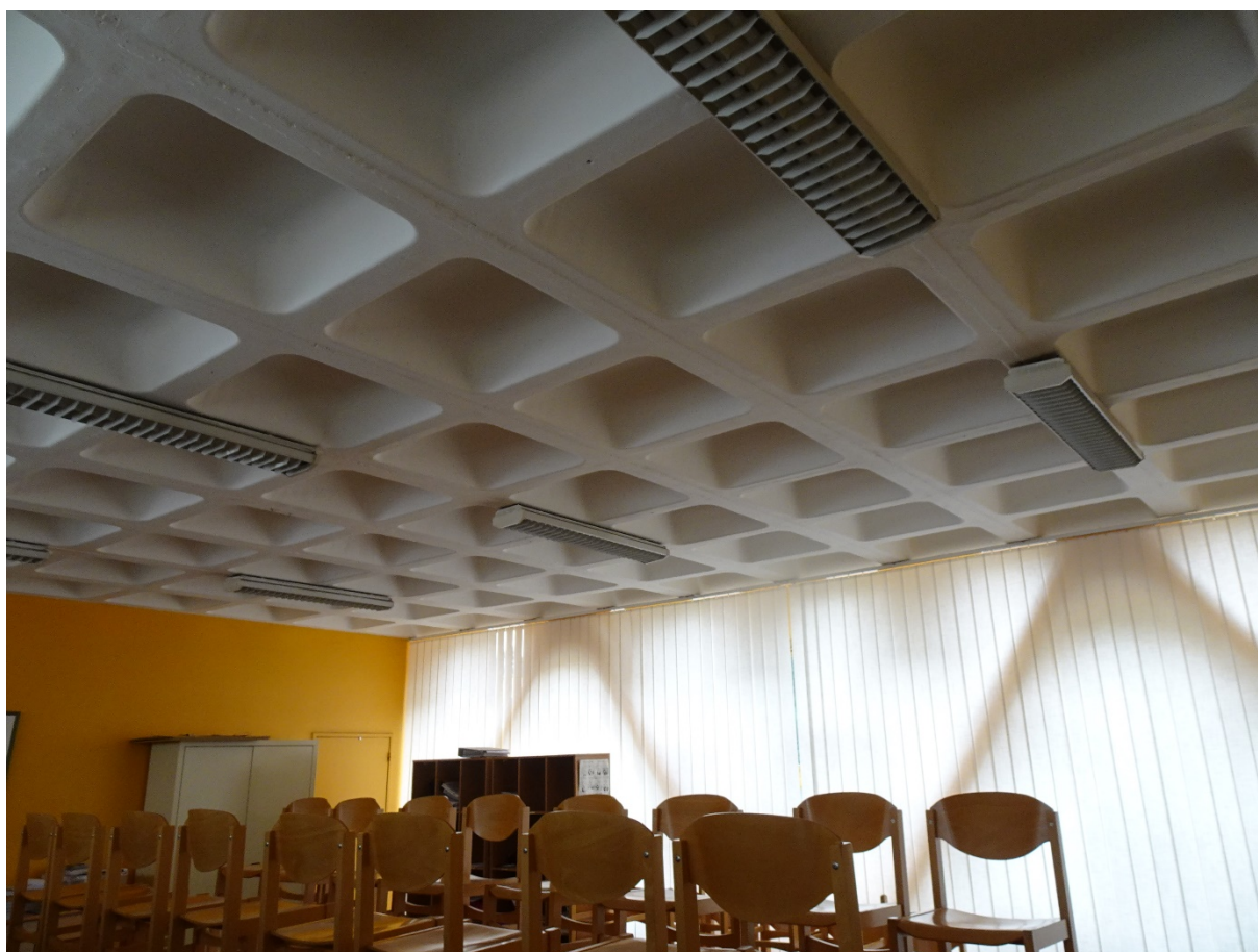
Façade sud-est intérieure
