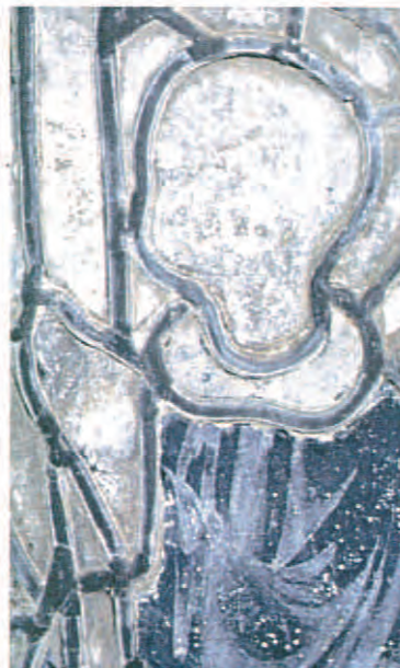
même détail vu en transparence: le verre est complètement opacifié
