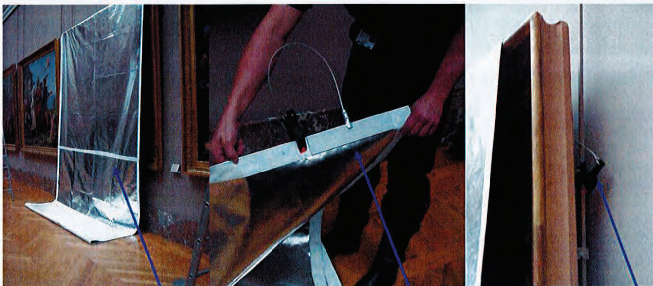
2 panneaux collés par bande velcro
