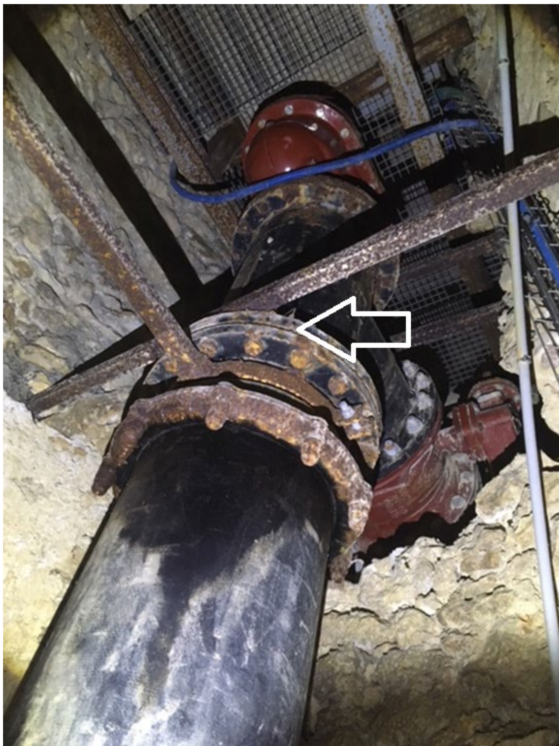
Document n°3 - Conduite verticale de DN 400 mm
