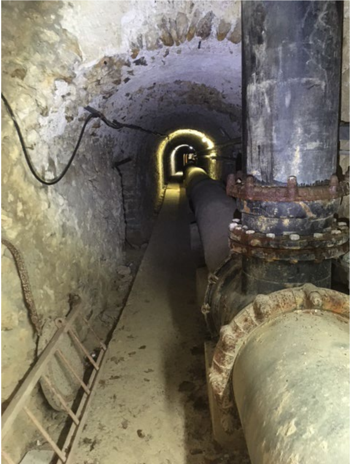
Document n°2 - Zone du té de la conduite DN 600/400 mm
