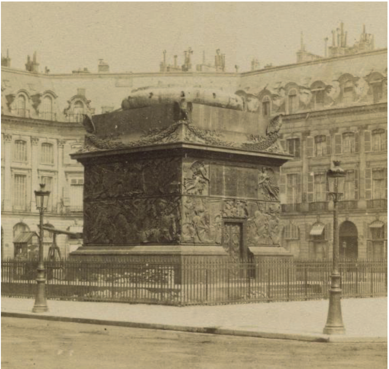
Photo 3 : Piédestal, construit par les architectes Lepère et Gondouin
